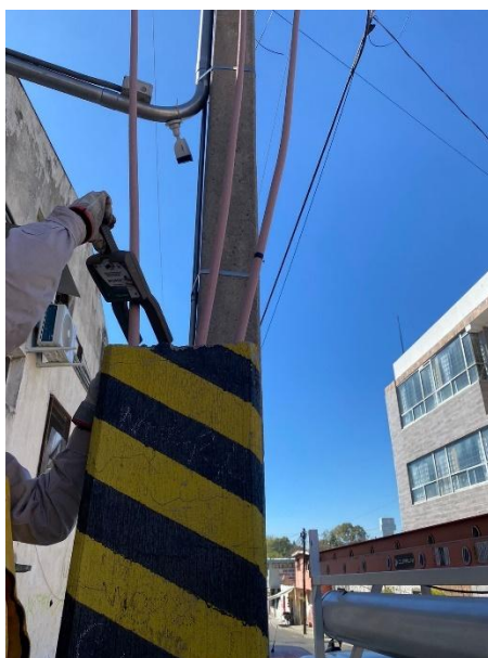
Figura 3. 24. Toma de Cargas en Acometidas
