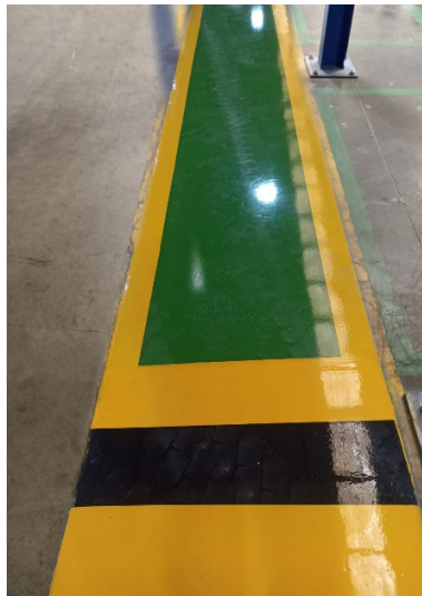
Fig. 9 Restauración de señalética para paso peatonal.
