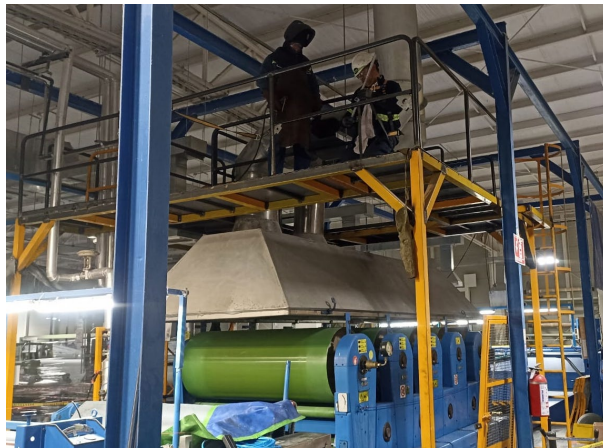
Fig. 8 Instalación de pasamanos en paso de gato para mantenimiento.
