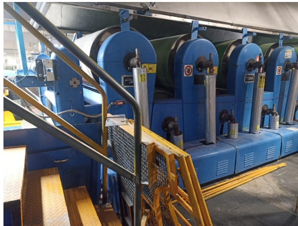
Fig. 6 Retiro de guardas para su mantenimiento.
