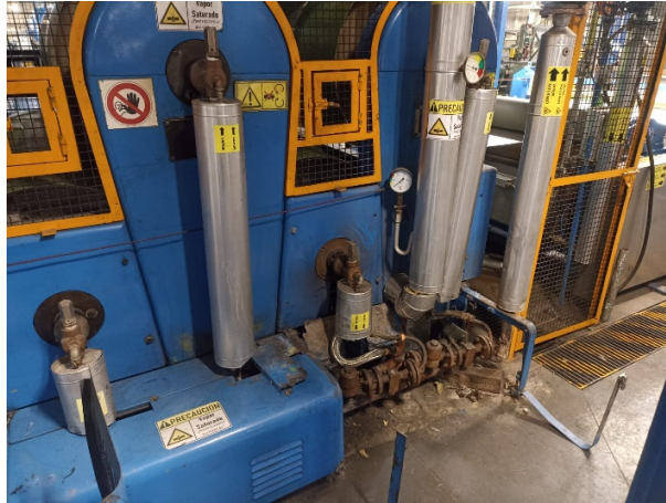
Fig. 7 Mantenimiento a tuberías y sus abrazaderas.
