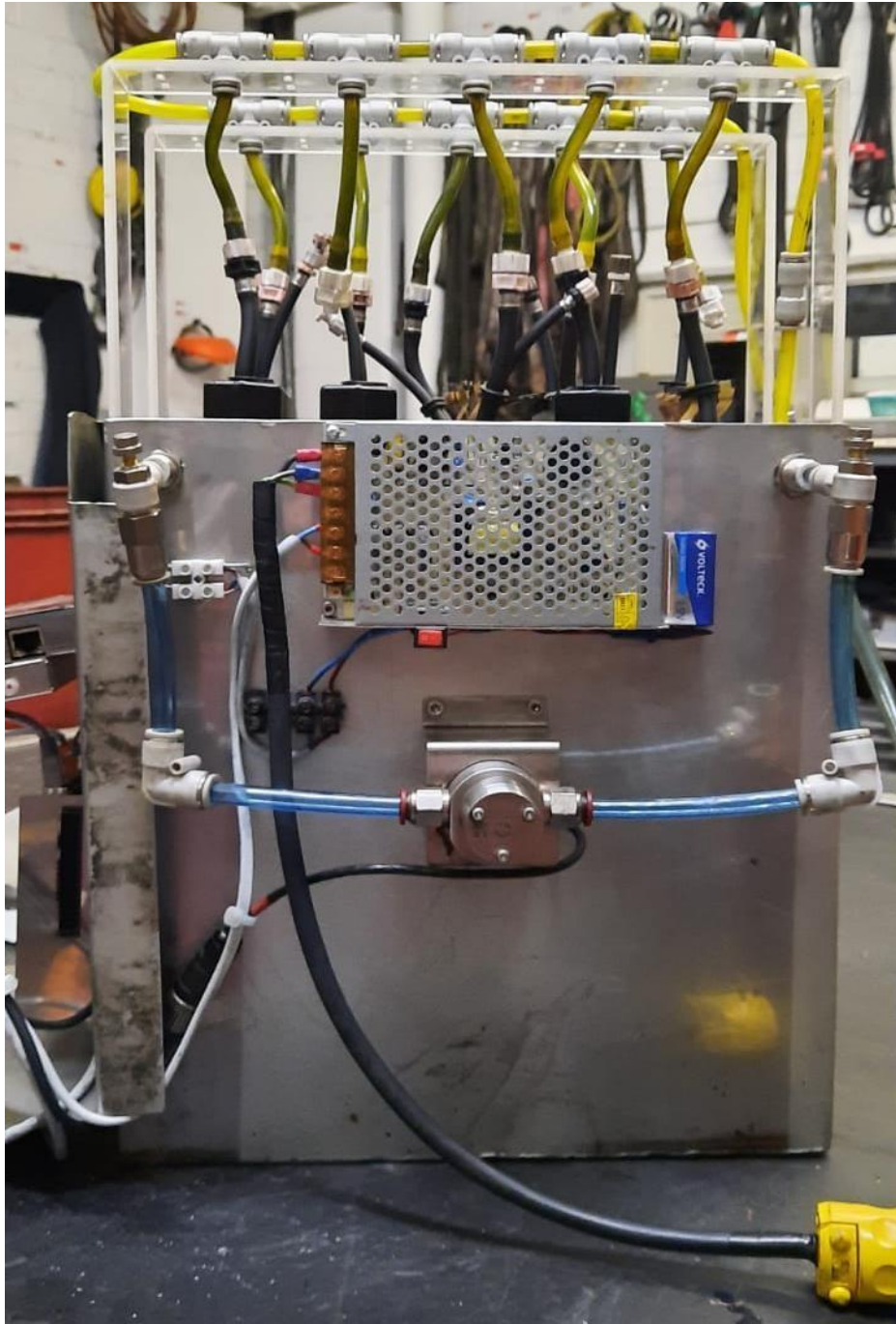
Ilustración 66. Conexiones Terminadas fuente de alimentación y bomba motor serie FG.
