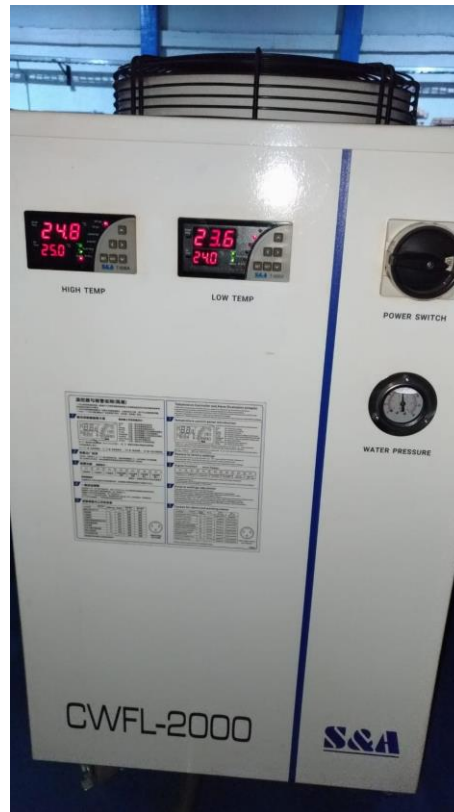
Figura 6. Chiller CWFL-2000 (propiedad de COMETAL).
