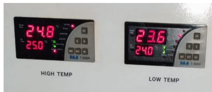
Figura 9. Paneles de control del láser (propiedad de COMETAL).
