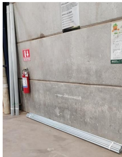
Figura 83 Tubería colocada en una de las áreas para los dispositivos de lectura.
