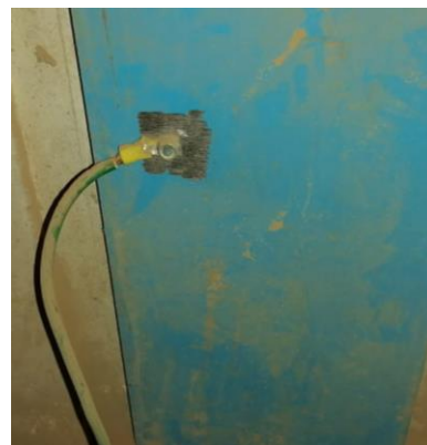
Figura 99 Conexión a tierra temporal para el plc.
