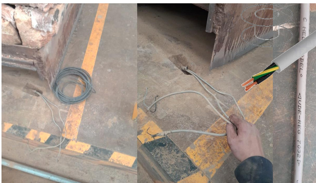
Figura 5.5. Instalación de cableado.
