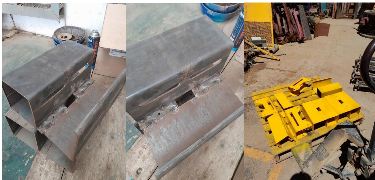
Figura 5.9. Soldadura de unión entre piezas y pintado.
