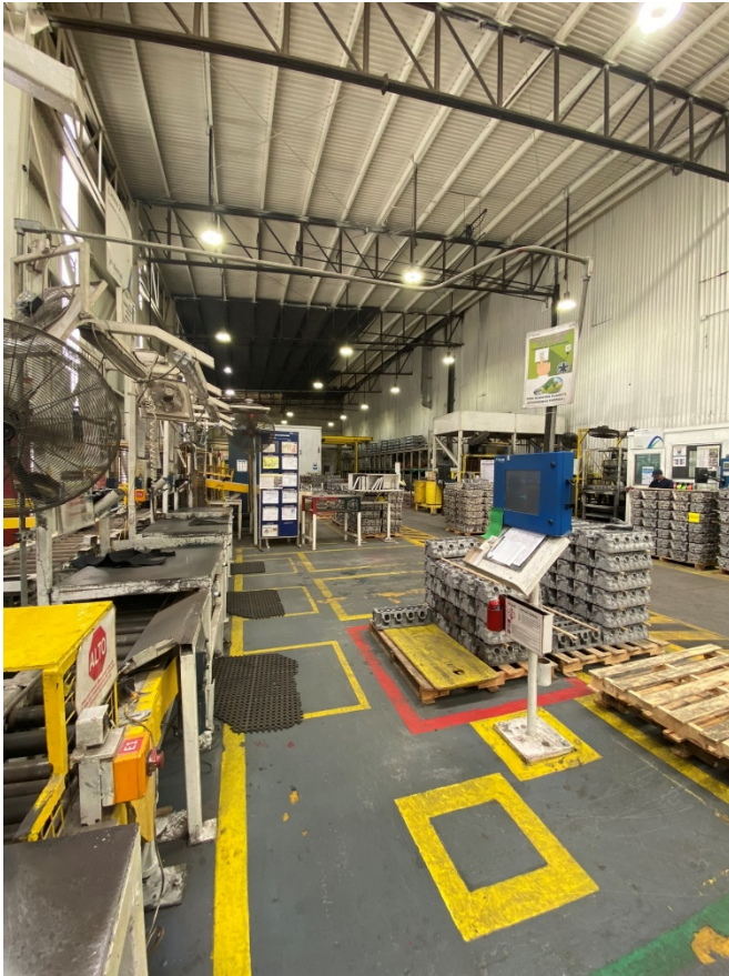
Figura 4.4: Estado actual de rechazos de piezas de manera manual. Cortesía (NEMAK)
