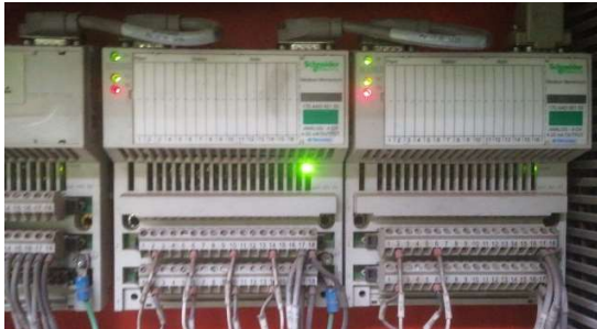
Figura 3.11 (Conexión de PLC a PLC)
