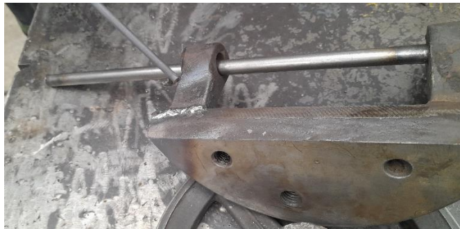
Figura 3.80 Soldadura de piezas dañadas de hierro colado.
