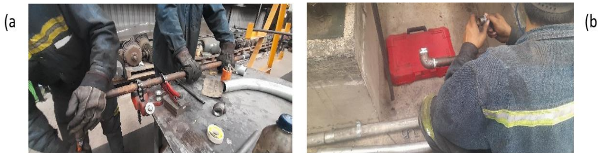
Figura 3.16 Realización de la tubería neumática y conexión de racores.
