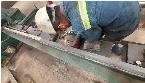
Figura 3.39 Realización de aberturas en el canal de salida.
