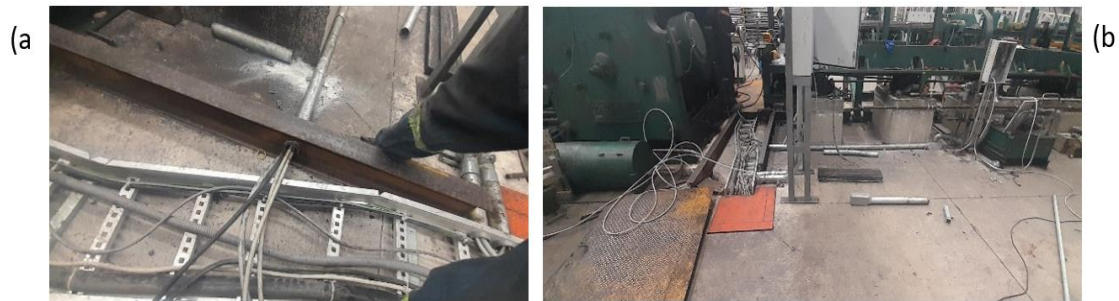
Figura 3.10 Tendido del cableado eléctrico previamente retirado a su nueva ubicación.
