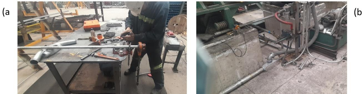
Figura 3.9 Instalación y reubicación de nueva canalización eléctrica.
