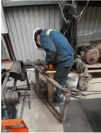
Figura 3.88 Mantenimiento a soporte del tablero de alimentación.
