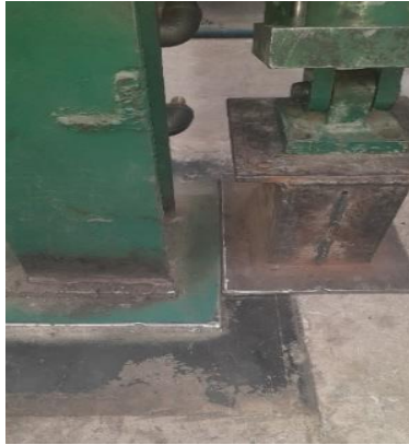
Figura 3.48 Colocación y fijación de pistones soldando la articulación de la base del pistón.
