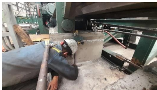
Figura 3.18 Fijación de válvula direccional a base de soporte con racores conectados.
