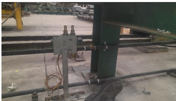
Figura 3.46 Instalación de válvula direccional 4/2 para el control de los pistones.
