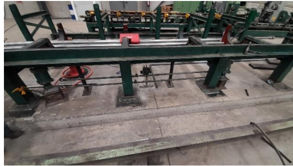
Figura 3.45 Fijación de tuberías neumáticas al canal de salida.
