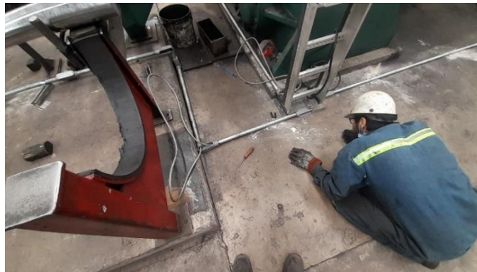
Figura 3.57 Tendido del nuevo cableado eléctrico para el control eléctrico de la salida de la máquina roladora.
