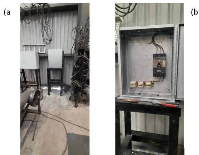
Figura 3.89 Instalación del tablero de alimentación.
