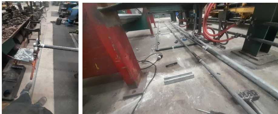
Figura 3.62 Preparación y unión de la tubería neumática para transporte de las salidas de alimentación de la electroválvula a los pitones.
