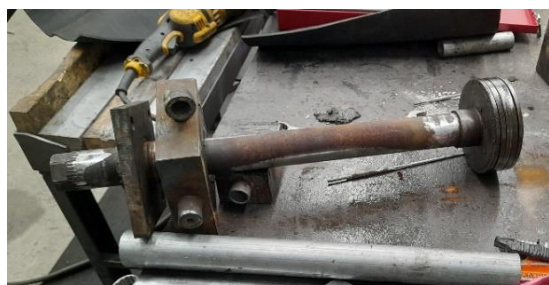
Figura 3.13 Mantenimiento a pistones neumáticos de entrada.
