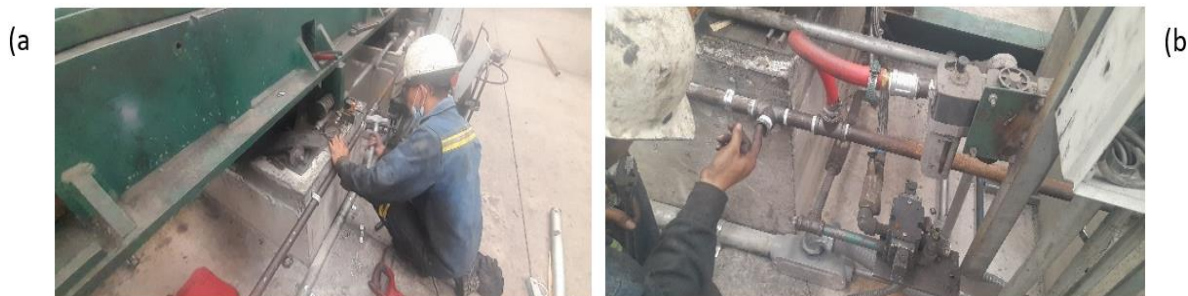
Figura 3.17 Fijación y conexión de la tubería neumática de tipo secundario a la línea de alimentación.
