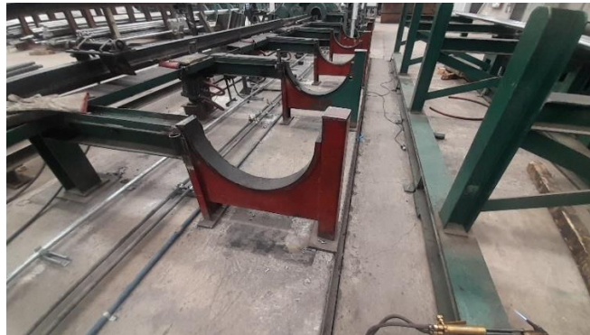
Figura 3.63 Montaje y fijación de tubería neumática para transporte de las salidas de alimentación de la electroválvula a los pistones.
