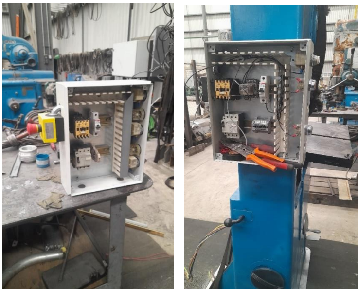
Figura 3.94 Instalación y montaje del tablero de fuerza y control.
