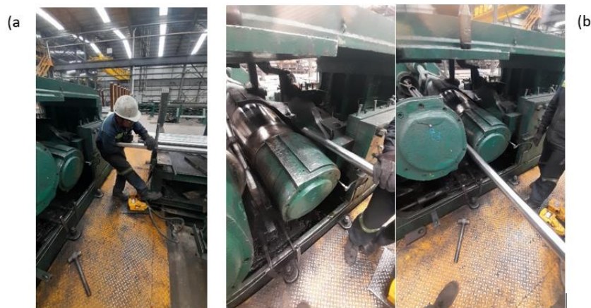
Figura 4.1 Proceso de colocación de barras en el canal de entrada.
