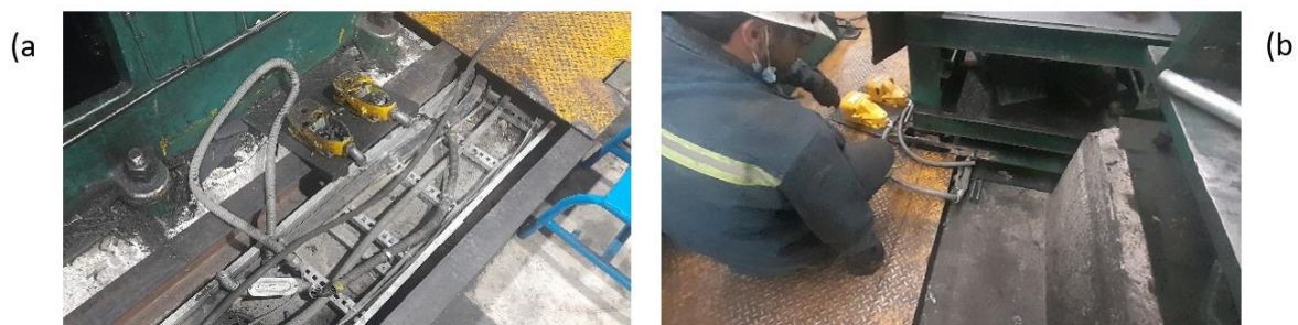
Figura 3.11 Cambio de accionamientos de pedal mostrando el estado en que se encontraban y después de haber sido reemplazados.
