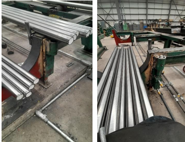
Figura 3.66 Colocación y fijación de base de pistones al final de la bancada de salida.
