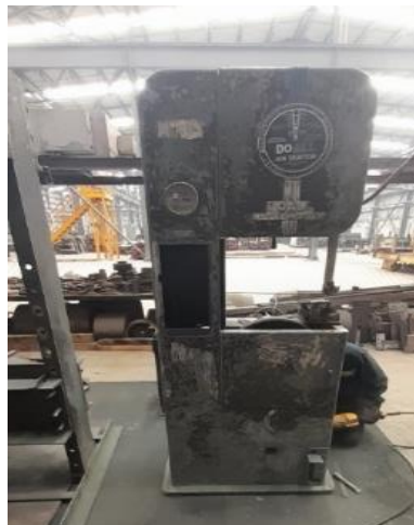
Figura 3.84 Limpieza interna y raspado de pintura corroída.
