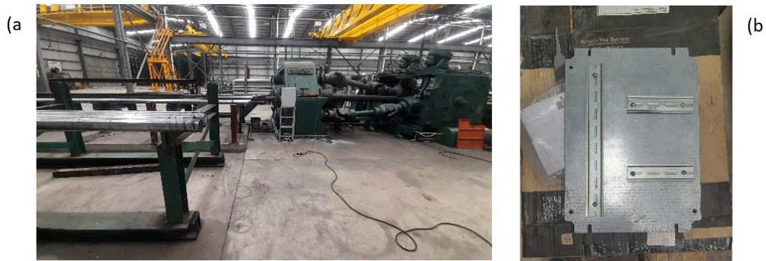
Figura 3.55 Colocación de tablero de control en la base de soporte e instalación de componentes.
