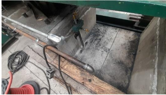
Figura 3.28 Instalación de válvula direccional 5/2 para el control del pistón.
