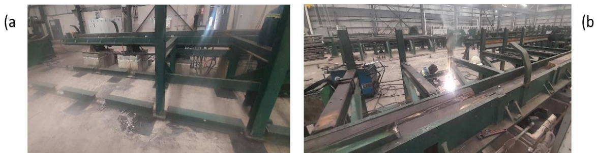
Figura 3.12 Colocación y fijación de bancada de entrada.
