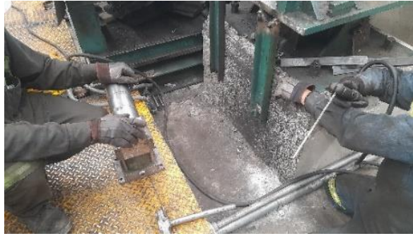
Figura 3.19 Fabricación de base para pistón de levantamiento de barras al final del canal de entrada.
