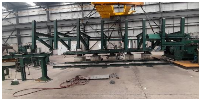
Figura 3.4 Separación de bancada de entrada y la parte fija al suelo.
