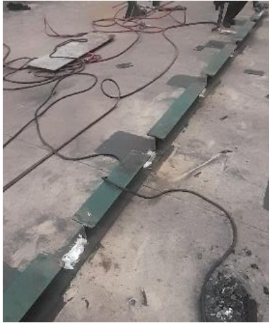
Figura 3.5 Esmerilado de las zonas afectadas por el proceso de oxicorte.
