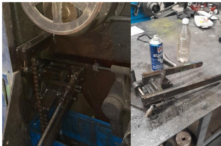
Figura 3.78 Limpieza del mecanismo de contrapeso.
