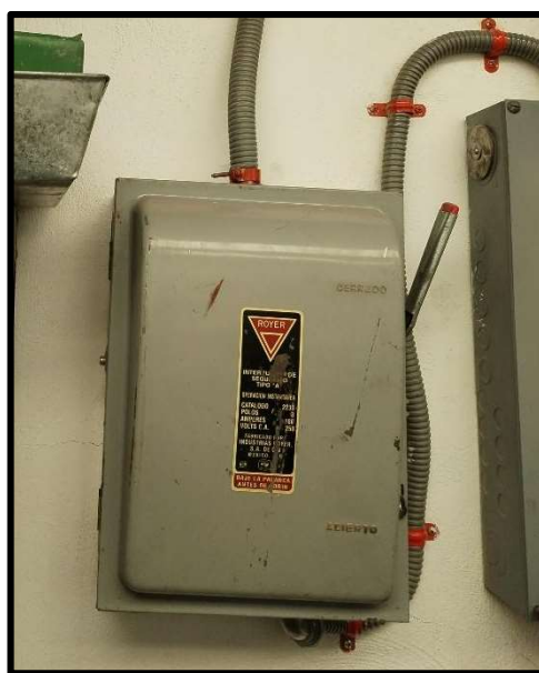
Figura 8 Traslado de Conductores mediante Licuatite 2023 [Fuente propia 2023]
