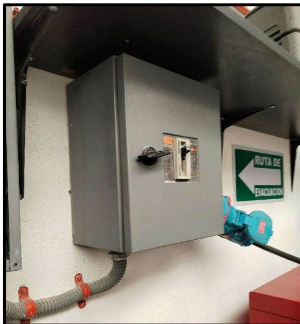
Figura 63 Instalación de ITM para máquinas de soldar IEA [Fuente propia 2023]
