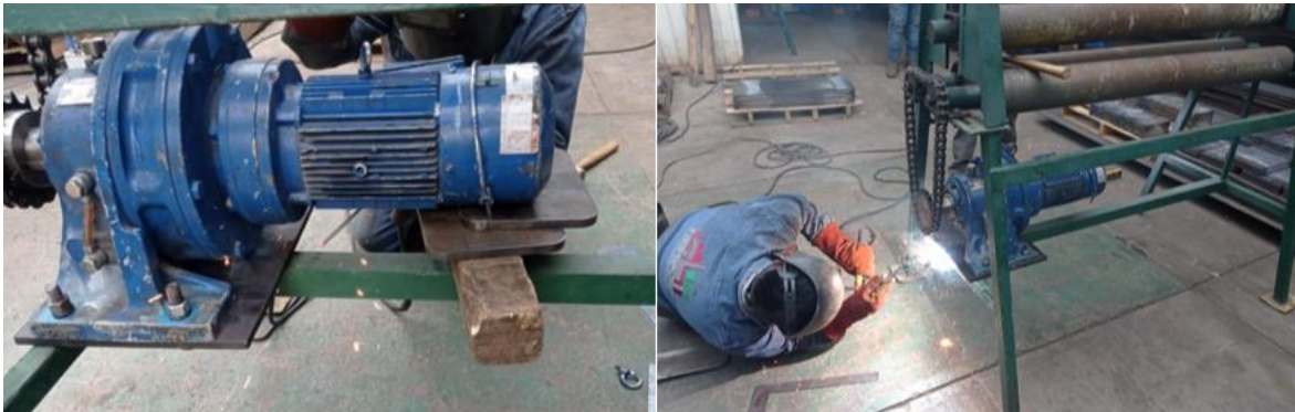
Ilustración 76. Nivelación y fijación del motoreductor. (Fuente propia)
