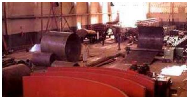
Ilustración 12. Fabricación de cilindros para tanques. (Fuente: http://www.ferremaq.com )
