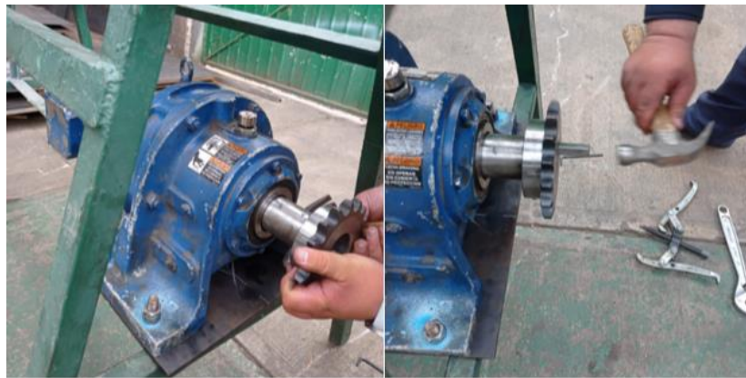
Ilustración 74. Montaje del motoreductor y colocación del sprocket en su eje de salida. (Fuente propia)
