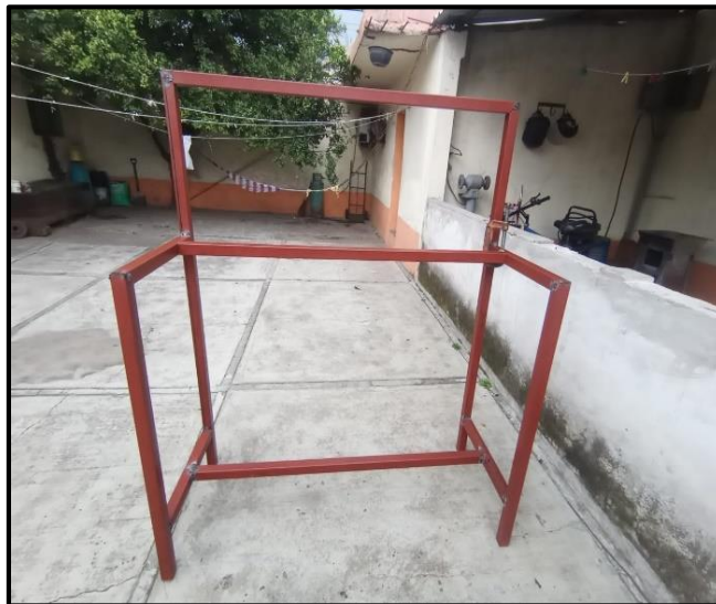
Imagen 2.13 Estructura casi terminada
