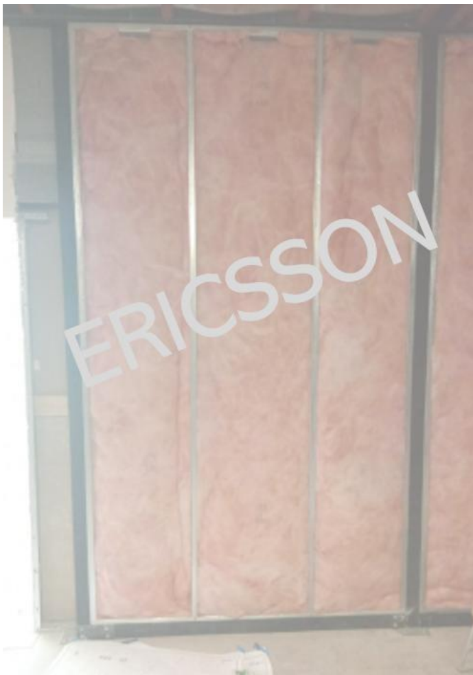
Se colocó recubrimiento en las paredes para los MDF1 y MDF2
