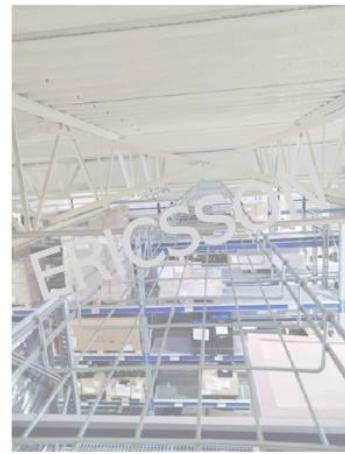
Canalización para CCTV con charola tipo malla en área de almacén
