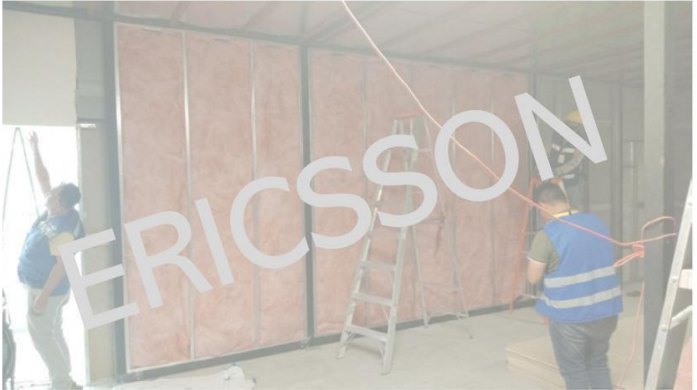
Se colocó recubrimiento en las paredes para los MDF1 y MDF2
