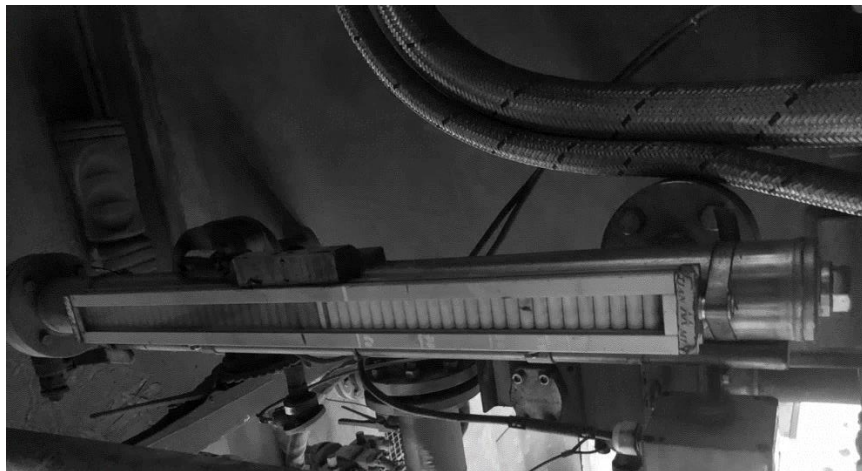
Figura 17 Instalación de switches electromagnéticos y medidores magnéticos de nivel. Fuente: Elaboración propia.
