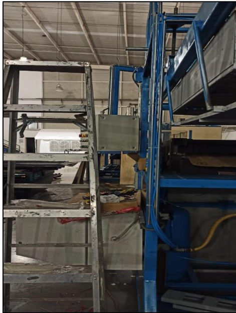
Figura 3.44. Colocación de mangueras en riel.
