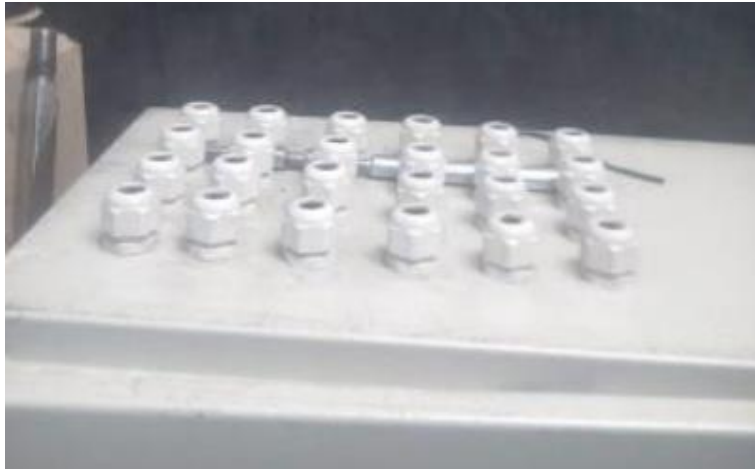
Figura 3.33. Colocación de conectores tipo glándulas para cableado.
