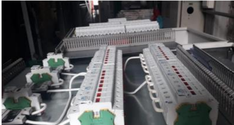
Figura 3.35. Porta fusibles para resistencias de forma independiente y por zona.
