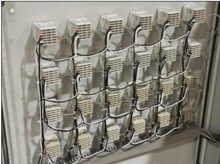
Figura 3.36. Tablero de controladores terminado.
