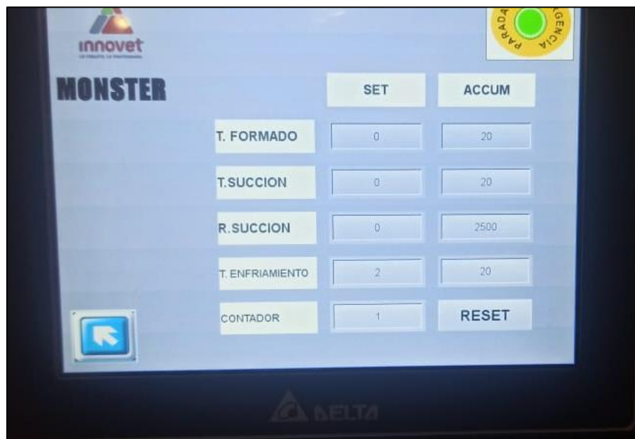
Figura 5.9. Temporizador de Tiempo de enfriado.
