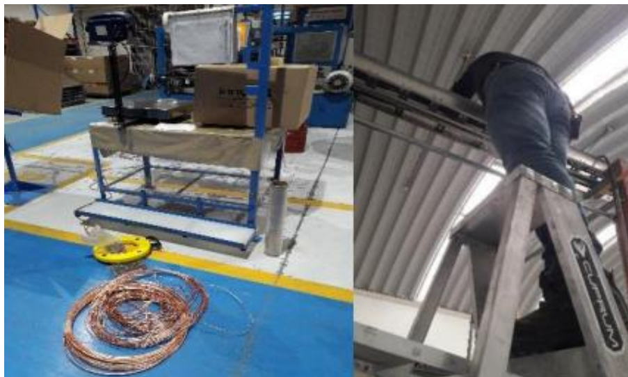
Figura 3.15. Colocación de cableado a canaletas y tubo.
