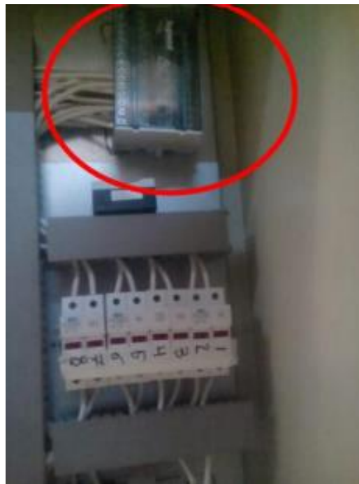
Figura 3.34. Conexión de repartidor y porta fusibles.
