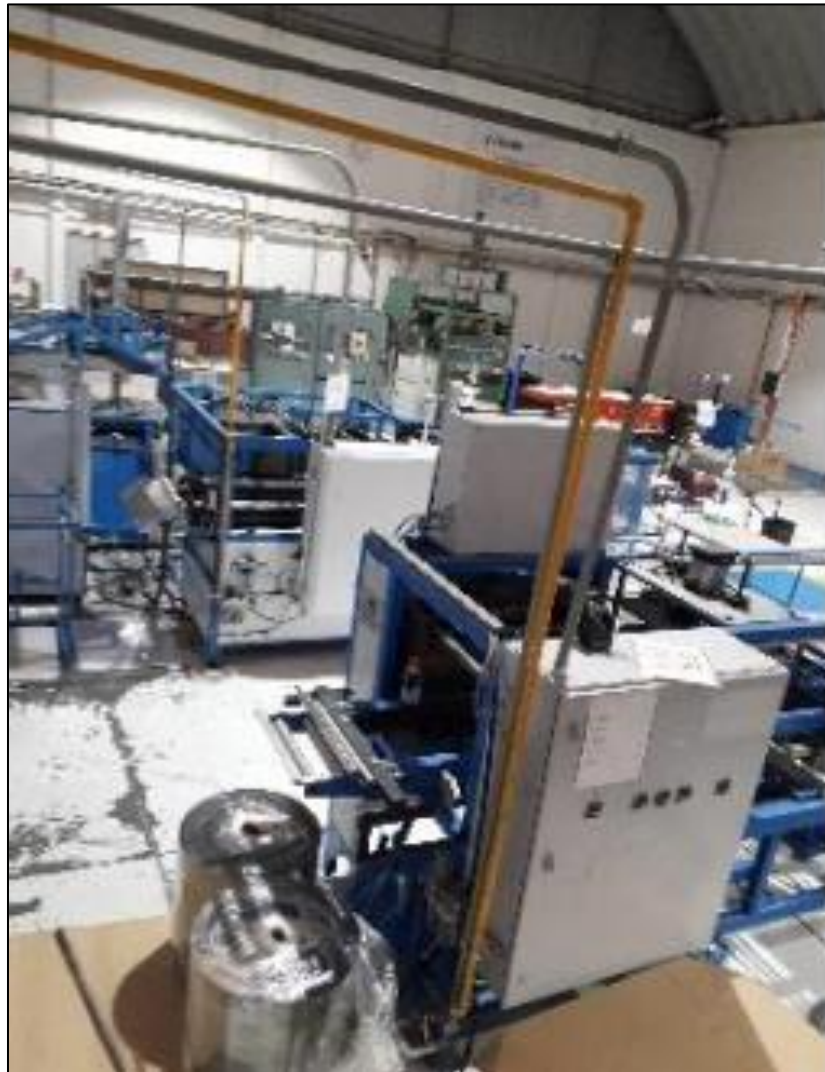
Figura 3.17. Tierra física dentro del tubo que llega en la parte superior del tablero.
