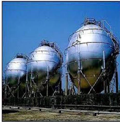
(b) Tanque de geometría esférica
