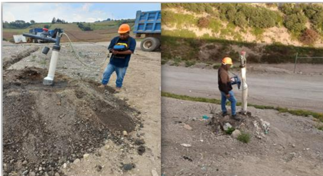
Figura Al.4 Mediciones de biogás en pozos de venteo
