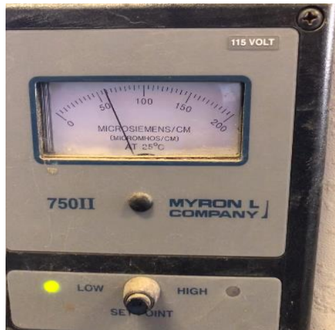
Figura 54 Módulo de osmosis (Elaboración propia).
