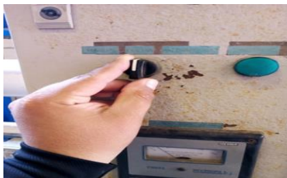
Figura 48 Modulo de osmosis inversa (Elaboración propia).
