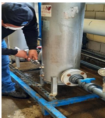
Figura 23 Dren del tanque pulidor (Elaboración propia).
