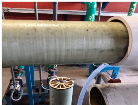
Figura 52 Membranas de osmosis (Elaboración propia).
