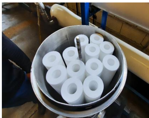
Figura 29 Colocación de filtros nuevos (Elaboración propia).
