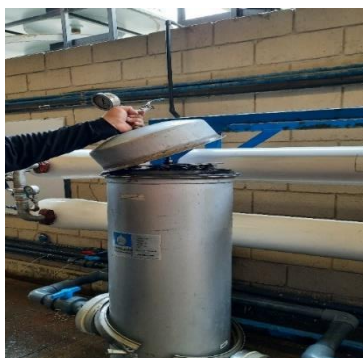
Figura 26 Sujetadores de los filtros (Elaboración propia).
