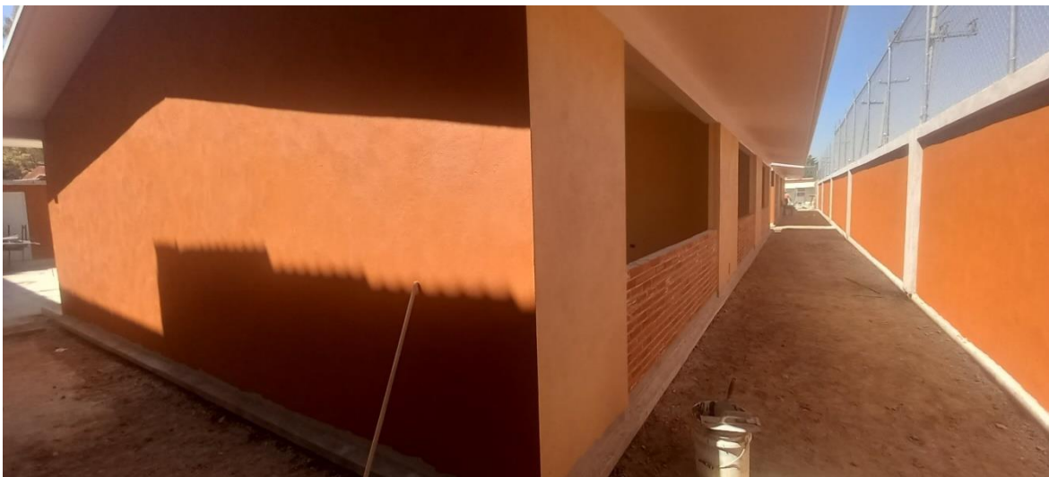
Figura 83. Pintura acrílica en aulas y barda perimetral.
