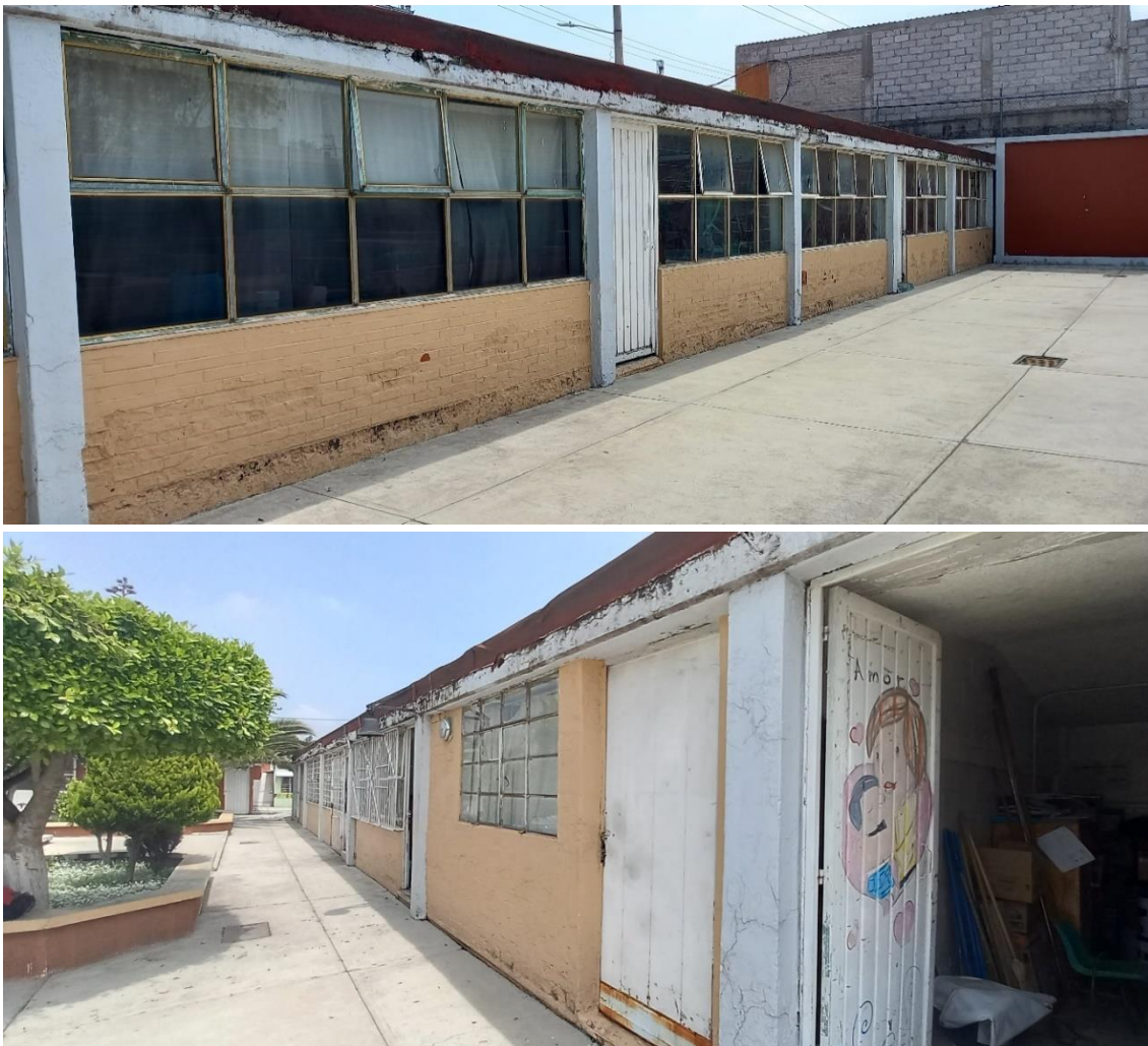
Figura 24. Edificios antes de ser demolidos.
