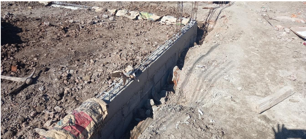
Figura 58. Muro de enrase y cadena previamente descimbrado.
