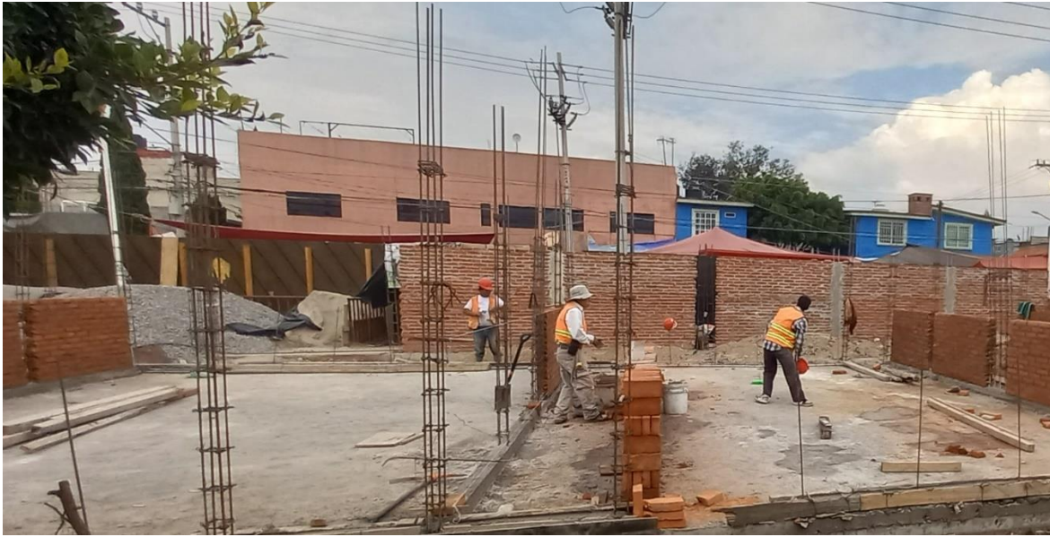
Figura 59. Firme de concreto.
