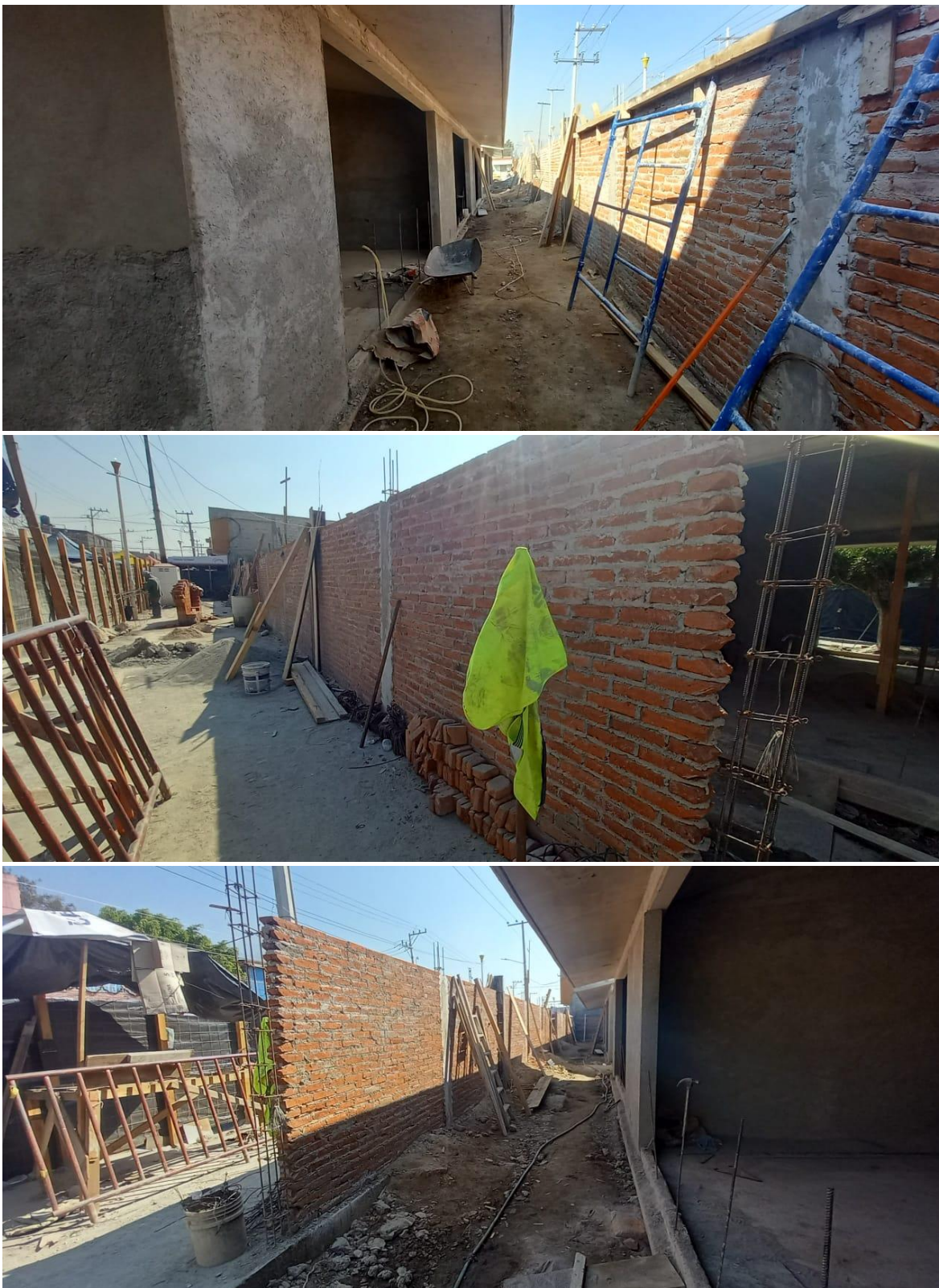
Figura 76. Barda perimetral en proceso.
