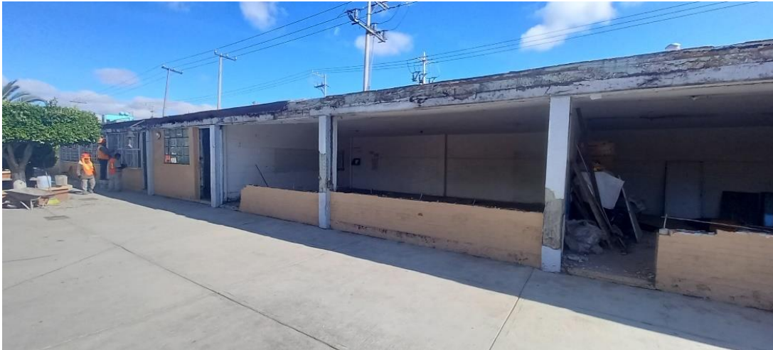
Figura 33. Demolición de muro de tabique.
