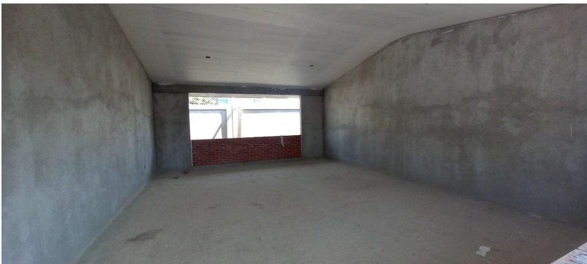
Figura 79. Muro en fachada posterior, con block hueco de barro prensado.
