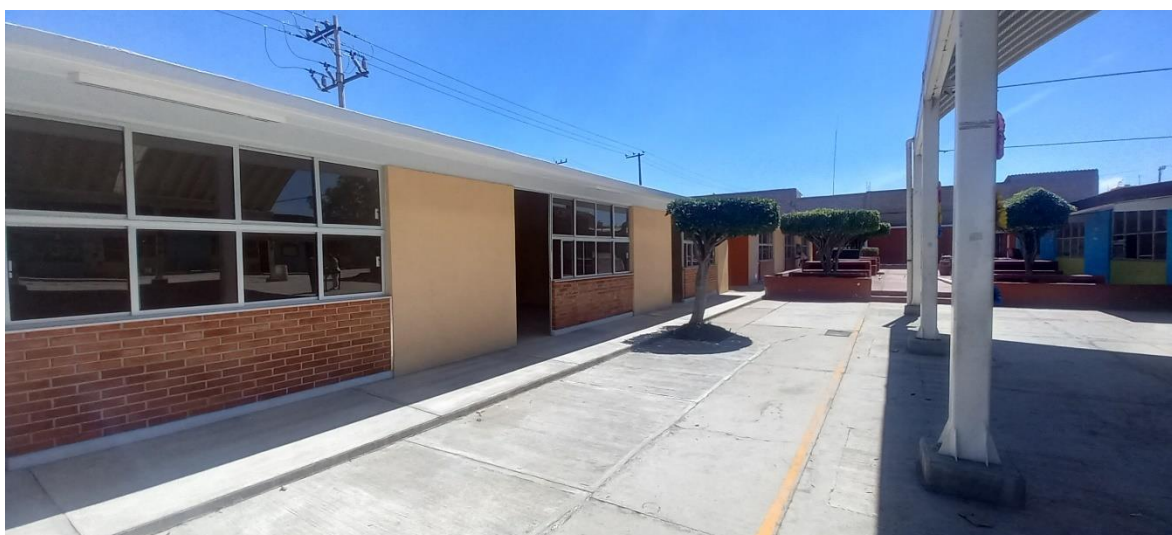
Figura 95. Resultado de la obra terminada al 100%.
