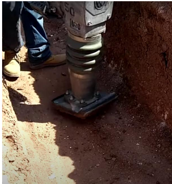
Figura 45. Compactación con vibro compactadora.
