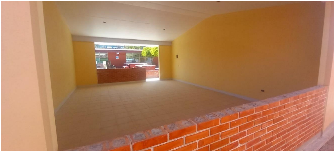
Figura 82. Pintura acrílica en interior de aulas y plafones, y loseta cerámica.
