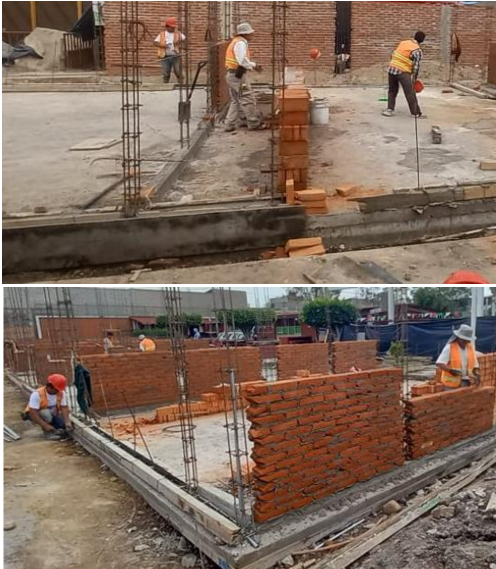
Figura 62. Colocación de zoclo.
