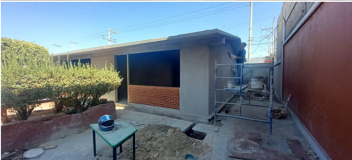
Figura 78. Muro en fachada principal, con block hueco de barro prensado.
