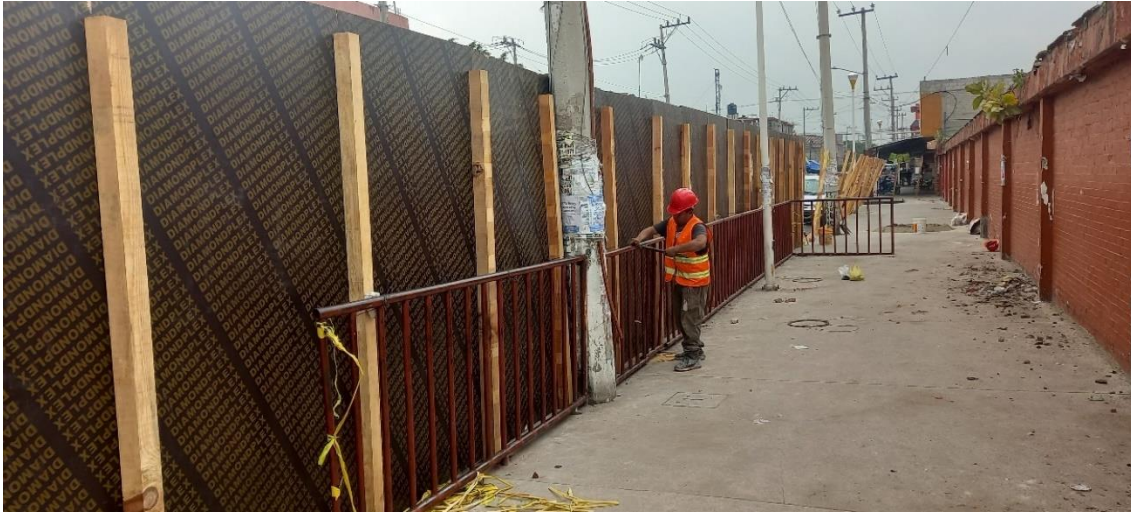
Figura 25. Colocación de tapial alrededor de la barda que será demolida.
