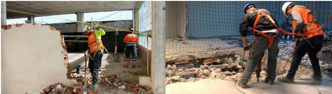
Figura 13. Ejemplo de demolición manual.
