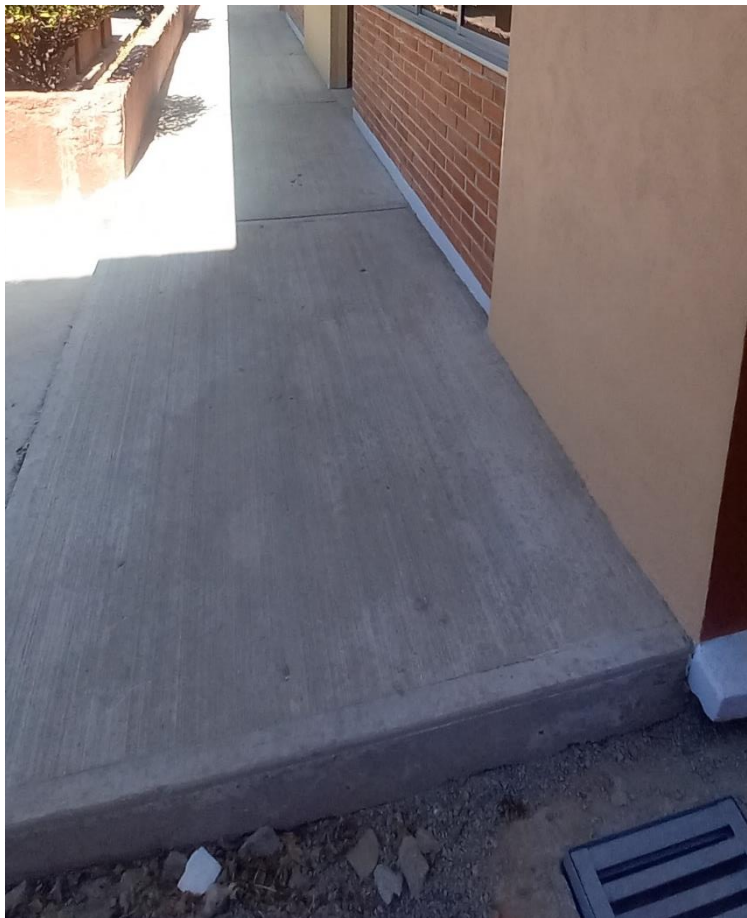
Figura 87. Concreto en piso fraguado.
