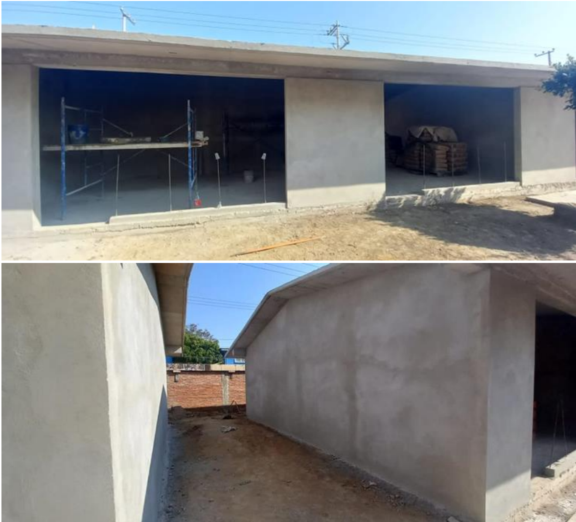
Figura 75. Aplanado en exteriores de edificios.
