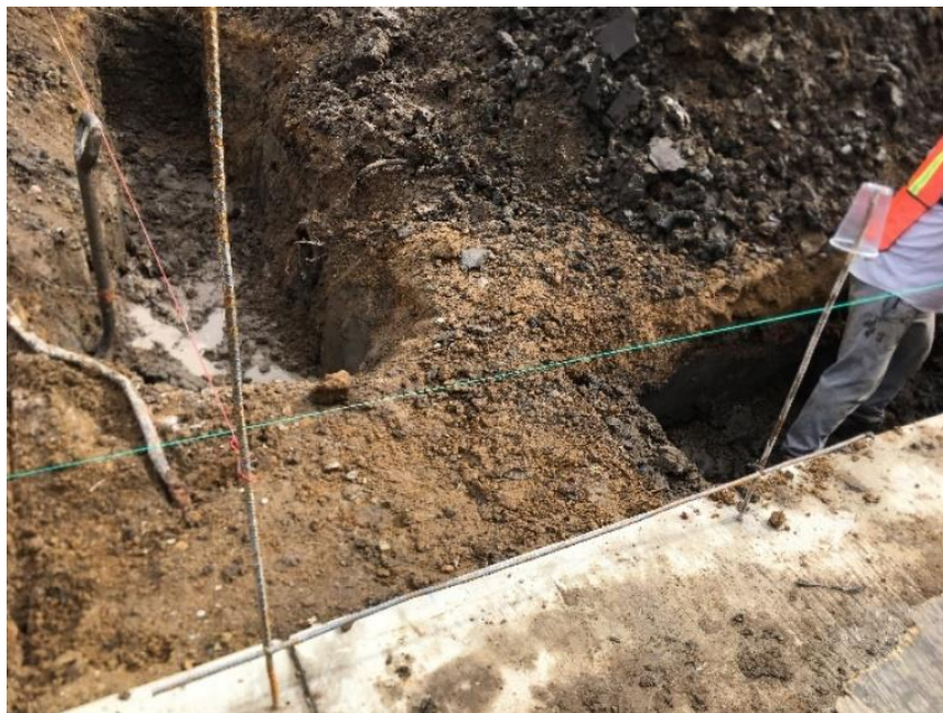
Figura 42. Varilla con hilo marcando el eje.
