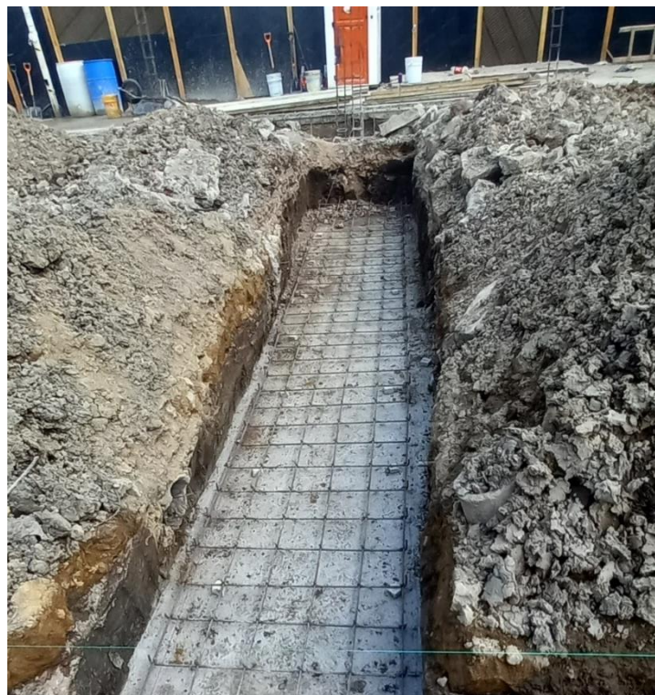
Figura 53. Armado de base de zapata tipo Z-3.
