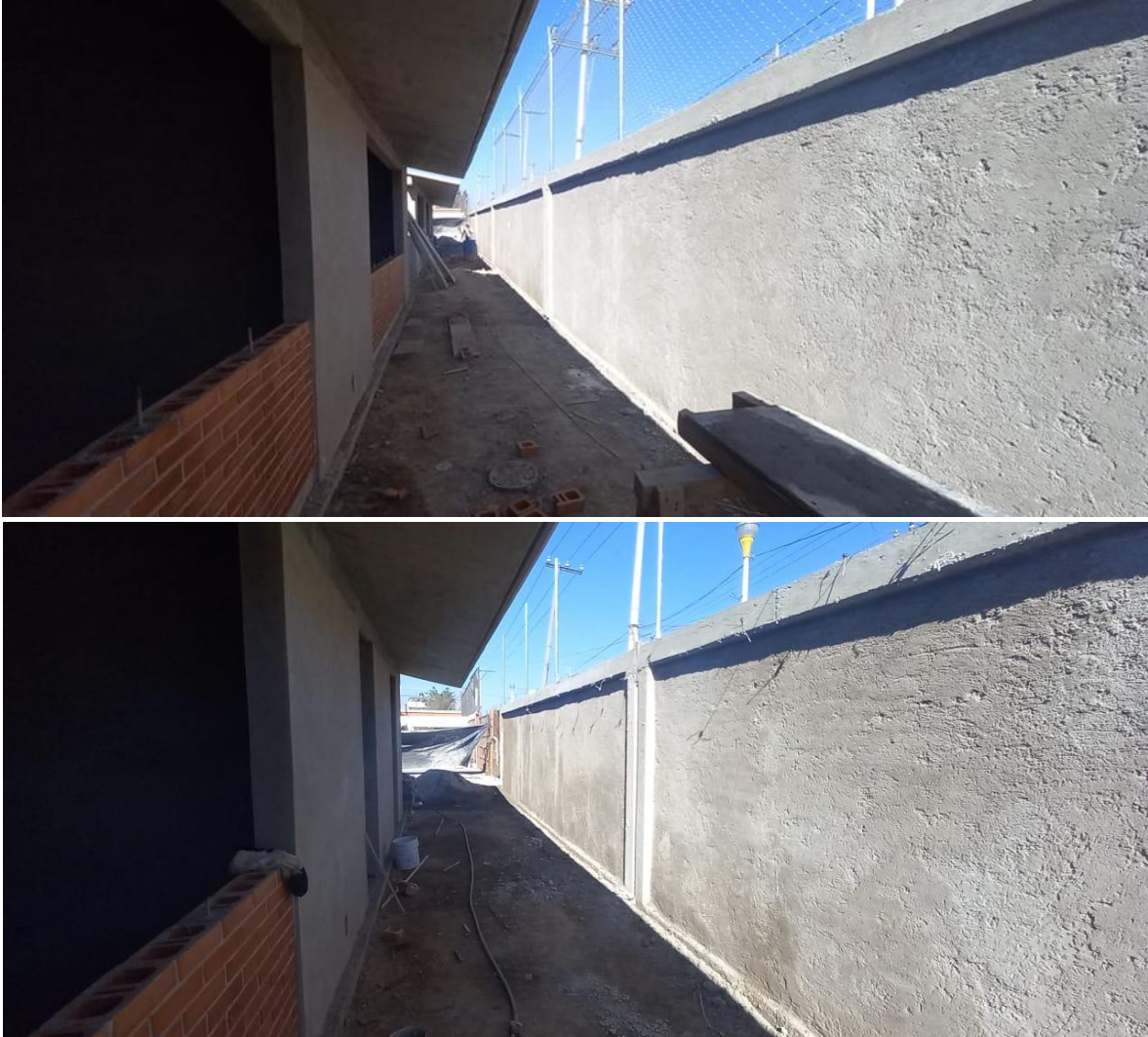
Figura 77. Barda perimetral con aplanado y malla tipo ciclón.
