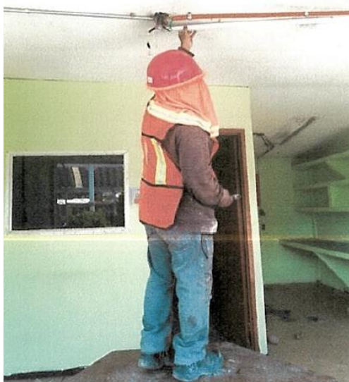
Figura 29. Desmantelamiento de instalación eléctrica.
