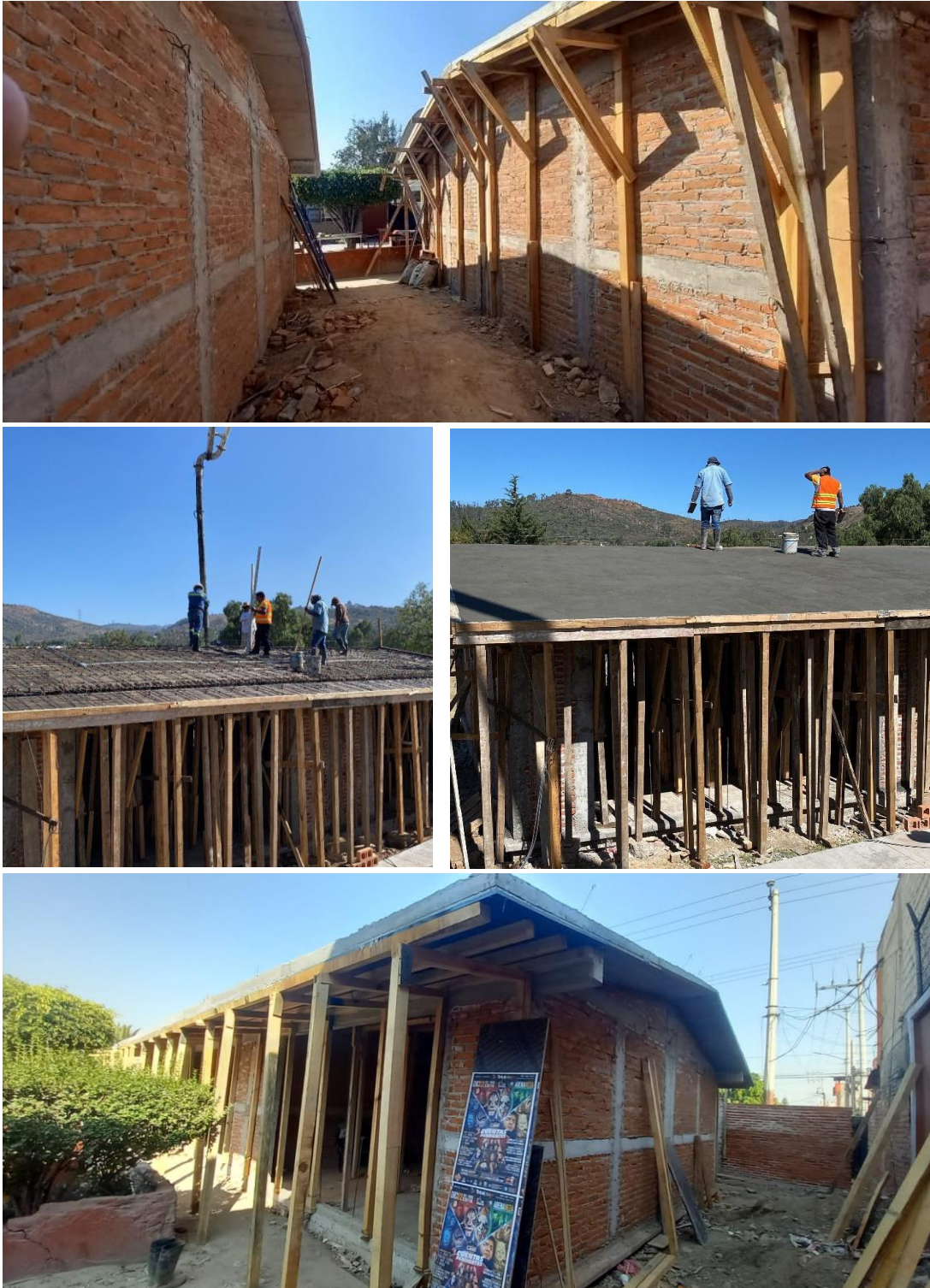
Figura 73. Colado de losa de azotea y retiro de cimbra.
