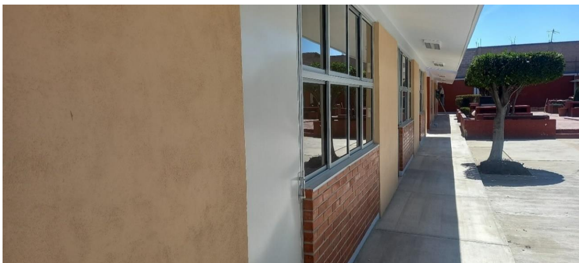
Figura 93. Colocación de puertas en aulas.
