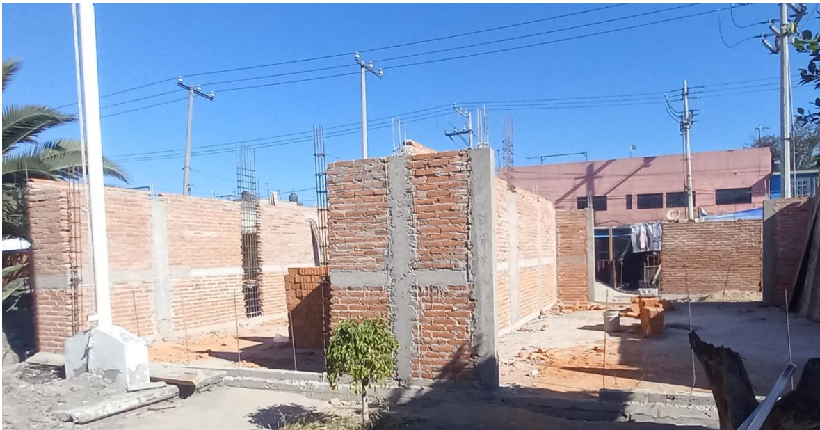
Figura 69. Detalle de estructura en fachada principal (sin muro central).
