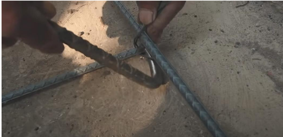
Figura 54. Unión de acero de refuerzo con alambre recocido.
