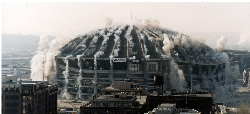
Figura 15. Ejemplo de demolición con explosivos.
