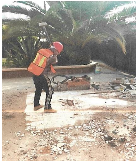
Figura 37. Demolición de piso de cerámica.
