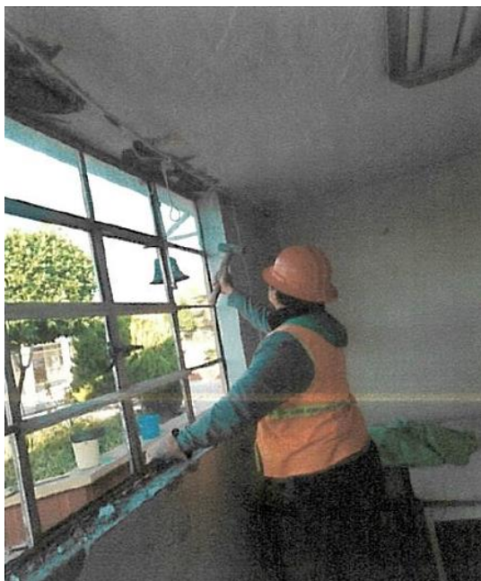
Figura 27. Desmantelamiento de cancelería.
