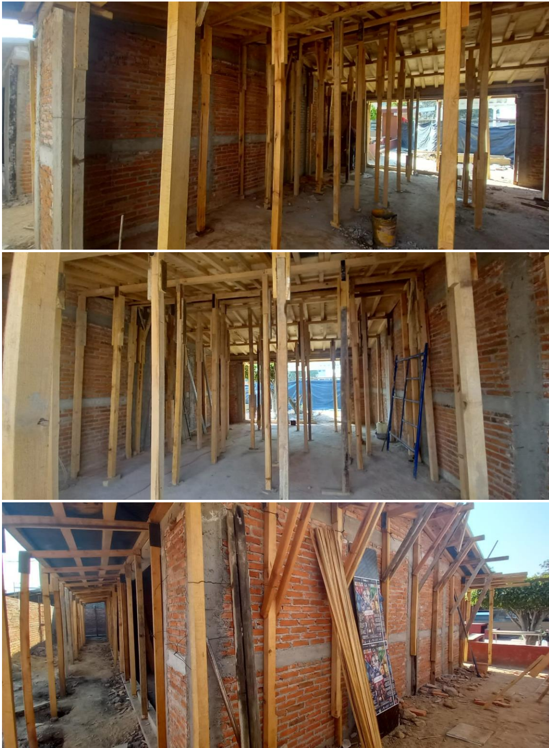
Figura 72. Cimbrado para losa en azotea.
