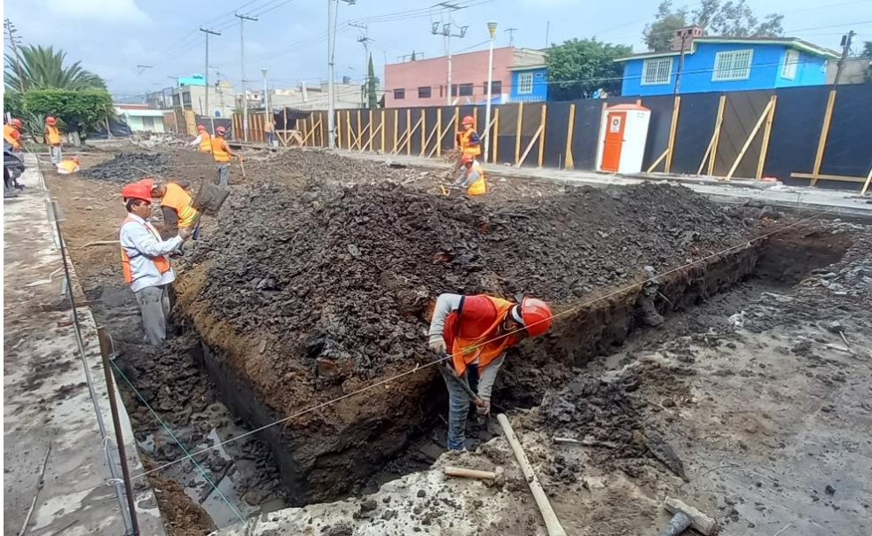
Figura 41. Trazado y nivelación de aulas.
