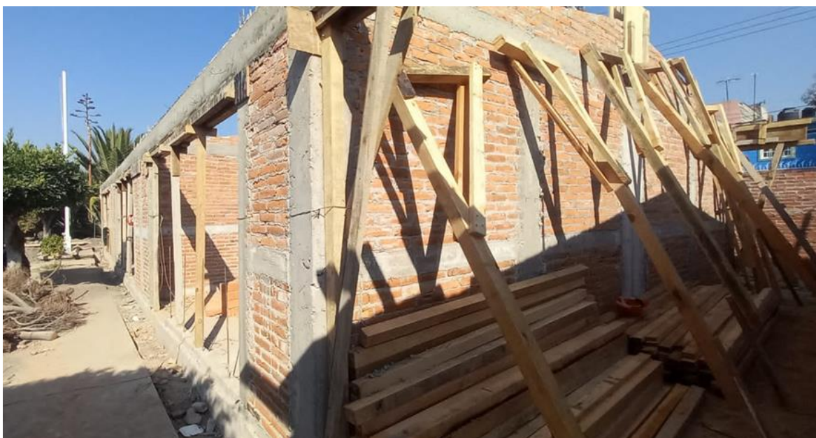
Figura 67. Estructura de muros y castillos terminados.
