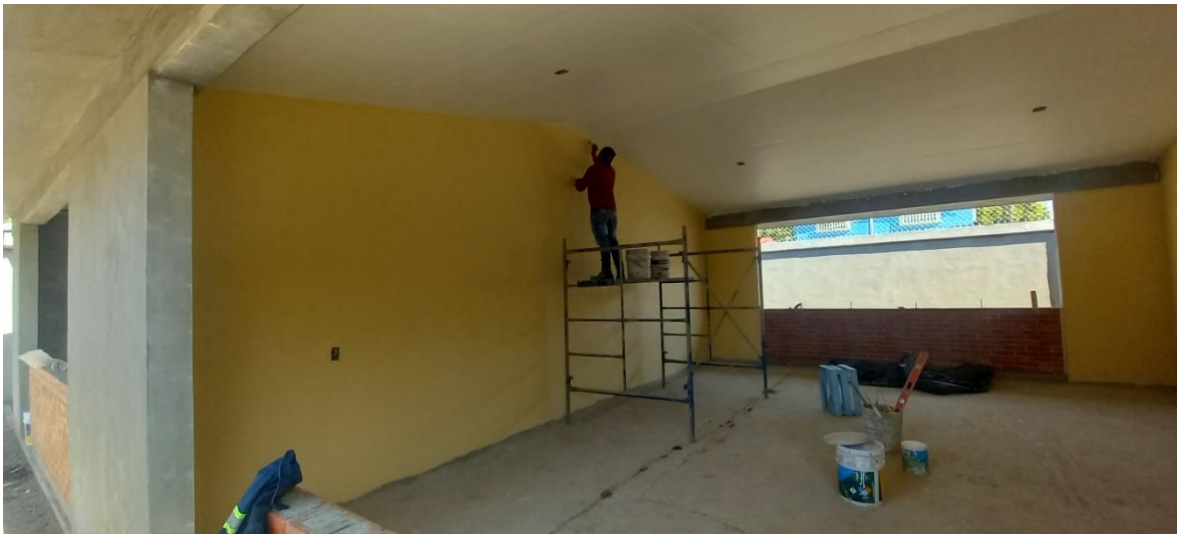
Figura 80. Pintura acrílica en aulas y plafones.
