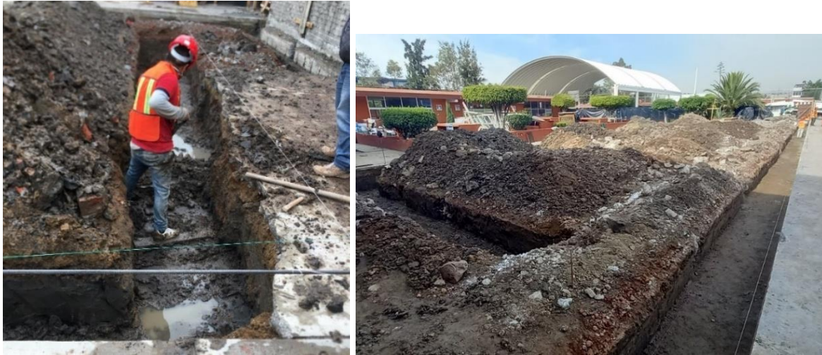
Figura 44. Excavación y compactación en zanja.
