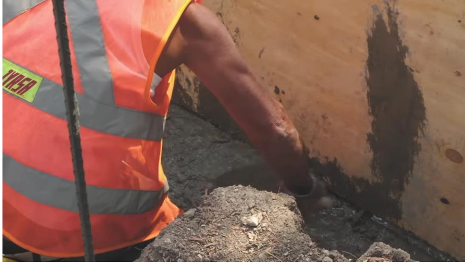
Figura 57. Colocación de cimbra.
