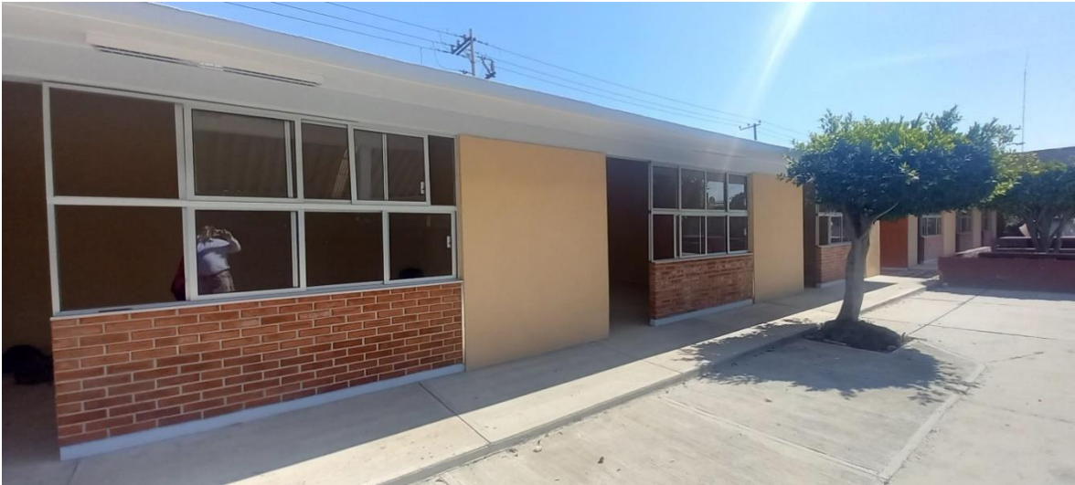
Figura 90. Ventanas tipo “B” en fachada.
