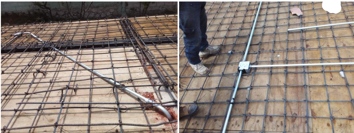
Figura 71. Armado de losa de azotea.
