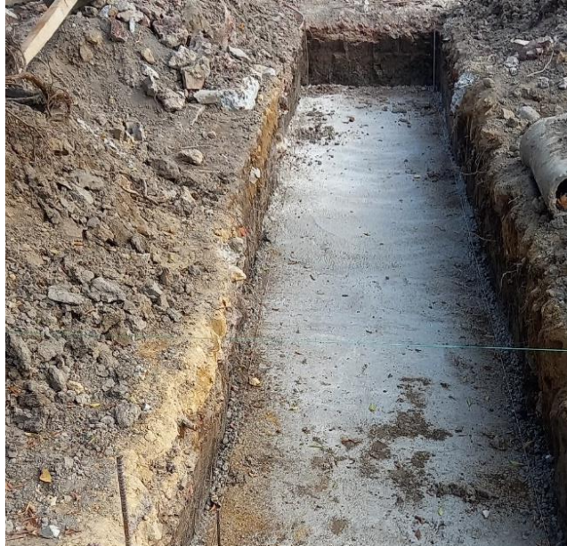
Figura 46. Colocación de plantilla de concreto pobre.
