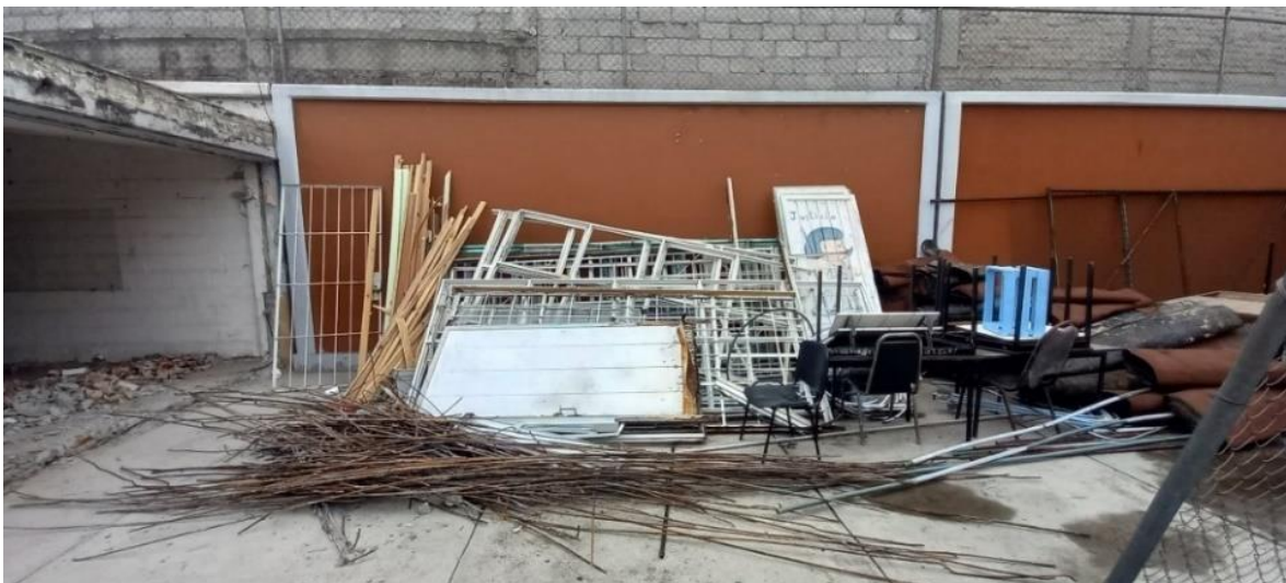
Figura 32. Productos del desmantelamiento.
