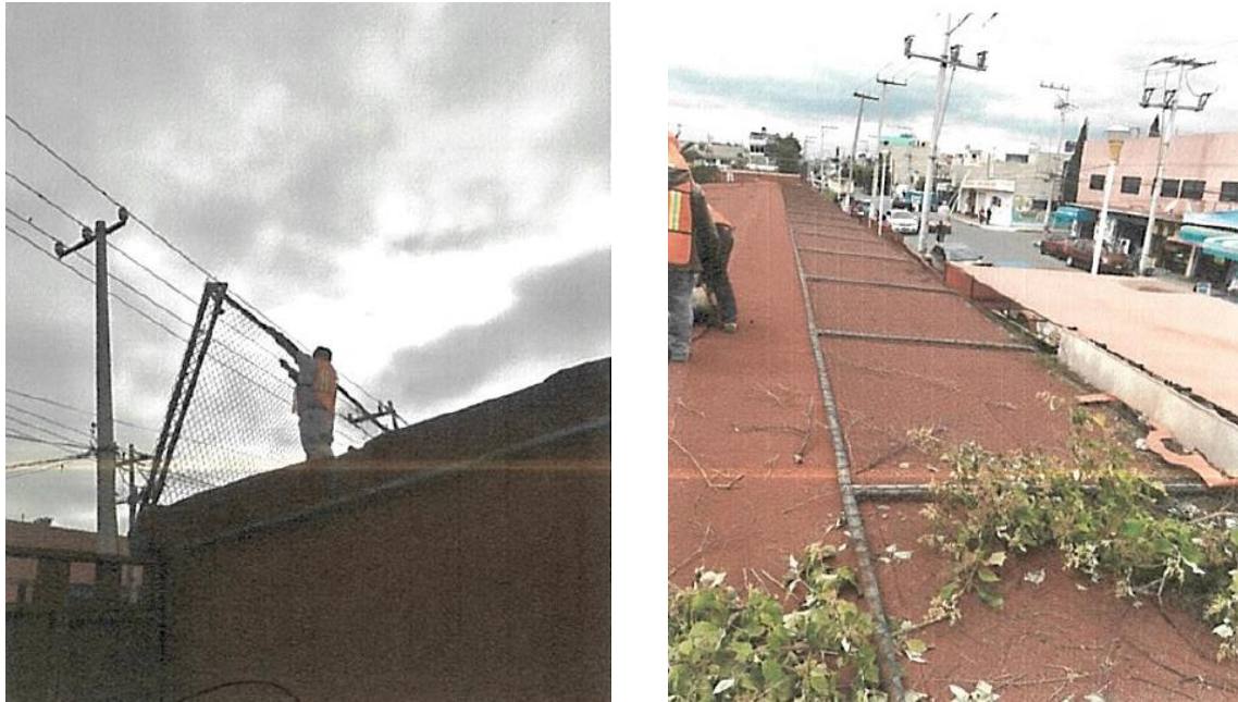
Figura 31. Desmantelamiento de malla ciclónica.
