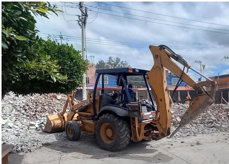
Figura 34. Retroexcavadora CASE 580 M con martillo hidráulico.
