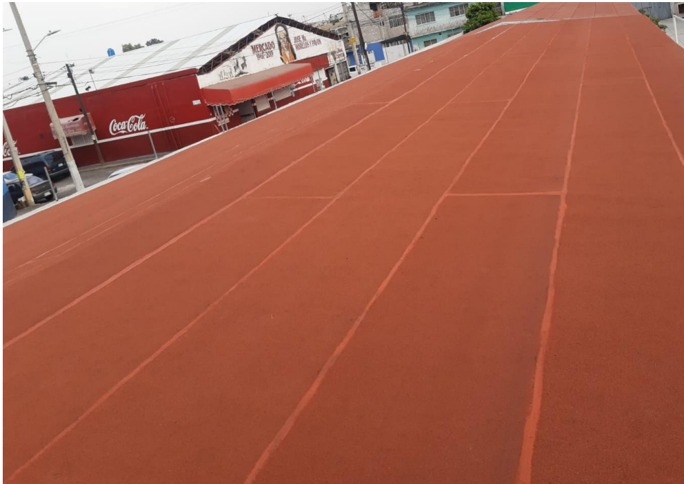
Figura 94. Colocación de impermeabilizante modificado (SBS).
