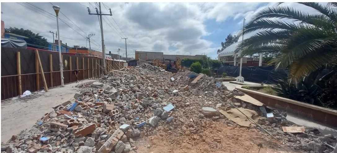
Figura 35. Producto de demolición de los edificios.
