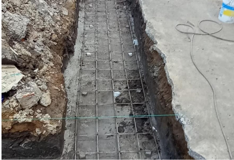
Figura 52. Armado de base de zapata tipo Z-2.
