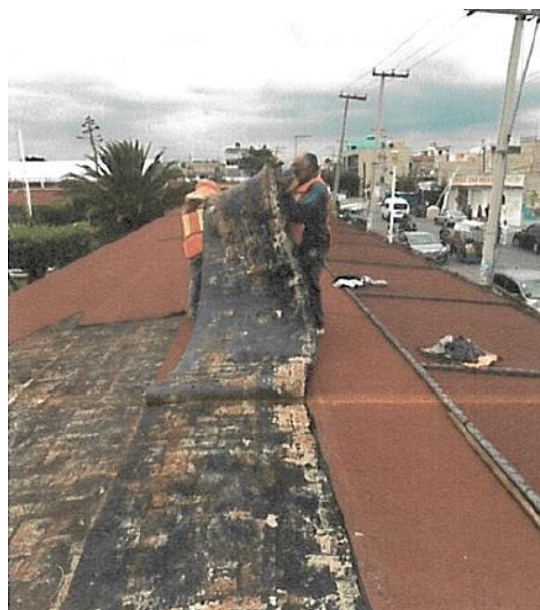
Figura 30. Desmantelamiento de impermeabilizante.
