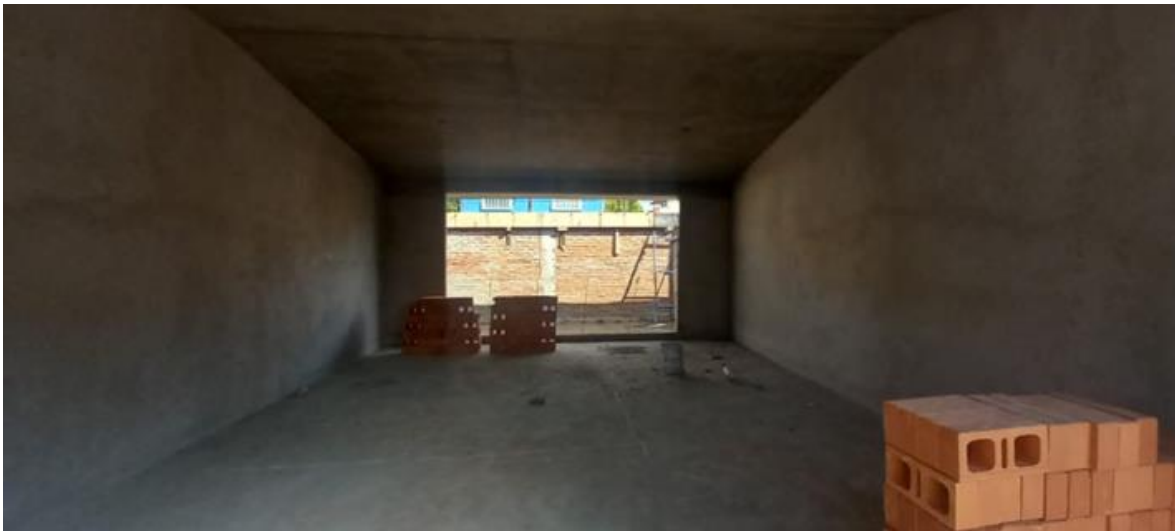
Figura 74. Aplanado en interiores de edificios.
