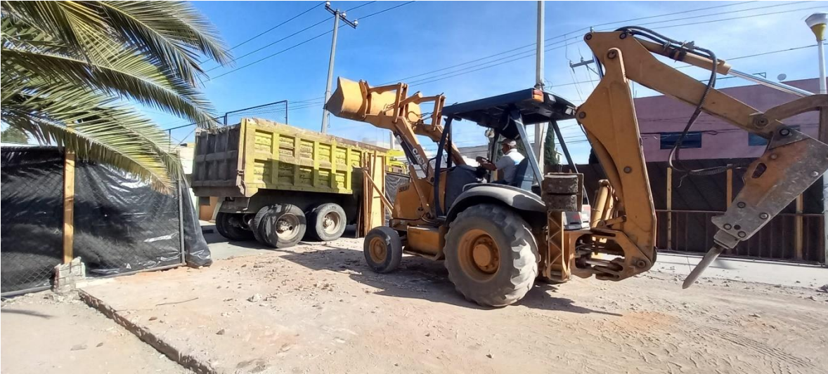
Figura 36. Retiro de escombros.
