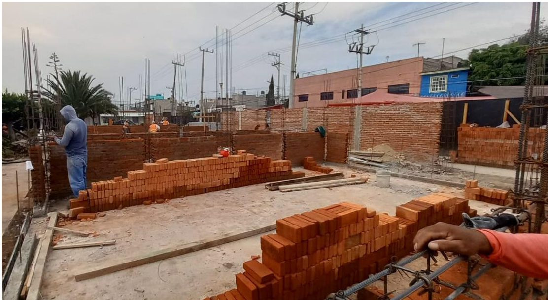
Figura 64. Levantamiento de muros.
