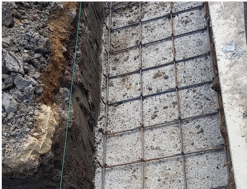
Figura 51. Armado de base de zapata tipo Z-1.
