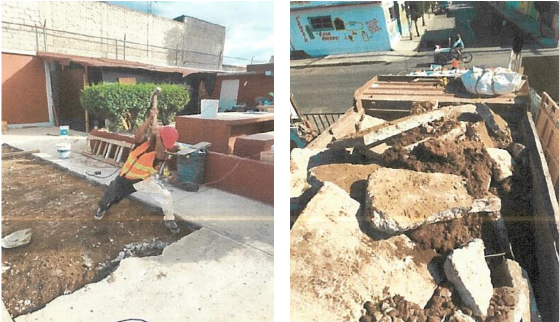
Figura 38. Demolición de piso de concreto.
