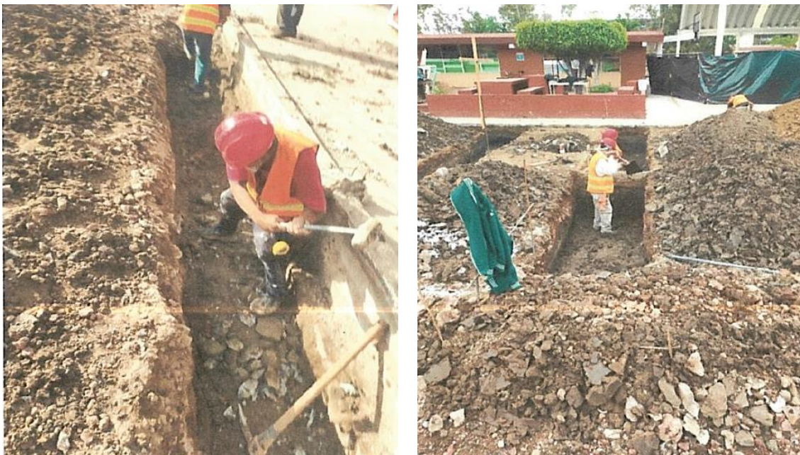
Figura 39. Demolición de cimentación con equipo manual.
