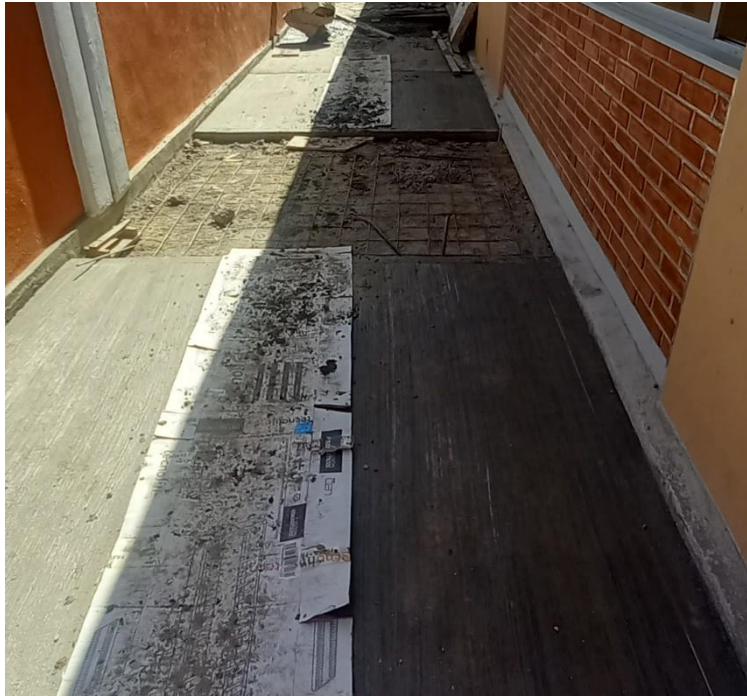
Figura 86. Colado de concreto en piso por secciones.
