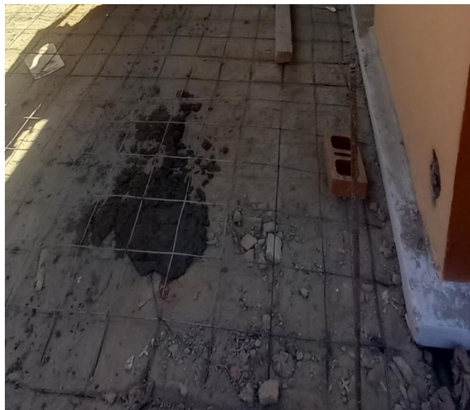
Figura 85. Colocación de malla electrosoldada.
