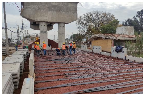
Fotografía 16. Proceso de Bando, para sujeción de escamas con la Tierra Armada.
