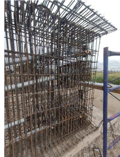
Fotografía 8. Armado de Trabe Nebraska 240, anclaje vivo y anclaje muerto, para tensado.
