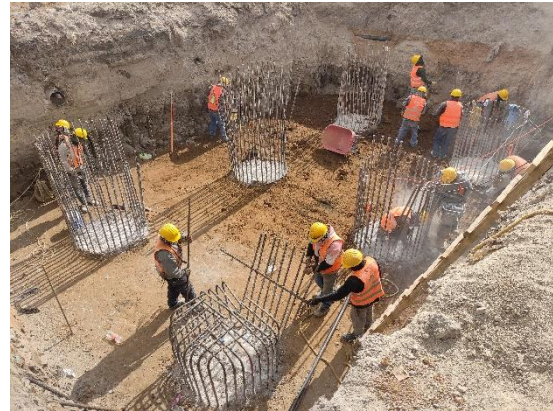
Fotografía 19. Descabezado de Pilas para pruebas PIT.
