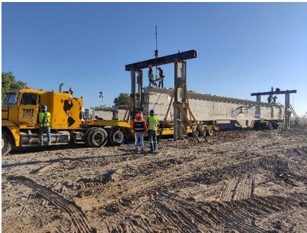
Fotografía 9. Transporte de Trabe Nebraska 240
