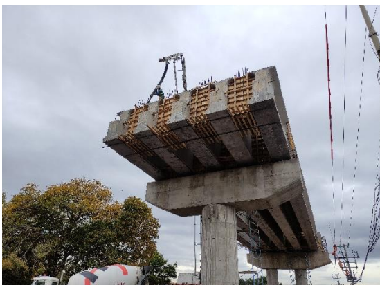
Fotografía 31. Colado de Diafragmas por medio de una Bomba de Concreto.
