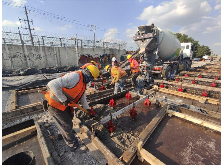
Fotografía 13. Colado de Escamas, para el Muro Mecánicamente Estabilizado.
