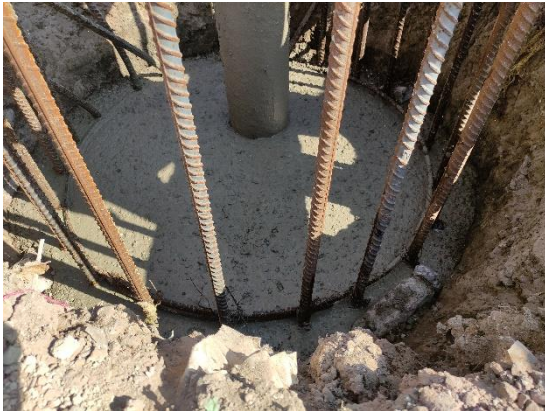
Fotografía 20. Termino de colado de Pilas de Cimentación.
