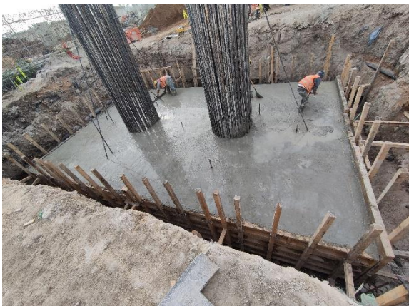
Fotografía 22. Termino de Colado de Zapata de Cimentación
