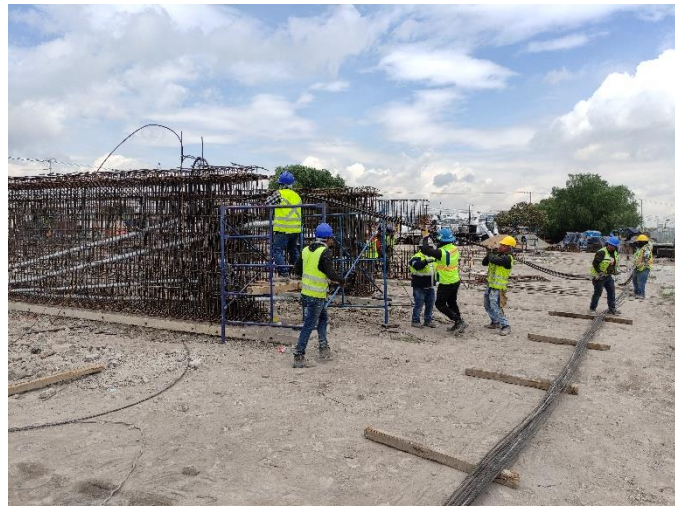
Fotografía 7. Introducción de los torones en el ducto para su posterior tensado.
