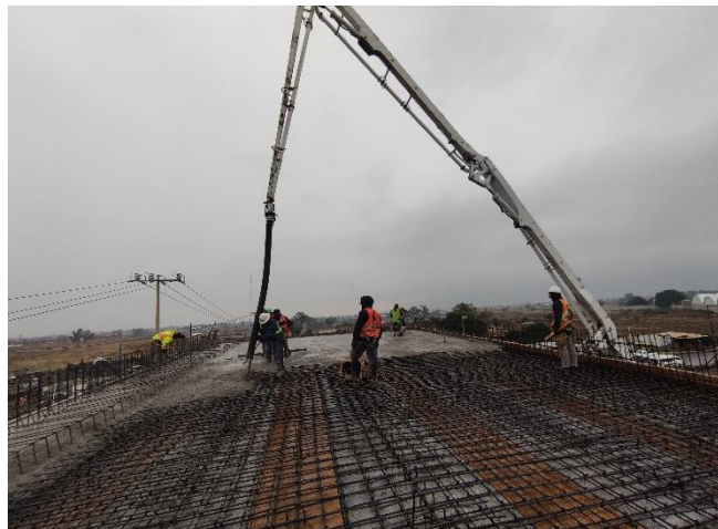
Fotografía 12. Colado de Losa de Rodamiento.
