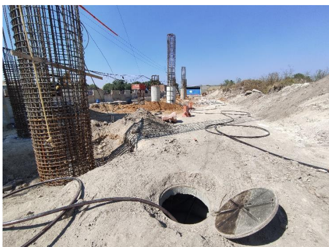
Fotografía 17. Instalación de Cableado Subterráneo en registros anteriormente colocados por parte de CFE para su bajada de luz.
