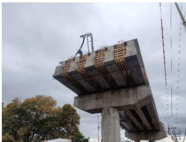
Fotografía 11. Colado de Diafragmas por medio de Bomba de Concreto.
