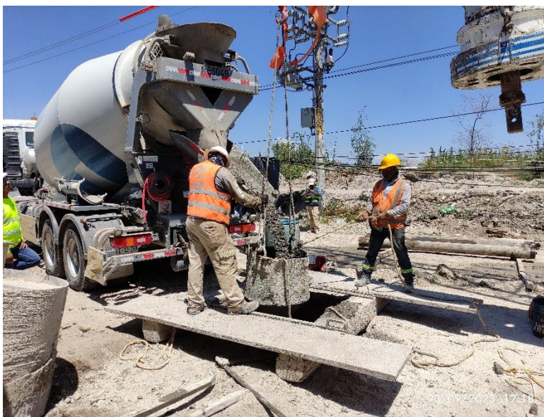
Fotografía Colado de Pila Cimentación 2. de
