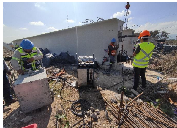
Fotografía 26. Tensado de Trabes, por medio de un Gato Hidráulico
