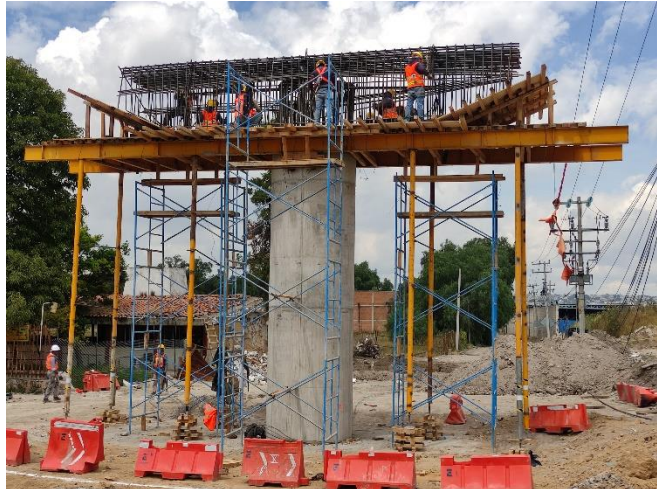
Fotografía 6. Armado de Cabezales.
