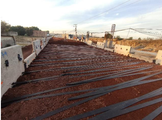
Fotografía 33. Proceso de Tensado de bandas, en proceso de Construcción del Muro Mecánicamente Estabilizado.
