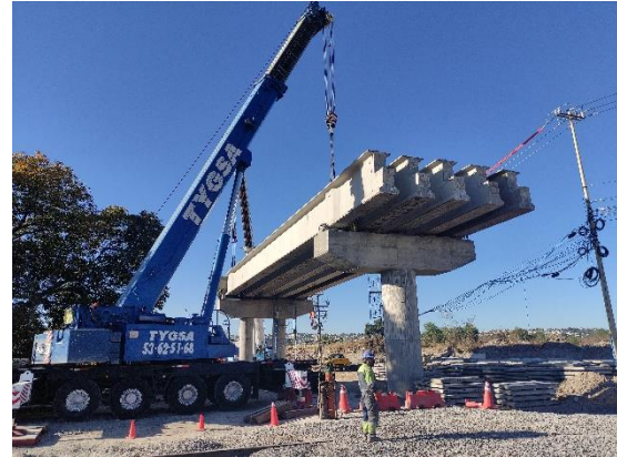
Fotografía 28. Termino de Izaje de Trabes, Claro 1-2.
