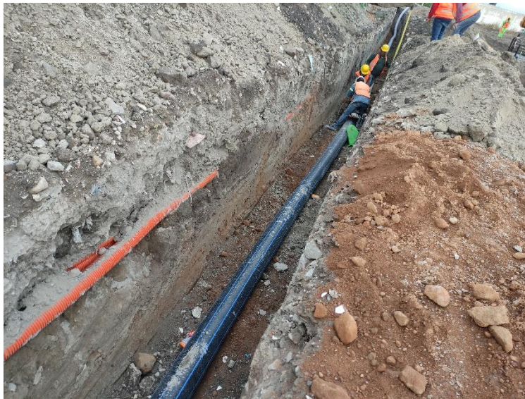
Fotografía 18. Instalación de la Tubería de 10" de la línea principal de agua potable.
