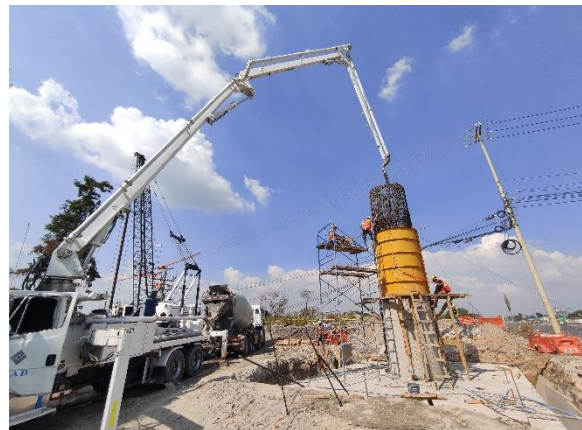
Fotografía 5. Colado de 2da. sección de columna, apoyo 2, mediante bomba de concreto.
