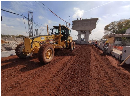
Fotografía 15. Tendido de Material de Tezontle 70/30, con uso de la Motoconformadora.
