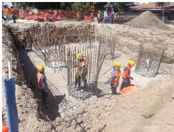
Fotografía 3. Descabezado de Pilas para preparativos, de pruebas PIT
