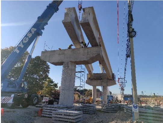
Fotografía 29. Izaje de Trabes Nebraska 240.
