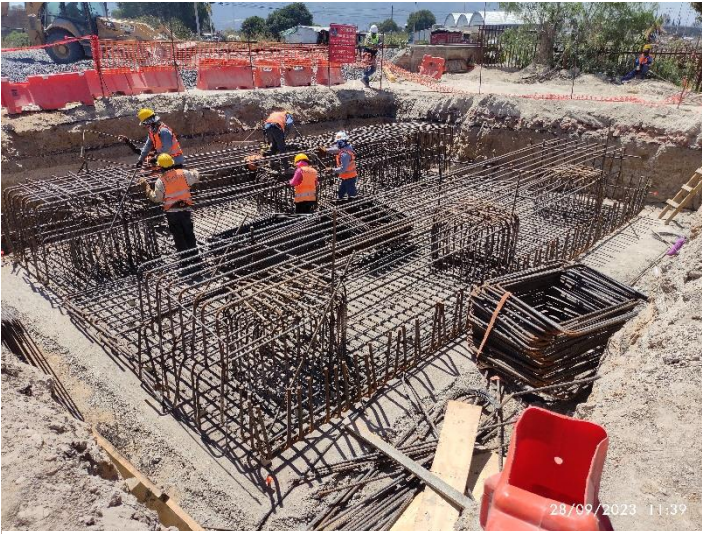
Fotografía 4. Armado de Zapata
