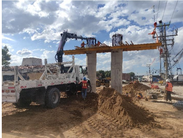
Fotografía 23. Comienzo de cimbrado de Cabezal, concluida ya las 2 columnas de Apoyo 1
