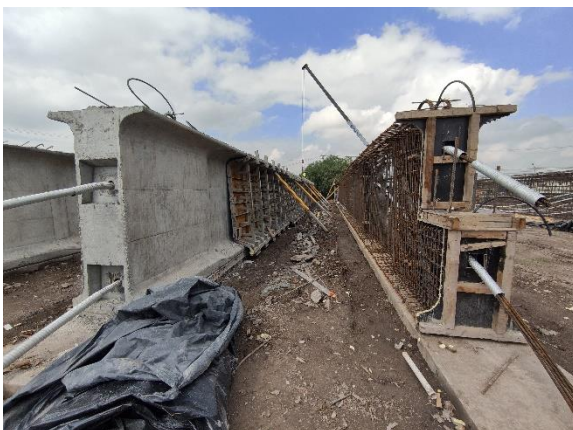
Fotografía 27. Armado y Cimbrado de Trabes Nebraska 240.
