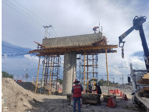
Fotografía 25. Descimbrado de Cabezal
