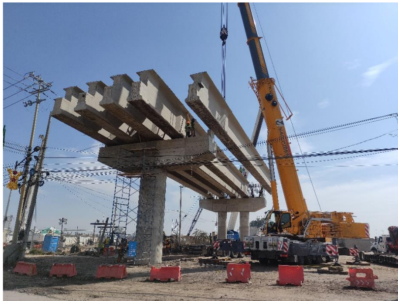
Fotografía 10. Izaje y Montaje de Trabe Nebraska 240.
