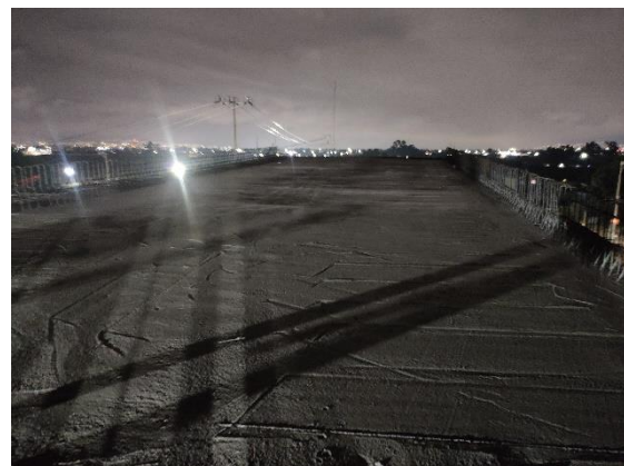
Fotografía 30. Termino de Colado de Losa de Rodadura Claro 3-4
