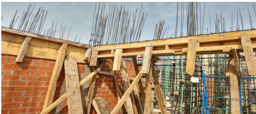
Ilustración 8-Colocación de cimbra en trabes y cerramientos
