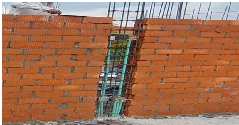
Ilustración 4-Habilitado de acero en castillos y columnas
