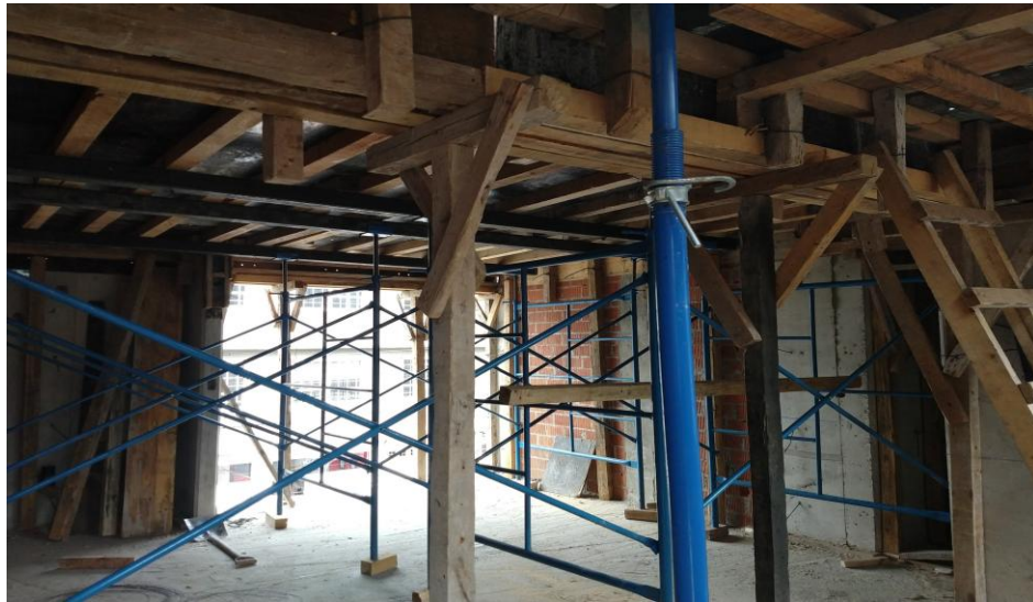
Ilustración 11-Colocación de cimbra para losa
