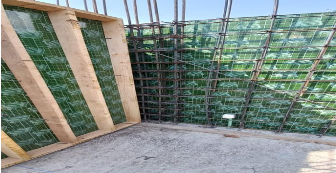
Ilustración 2-Colocación de cimbra en muro
