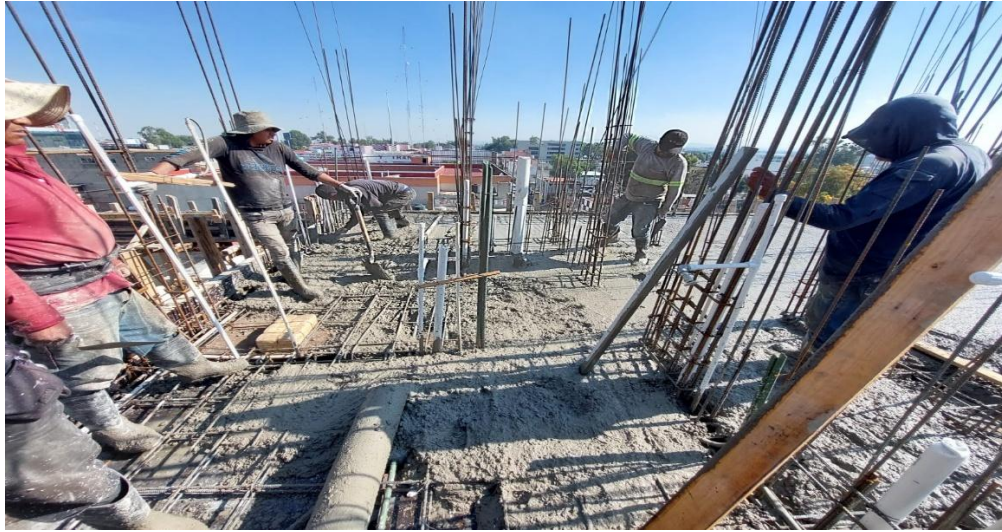
Ilustración 9-Colado de trabes y cerramientos
