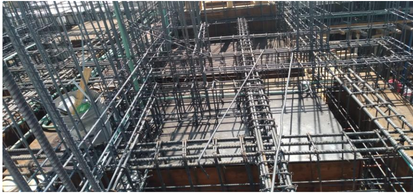
Ilustración 7-Habilitado de acero en trabes y cerramientos
