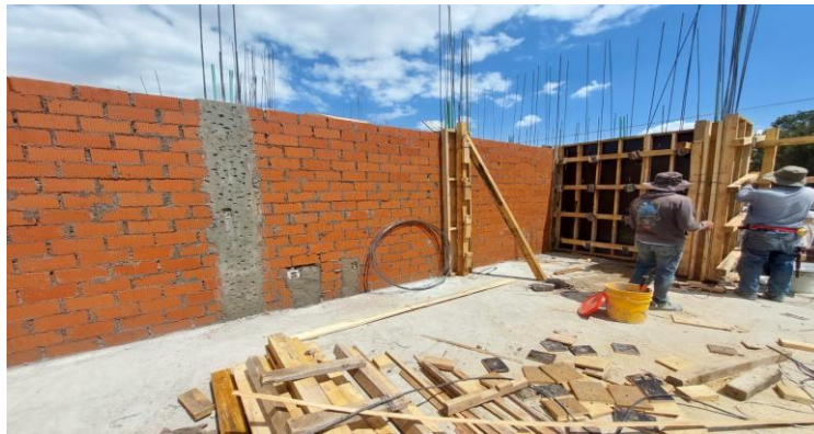
Ilustración 6- colado de castillos y columnas
