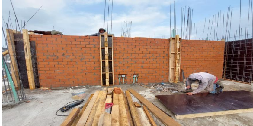
Ilustración 5-Cimbrado de castillos y columnas
