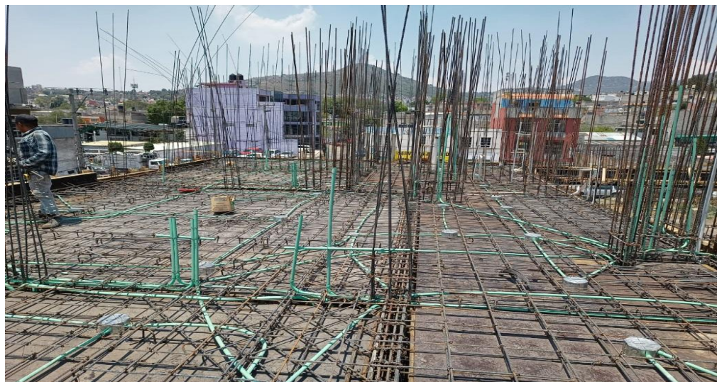
Ilustración 10-Habilitado de acero para losa
