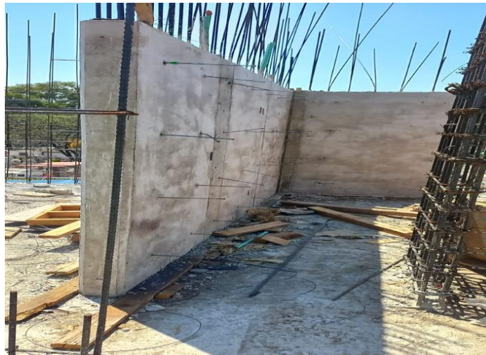
Ilustración 3- Colado del muro
