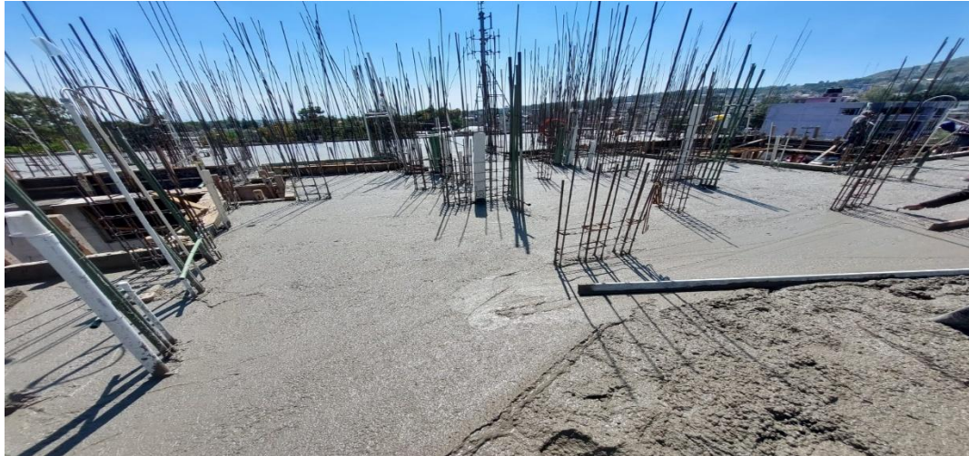
Ilustración 12-Colado de losa
