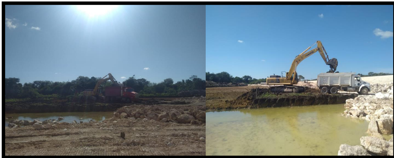
(Figura 3.2) Carga de camiones
