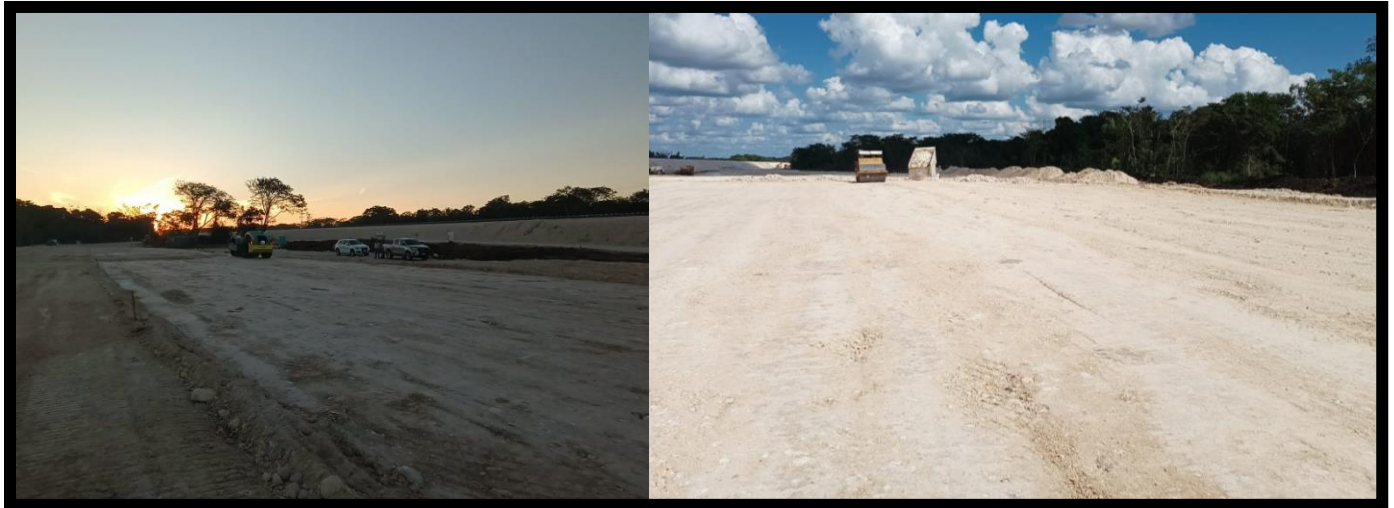
(figura 3.7) compactado de sascab con vibrocompactador
