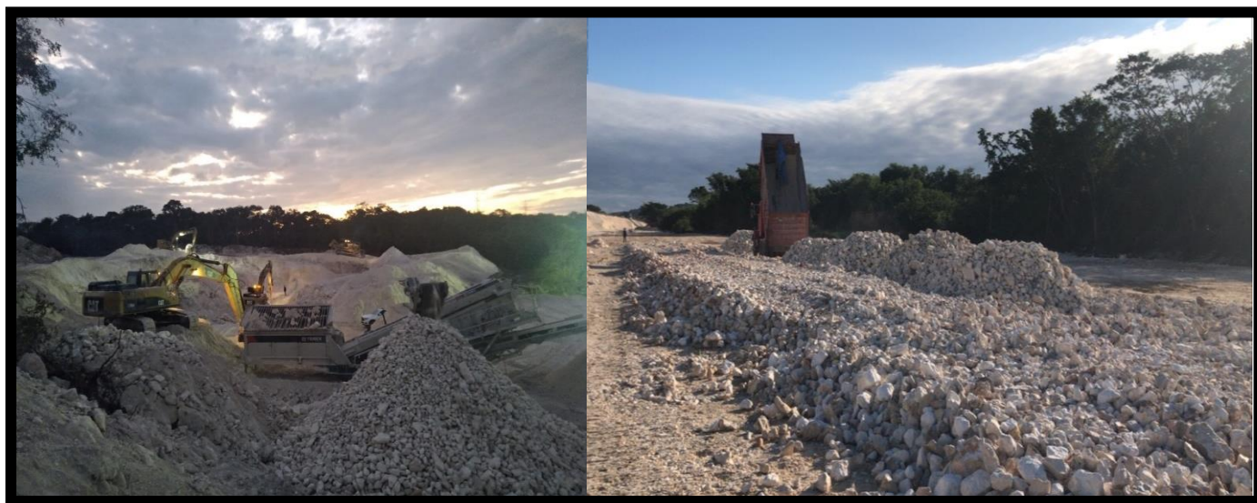
(figura 3.6) Piedra cribada de 4 a 6 pulgadas
