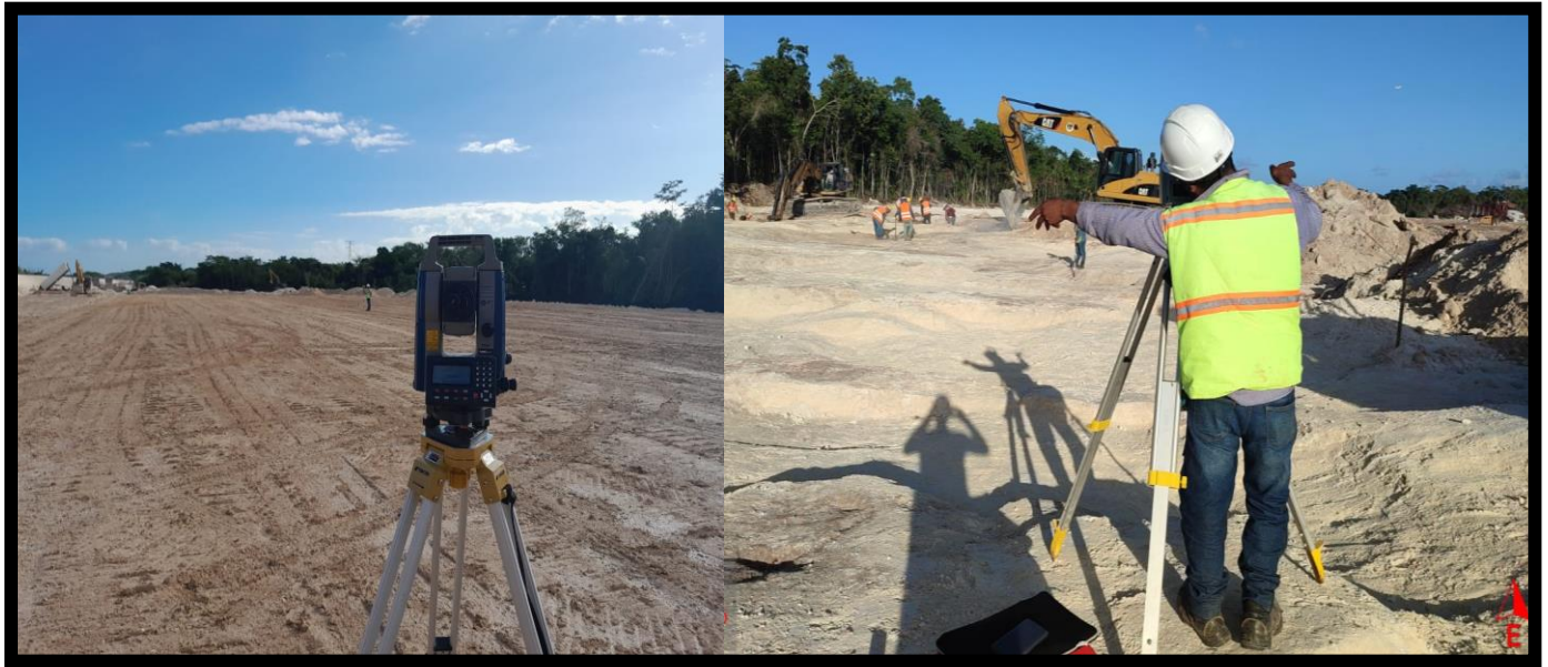
(figura 3.3) Trazo y nivelación
