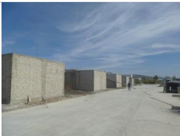
Vista general donde las viviendas no han sufrido de asentamientos diferenciales.
