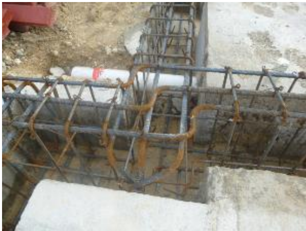
Contratraves armadas y reforzadas conforme a proyecto estructural y normatividad.
