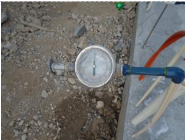
Se realizan pruebas de hermeticidad en instalaciones hidráulicas.
