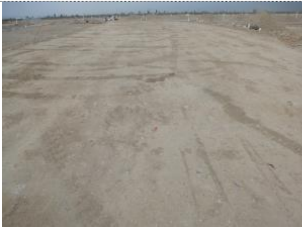
En esta imagen se observa las plataformas ya terminadas y de acuerdo a especificaciones del EMS.
