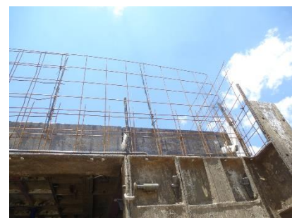
Fotografía 3 Malla electrosoldada, refuerzo en muros
