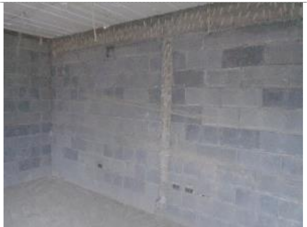
Se cuida la verticalidad y horizontalidad de las juntas.
