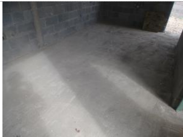
Los concretos de la cimentación no muestran deficiencias.
