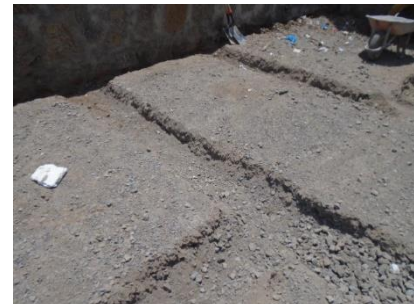
Fotografía 1 Compactacion del terreno
