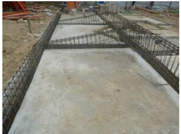
Contratraves armadas y reforzadas conforme a proyecto estructural y normatividad.
