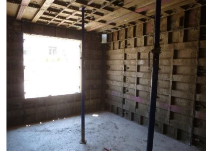
Fotografía 2 Molde armado
