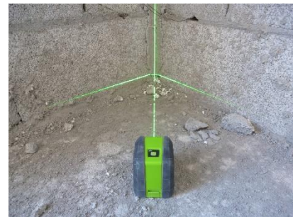
Fotografía 8 verificación de la verticalidad de los muros
