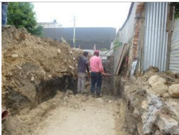
En la excavación para alojar la zapata podemos apreciar la calidad del terreno se encuentra sano y estable.
