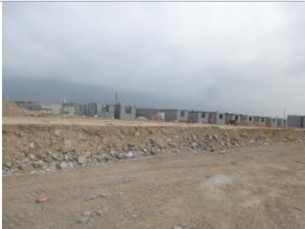
Podemos observar el espesor de las plataformas, mismo que cumple con las especificaciones.
