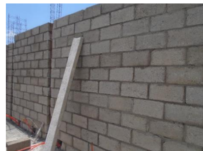
Fotografía 9 Muro de Block macizo
