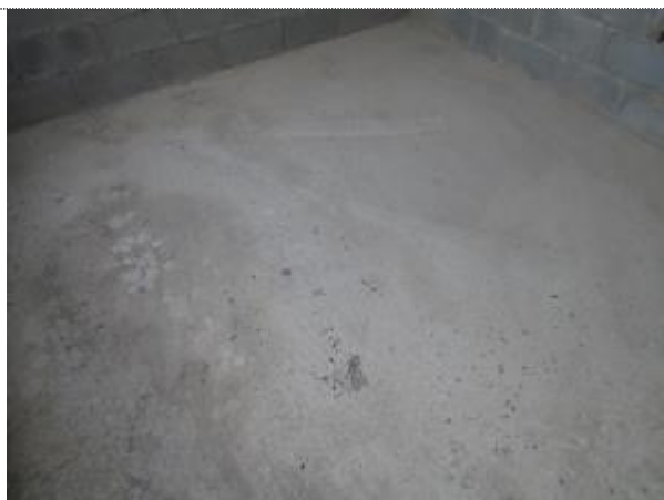
A la fecha no se detectaron fisuras o grietas en losas de cimentación.
