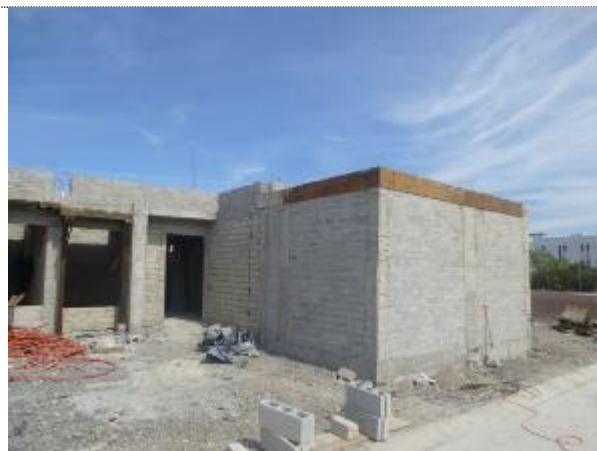
En la visita las viviendas se observaron estables.
