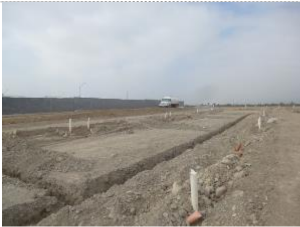
El corte de la excavación se aprecia estable.
