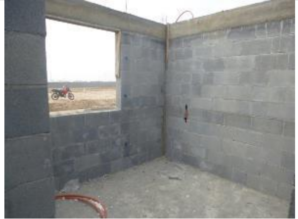
Se cuida la verticalidad y horizontalidad de las juntas.
