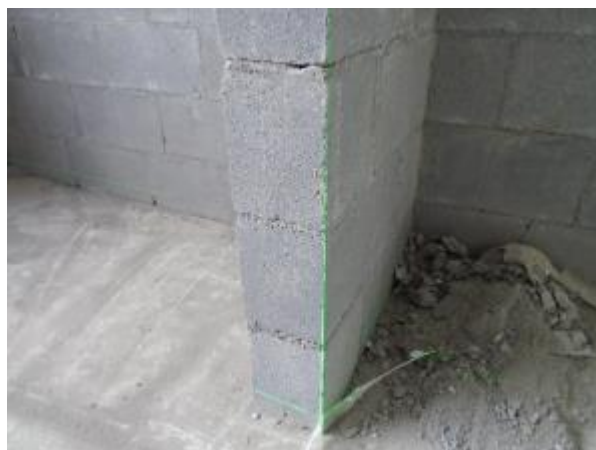
Mediante el nivel laser no se detectaron muros con desplomes o descuadres fuera de lo permitido.
