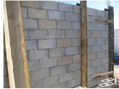
Fotografía 6 Muro de Block hueco
