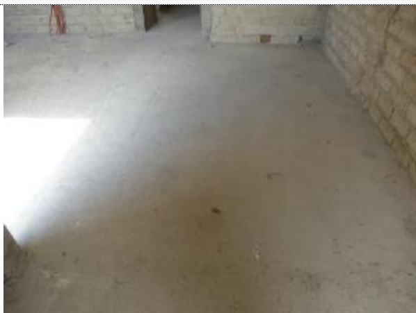
La cimentación muestra un concreto libre de fisuras o agrietamientos.
