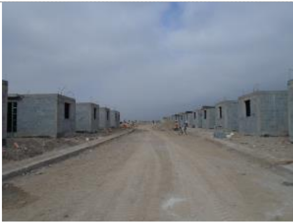
En esta imagen apreciamos que las viviendas se encuentran estables.
