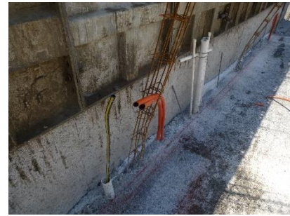
Fotografía 4 Preparación de instalaciones hidráulicas y eléctricas
