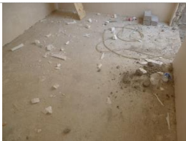
Los concretos en losas de cimentación no muestran deficiencias.
