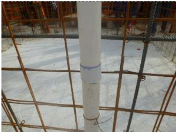
Se utilizan las conexiones adecuadas para las instalaciones.
