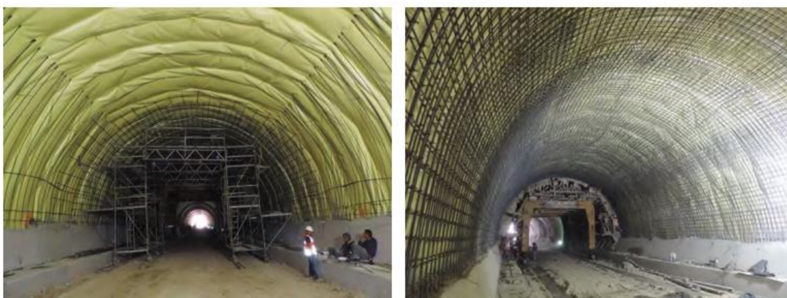
Figura 11.14. Colocación de acero en clave y hastiales.
