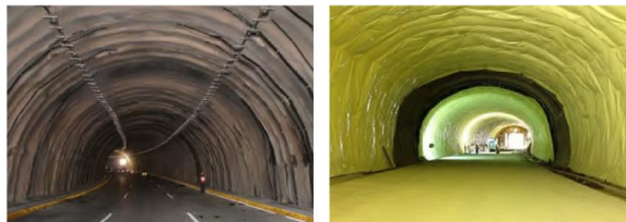
Figura 12.1. y 12.2. Túnel sin sistema de impermeabilización y túnel con geotextil y geomembrana.
