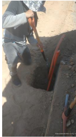
ILUSTRACIÓN 27 EXCAVACIÓN DE LUMINARIAS
