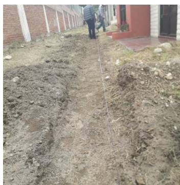
ILUSTRACIÓN 16 MARCAR LAS UBICACIONES PRECISAS DEL ANDADOR Y LA GUARNICIÓN
