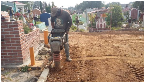
ILUSTRACIÓN 26 COMPACTACIÓN DE LA BASE
