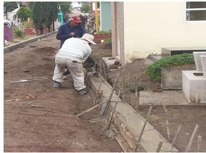
ILUSTRACIÓN 20 VERTIDO DE CONCRETO
