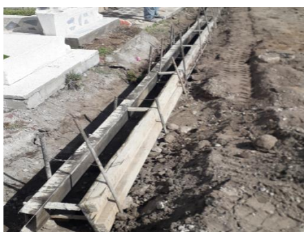
ILUSTRACIÓN 19 ARMADO DE ENCOFRADO
