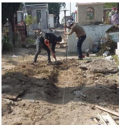
ILUSTRACIÓN 17 PREPARACIÓN DE LA BASE
