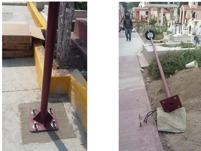
ILUSTRACIÓN 32 FIJACIÓN DEL POSTES
