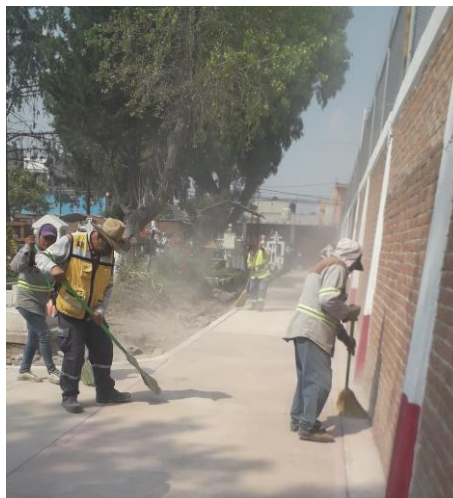
ILUSTRACIÓN 34 LIMPIEZA Y PINTURA
