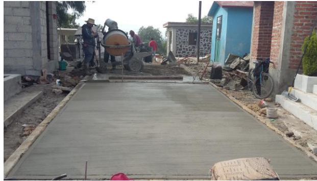
ILUSTRACIÓN 29 VERTIDO DE CONCRETO
