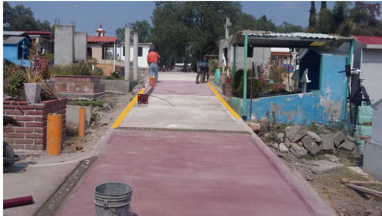
ILUSTRACIÓN 35 LIMPIEZA Y PINTURA
