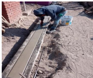
ILUSTRACIÓN 21 CURADO DEL CONCRETO
