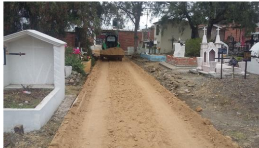
ILUSTRACIÓN 25 COLOCACIÓN DE MATERIAL DE BASE
