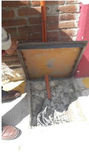
ILUSTRACIÓN 33 COLOCACIÓN DE POLIDUCTO PARA ALIMENTACIÓN
