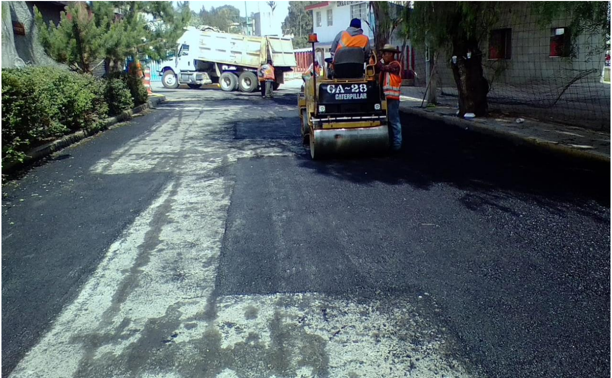
Ilustración 31 compactación de mezcla asfáltica en frío.
