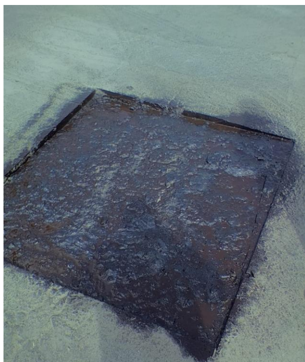
Ilustración 28 Sección abierta para rellenar.
