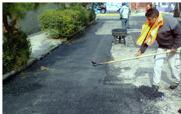
Ilustración 30 Retiro de exceso de mezcla asfáltica.
