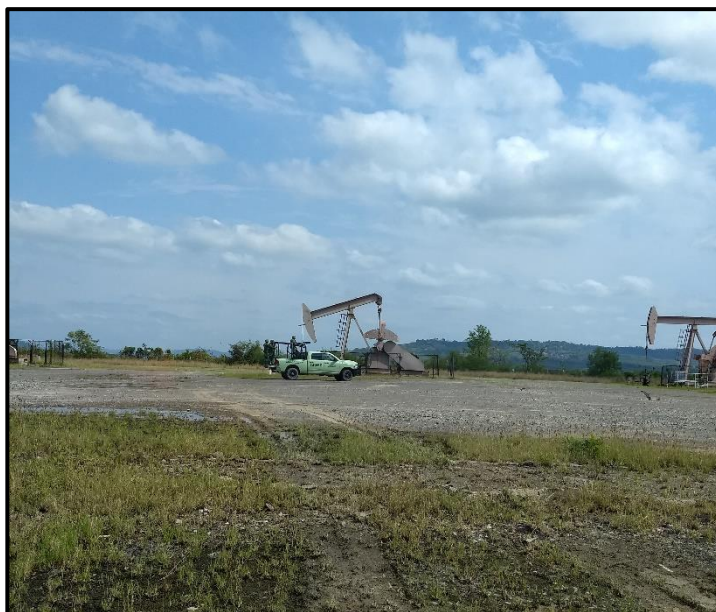
Figura 29. Acceso al pozo Escobal 197 antes de instalar la unidad pesada.
