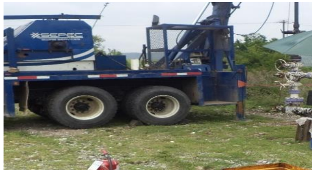
Figura 3.4 Chuck Block's instalados.
