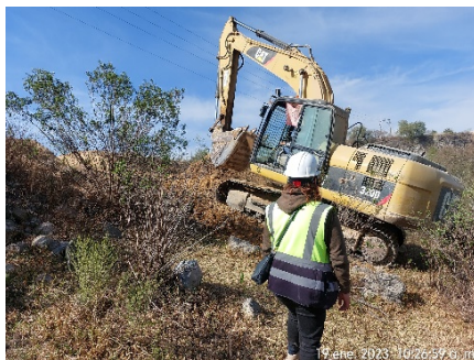
Ilustración 1. Excavación de terreno.
