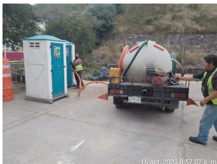
Ilustración 4. Retiro de residuos sanitarios.
