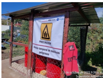
Ilustración 12. Almacén temporal de residuos peligrosos.
