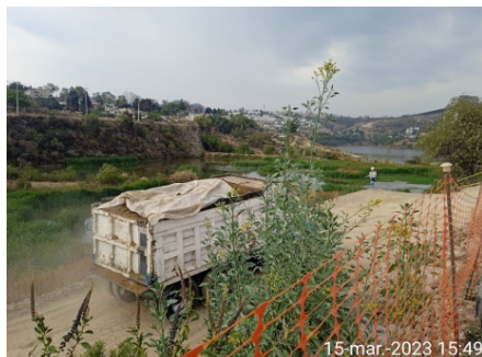
Ilustración 18. Uso de lona en camión con material pétreo.
