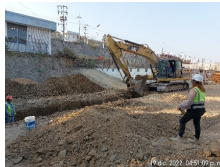
Ilustración 2. Retiro de material de excavación.
