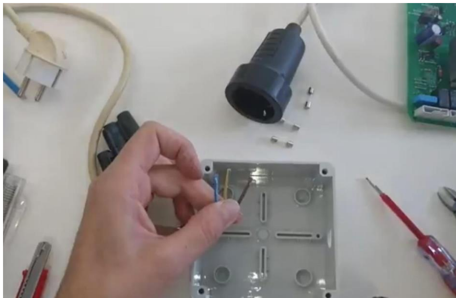
Ilustración 38 Colocación de clave de 3 vías en la caja de circuitos
