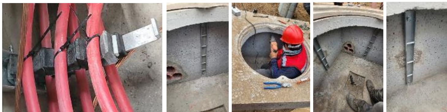
Figura 3.19: Instalación de soportes en registros de media tensión.
