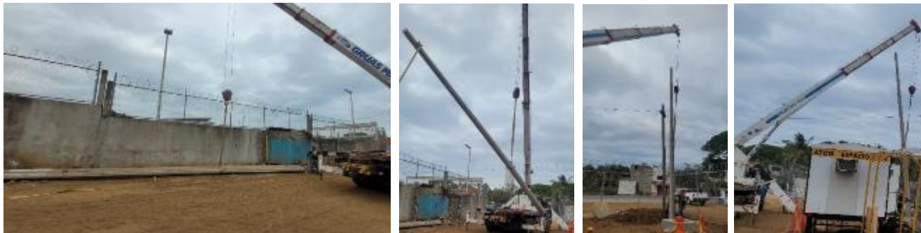
Figura 3.14: Maniobra de izaje para instalación de poste
