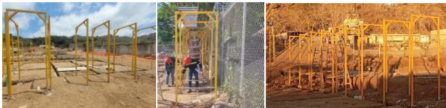
Figura 4.03: Instalación de soportes.
