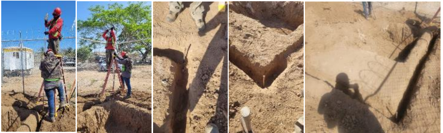
Figura 3.09: Cepa para cable y entierro de varillas.
