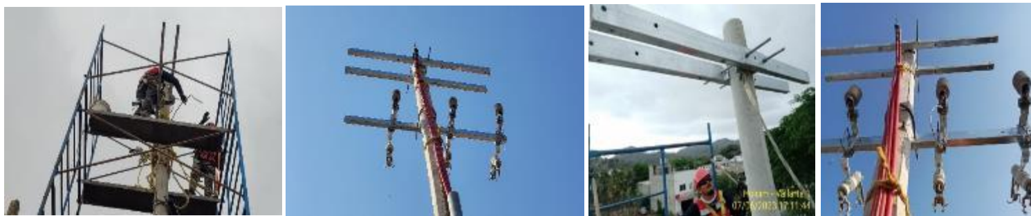
Figura 3.21: Instalación de crucetas PT 200
