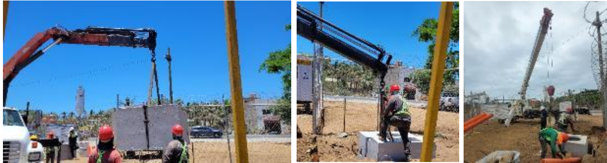
Figura 3.05: Montaje de registros con grúa de 22 Ton.
