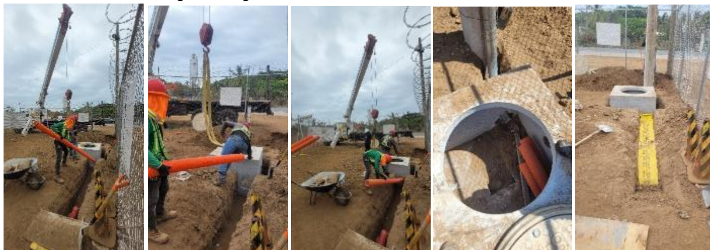
Figura 3.16: Canalización con tubo PAD y cinta de precaución
