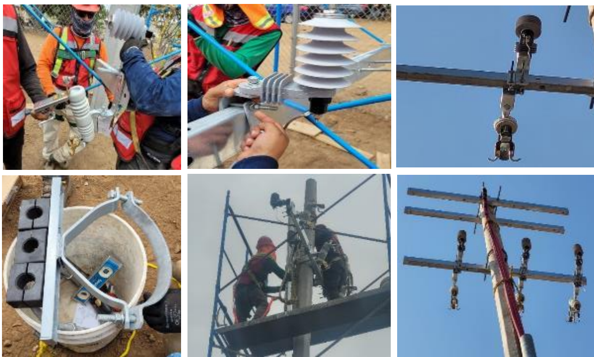
Figura 3.22: Montaje de accesorios sobre poste.
