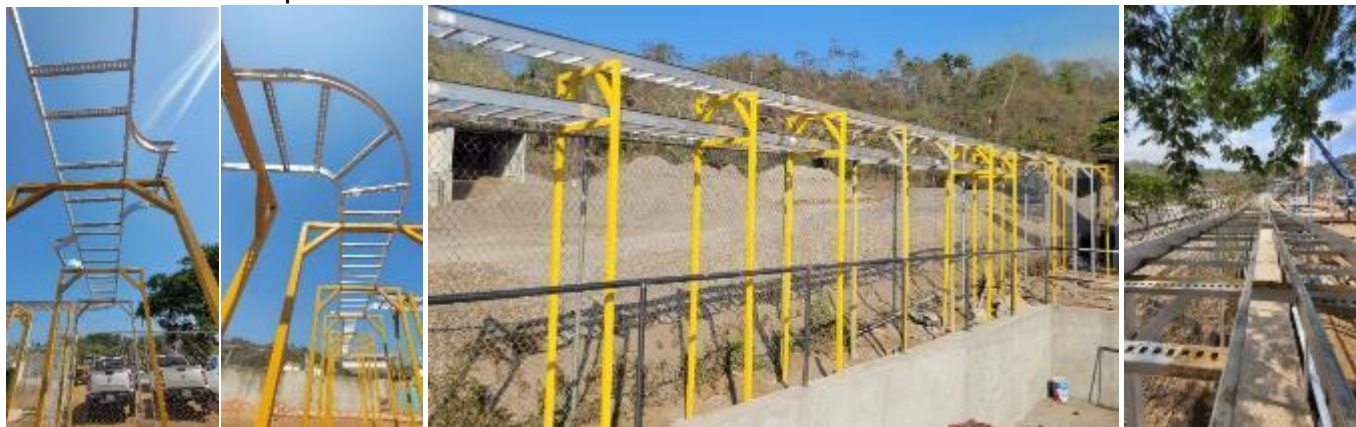
Figura 4.05: Etapa 1 de la instalación de charola.
