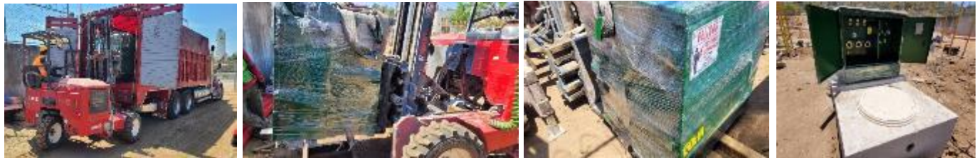
Figura 3.12: Traslado del transformador desde transporte de entrega hasta su base
