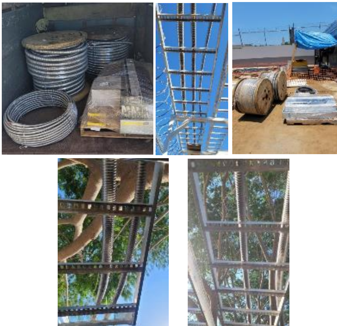
Figura 4.08: Instalación de cableado para de fuerza para tableros.
