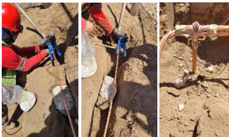
Figura 3.11: Realización de soldaduras en el proyecto
