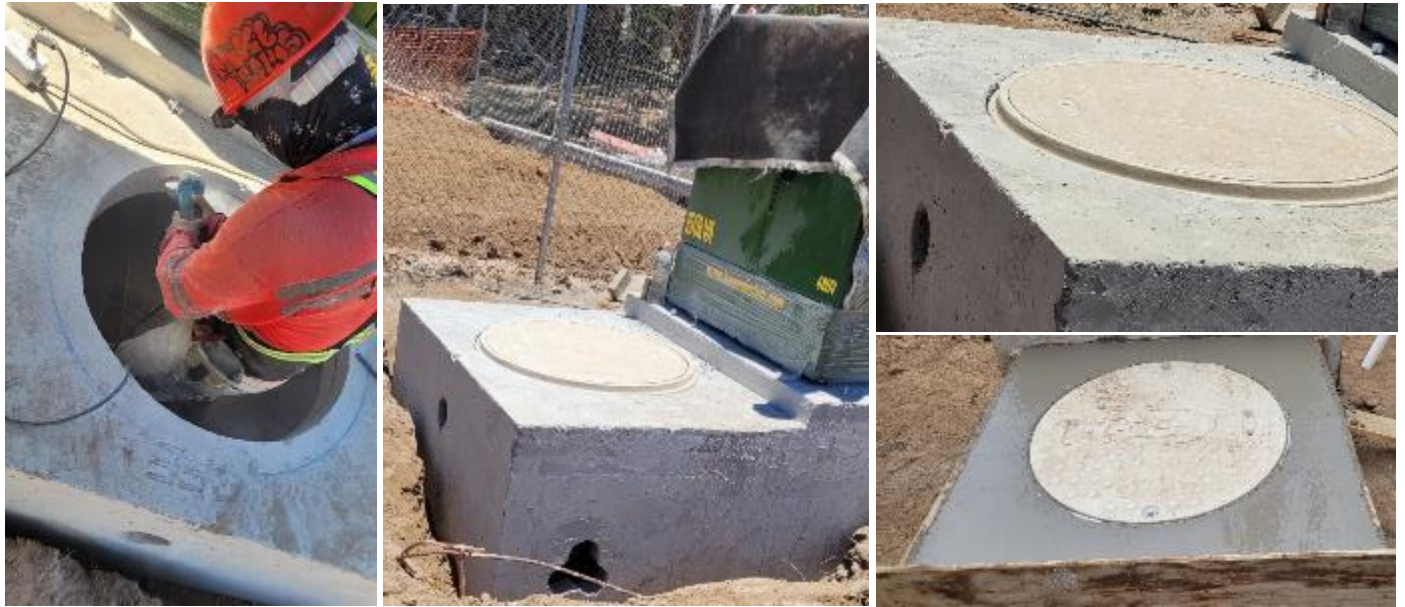
Figura 3.07: Instalación de tapa en registros de M.T.
