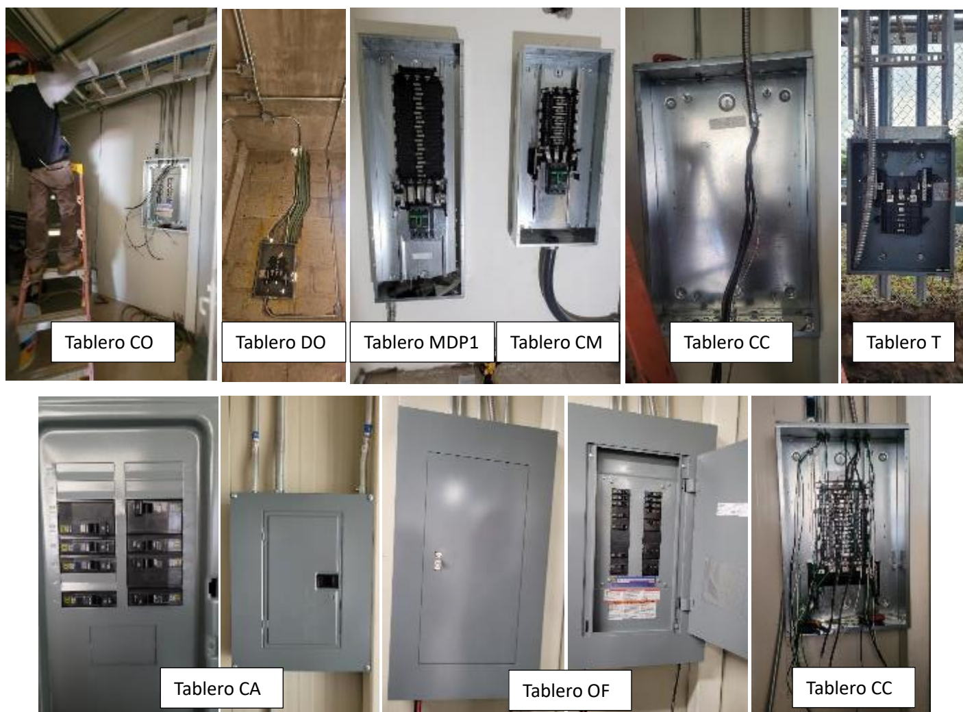
Figura 4.12: Proceso de instalación de los tableros derivados.
