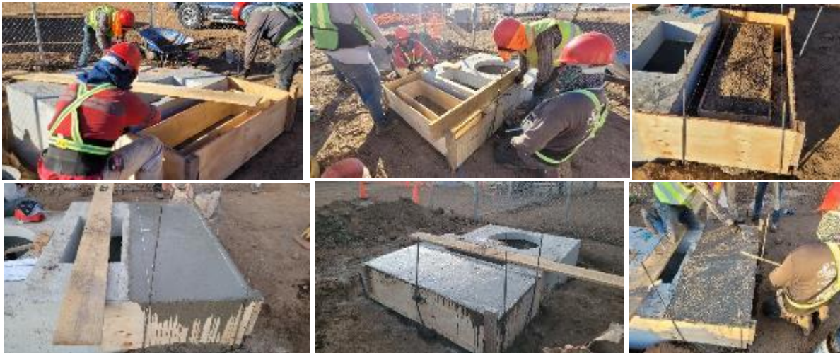
Figura 3.06: Fabricación de loza en registro para descanso de transformador pedestal
