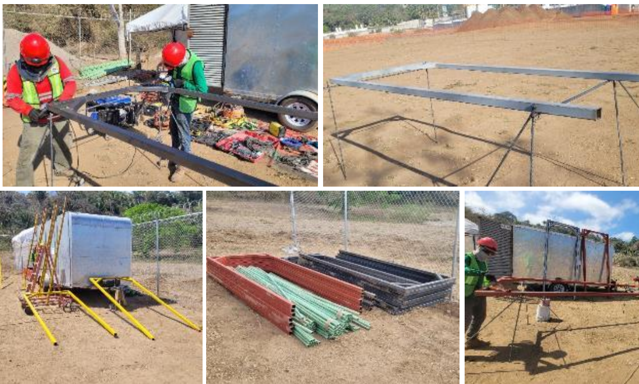
Figura 4.02: Fabricación de soportes.
