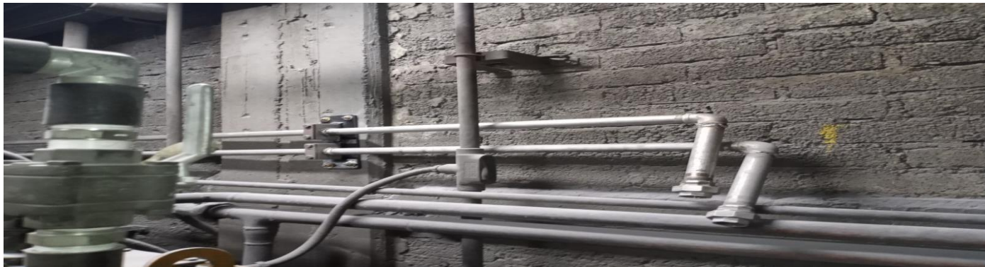
Ilustración 21 Instalación de tubería de 1 plg en acero Inox
