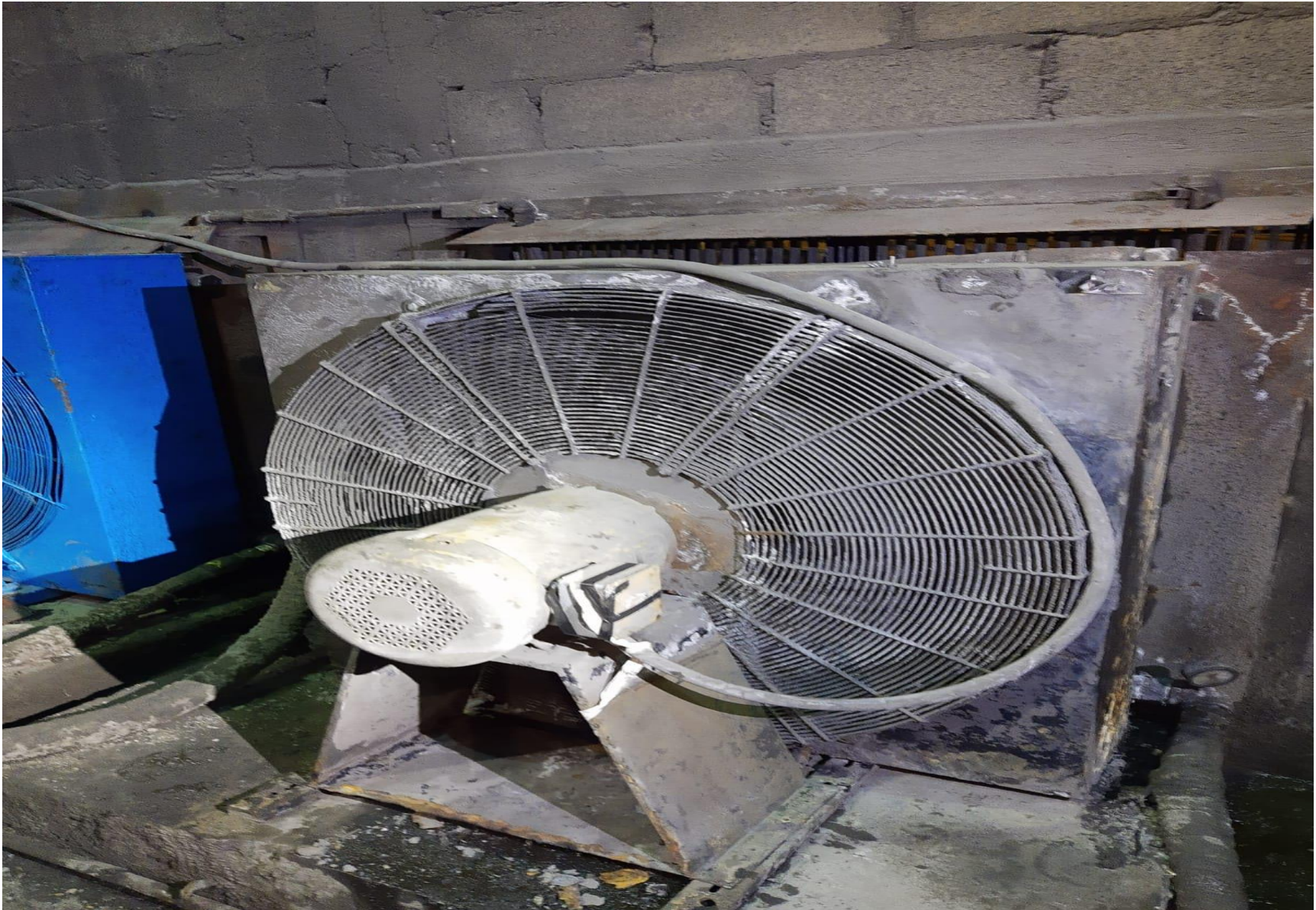
Ilustración 14 Intercambiador de calor con aire forzado
