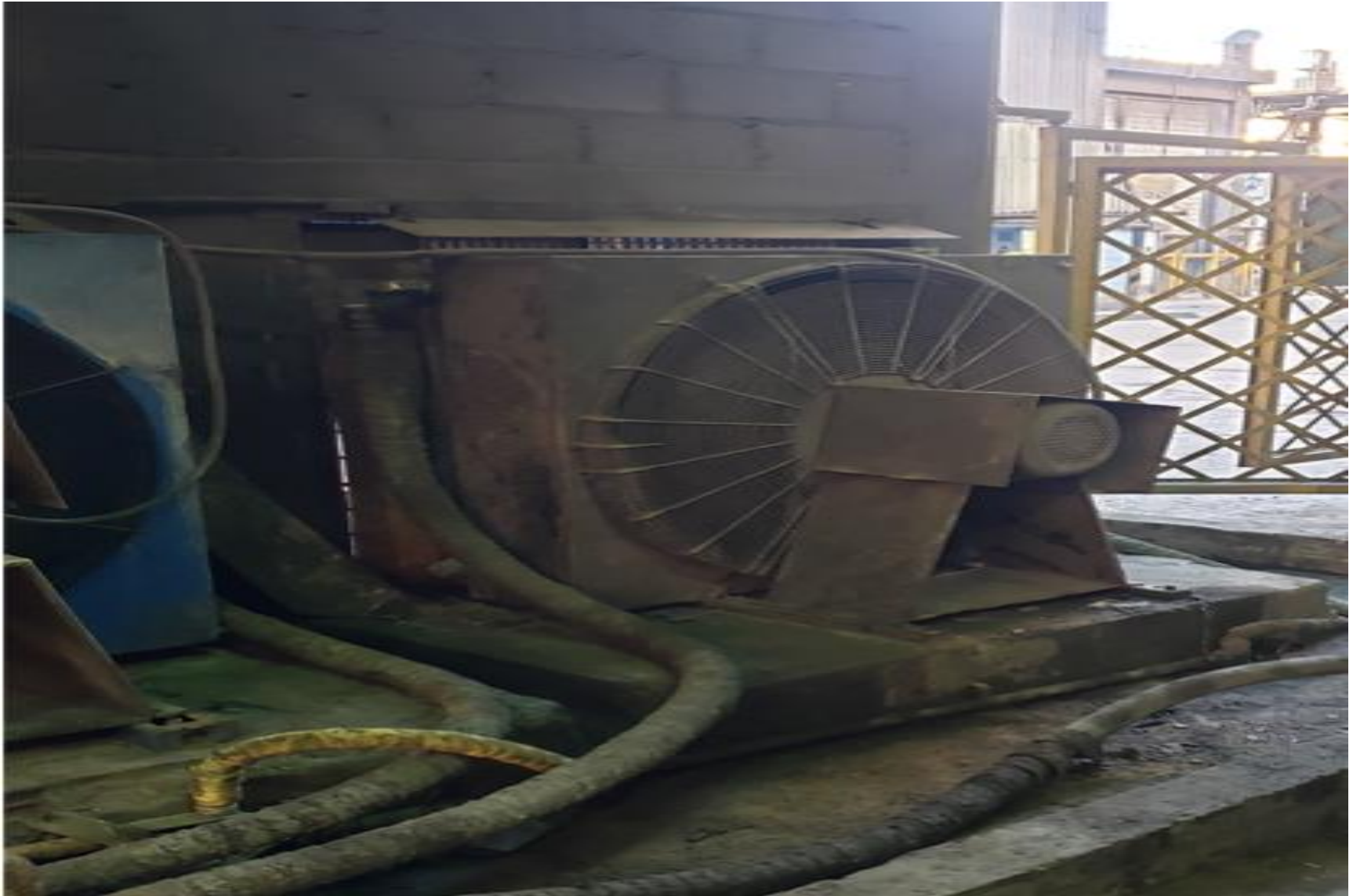
Ilustración 15 Intercambiador de calor por aire forzado
