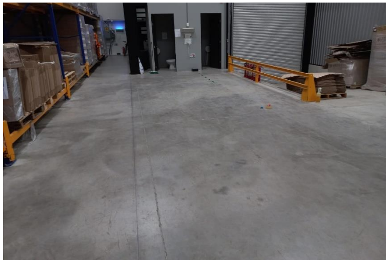
Figura 38. Proyección de estado del almacén en sección 5 (Bodega 5)
