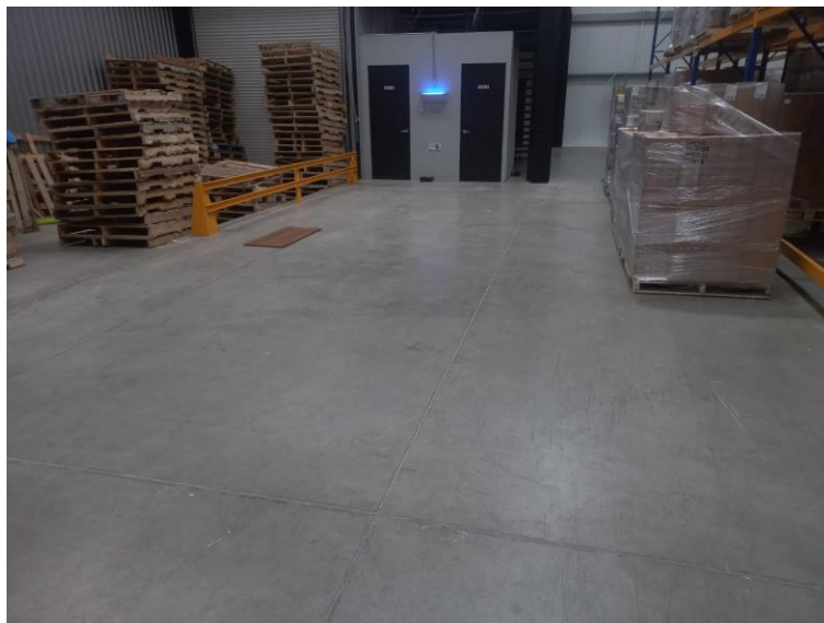
Figura 37. Proyección de estado del almacén en sección 6 (Bodega 6)
