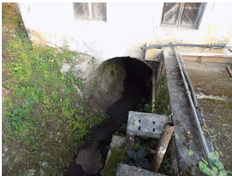
Figura 20. Túnel que conduce al río por la parte inferior del beneficio.
