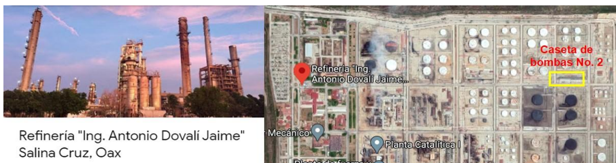
Figura1.4 Vista aérea de la refinería y casa de bombas 2
