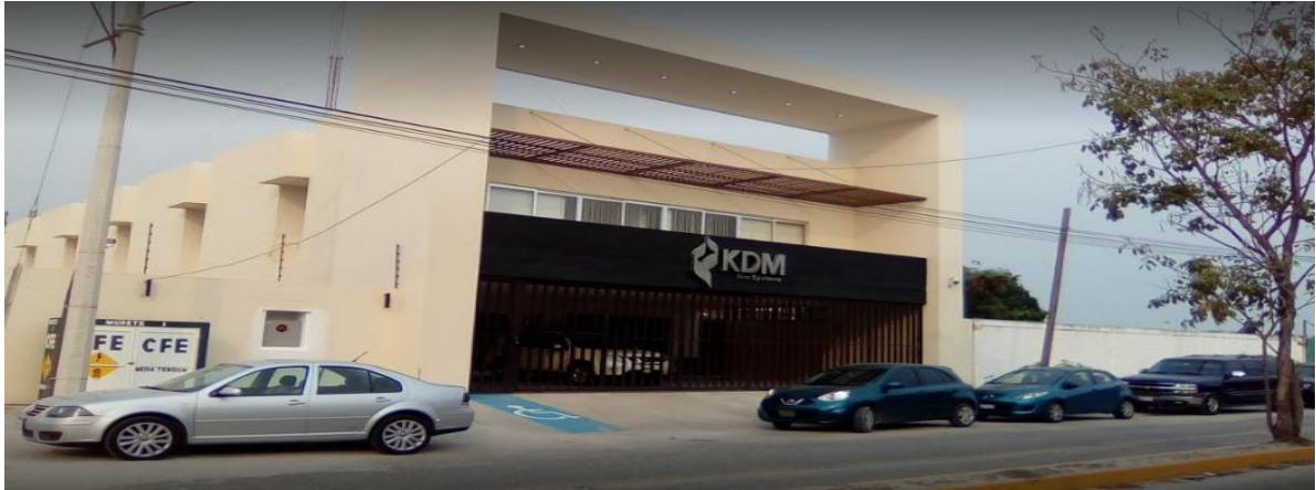
Figura 1.2.1 Fachada exterior de las oficinas de KDM en Cd del Carmen
