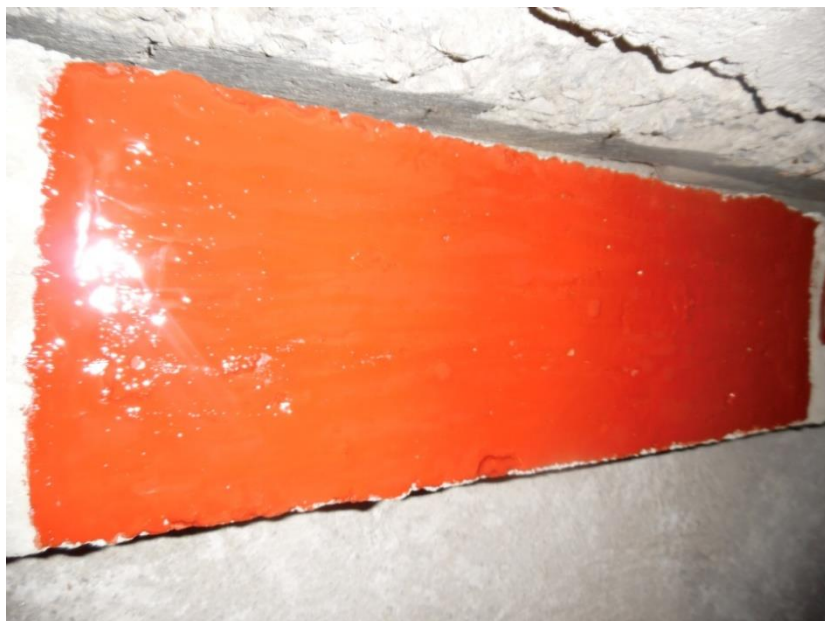
Figura 34. Aplicación del impermeabilizante a un muro.
