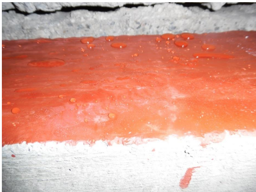
Figura 38. Prueba de aplicación de agua en el muro sobre el impermeabilizante.
