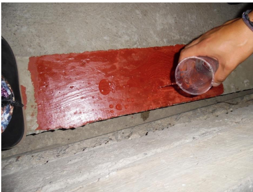
Figura 37. Prueba de aplicación de agua en el muro sobre el impermeabilizante.
