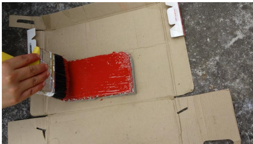
Figura 48. Aplicación del impermeabilizante en placa de cemento.
