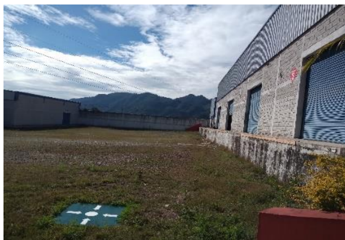
Imagen 18. Punto de encuentro “A” que se encuentra localizado frente al andén 7 el cual es el más seguro para los demás andenes ya que pasan los cables de alta tensión justamente en medio.
