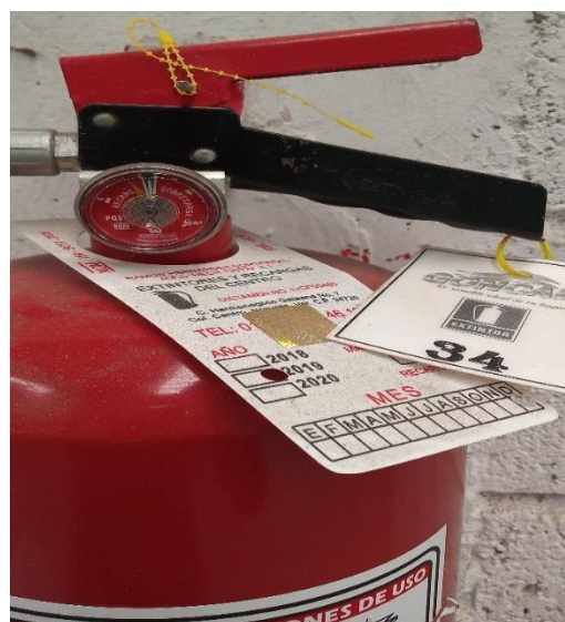
Imagen 45. La aguja del nanómetro se encuentra en la zona verde
