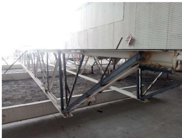
Ilustración 57. Estructuras de acero para el ensamblado.
