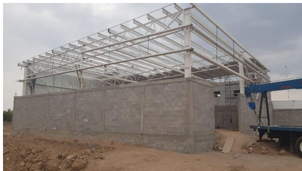
Ilustración 59. Recubrimiento de la estructura anti corrosión y anti oxidación.
