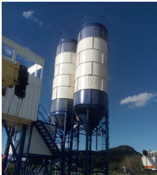
Ilustración 48. Silos de almacenamiento de material.
