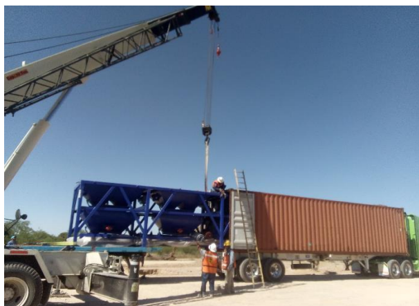
Ilustración 61. Descarga de estructuras con grúa.
