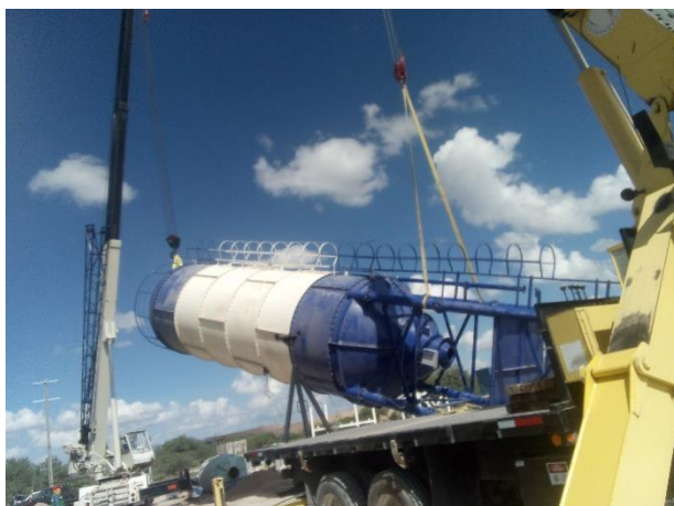
Ilustración 63. Colocación del SILO a posición original.
