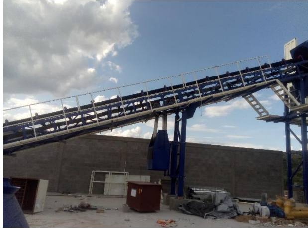
Ilustración 46. Banda transportadora que conecta las tolvas con la trituradora.
