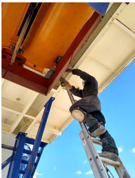
Ilustración 66. Armado de la trituradora portando EPP.
