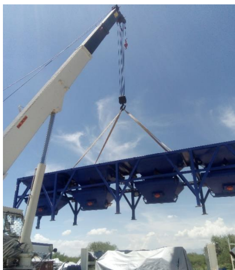
Ilustración 64. Maniobra con tolvas operando la grúa de 30 toneladas.
