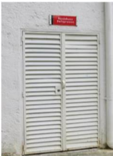
Ilustración 28. cuarto de almacenamiento temporal de residuos peligrosos.
