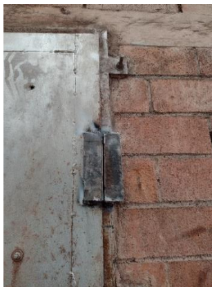
Figura 11. Placas para instalación de detectores magnéticos
