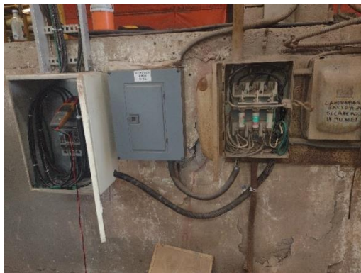
Figura 17. Conexión de líneas al interruptor
