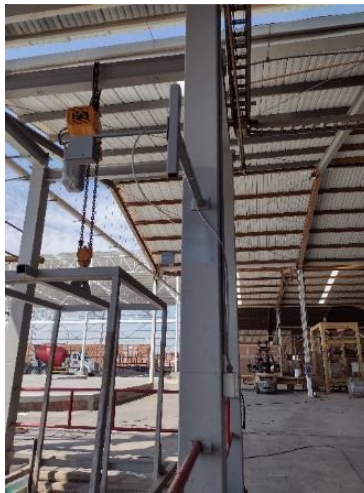
Figura 26. Instalación de sensores
