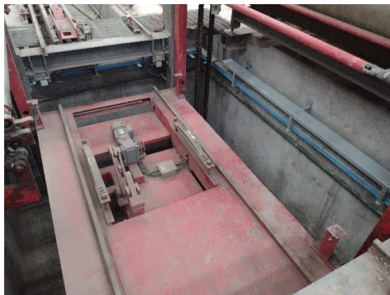
Figura 33. Canaleta nueva y protección contra golpes
