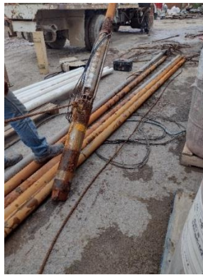
Figura 58. Retiro de motobomba y tubos en mal estado
