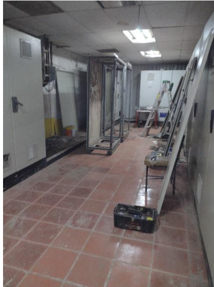
Figura 40. Desmantelado de tablero
