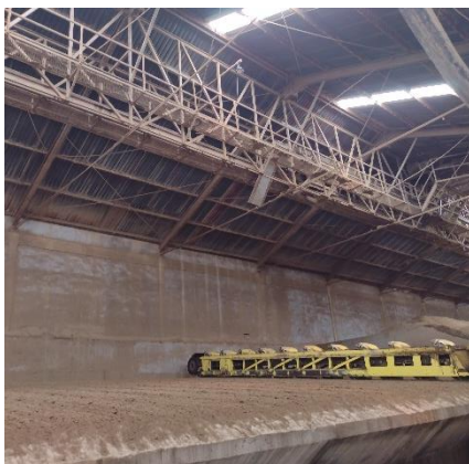
Figura 29. Instalacion de alumbrado
