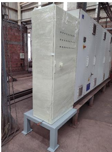
Figura 53. Tablero rehabilitado e instalado
