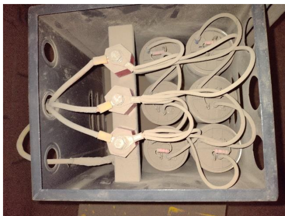
Figura 62. Capacitores dañados
