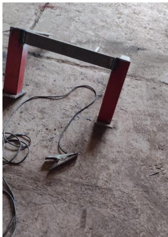
Figura 50. Armado de base
