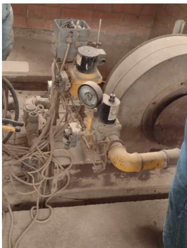
Figura 24. Electroválvula a cambiar
