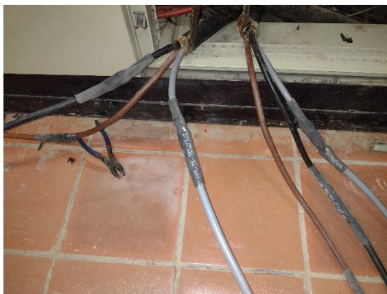
Figura 35. Cables empalmados
