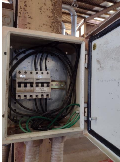
Figura 19. Reubicación de tablero
