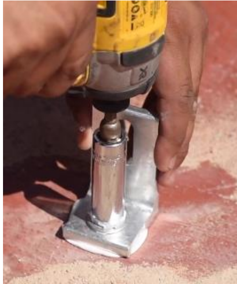
Figura 64. Colocación de la pata L sobre la perforación.
