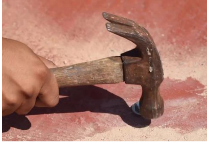
Figura 62. Introducción del taquete expansivo en la perforación.
