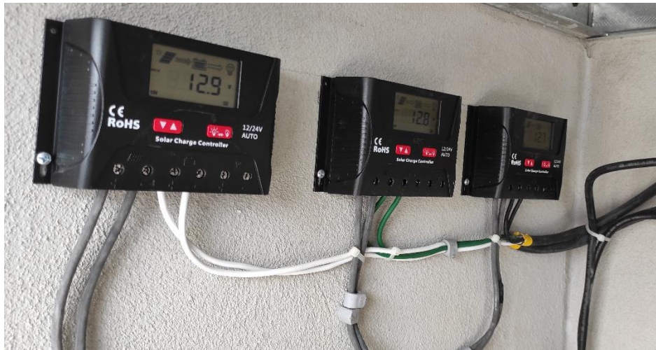
Figura 29. Controlador de carga solar.
