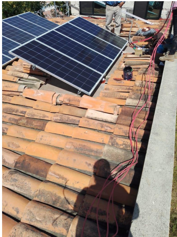
Figura 6. Mantenimiento e instalación de 4 paneles extras.
