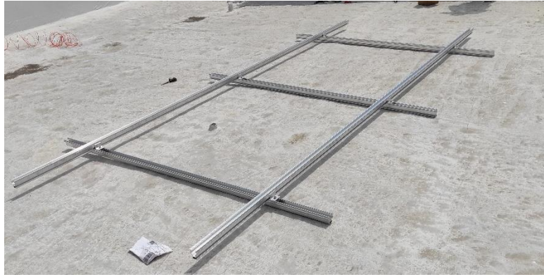
Figura 57. Organización de los rieles norte-sur sobre los rieles este-oeste.
