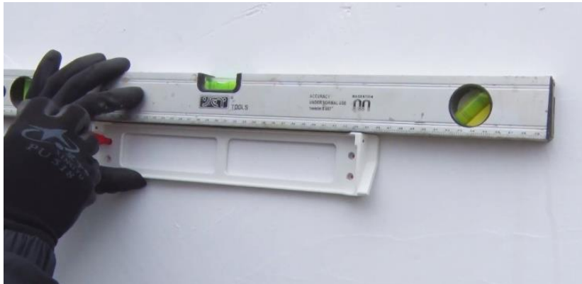
Figura 74. Nivelado de la hoja de montaje.
