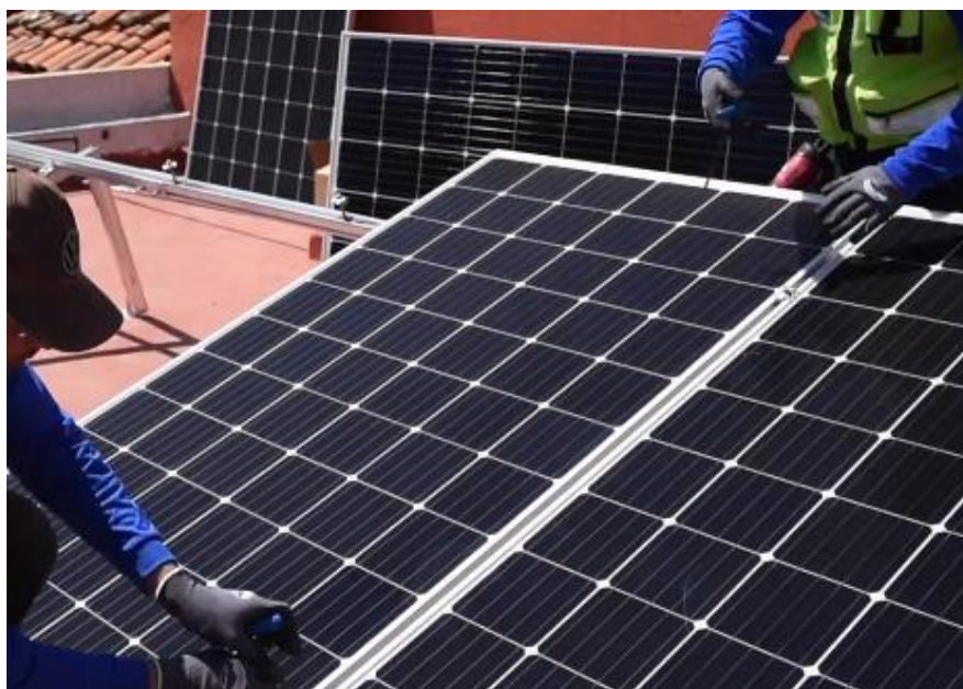
Figura 69. Montaje y sujeción de los paneles.
