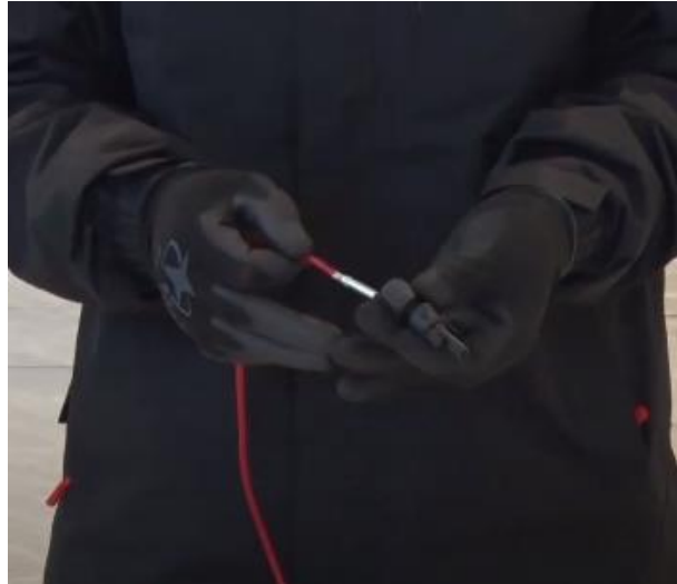
Figura 81. Colocación del conector MC4 en la terminal de metal.
