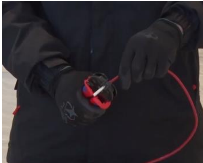
Figura 80. Ponchado de la terminal positiva (macho) en el cable fotovoltaico.
