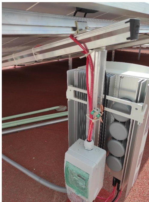
Figura 77. Montaje del gabinete.
