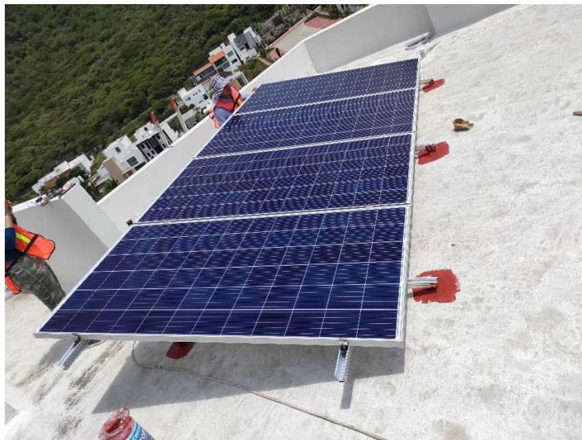
Figura 4. Instalación de 4 paneles en residencial Campanario, Querétaro.
