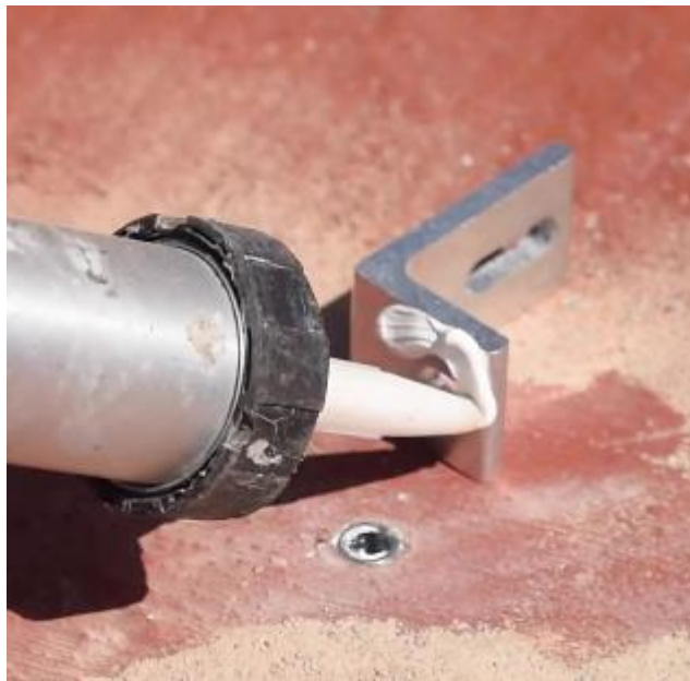
Figura 63. Aplicación del sellador en la base de la pata L.
