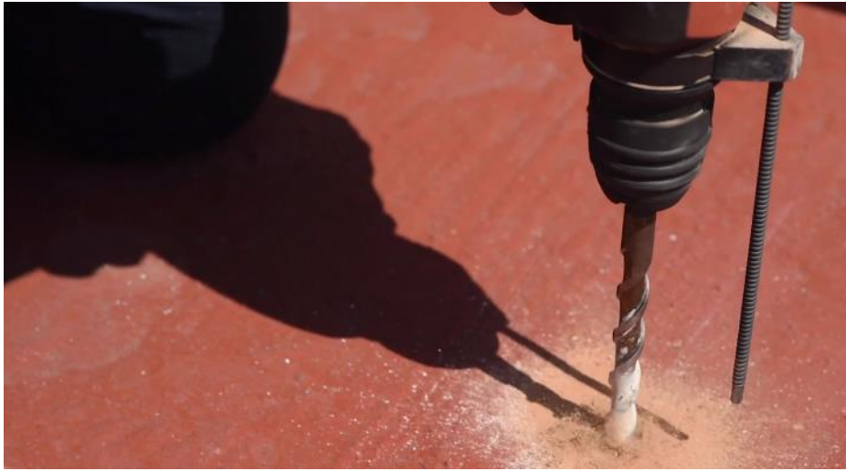
Figura 60. Perforación de la azotea.
