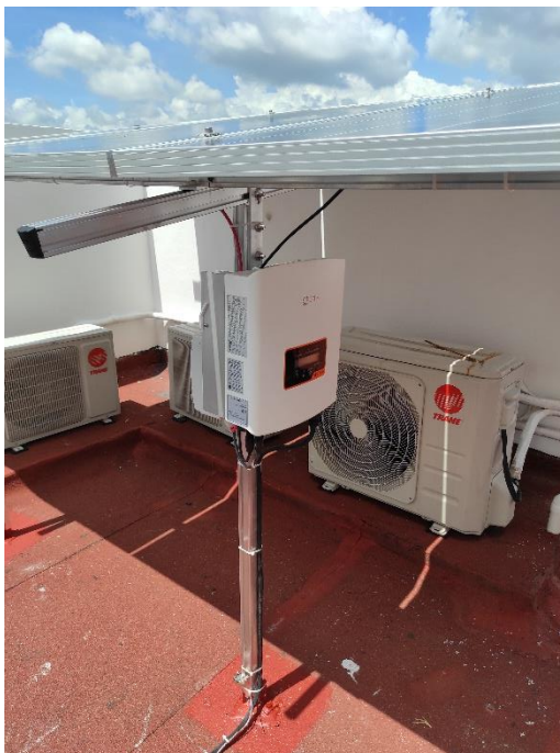
Figura 72. Montaje del inversor sobre la estructura misma.
