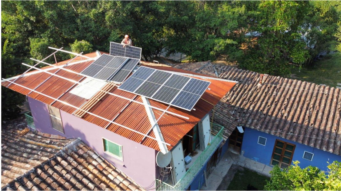
Figura 5. Instalación de 22 paneles en Papantla, Veracruz.
