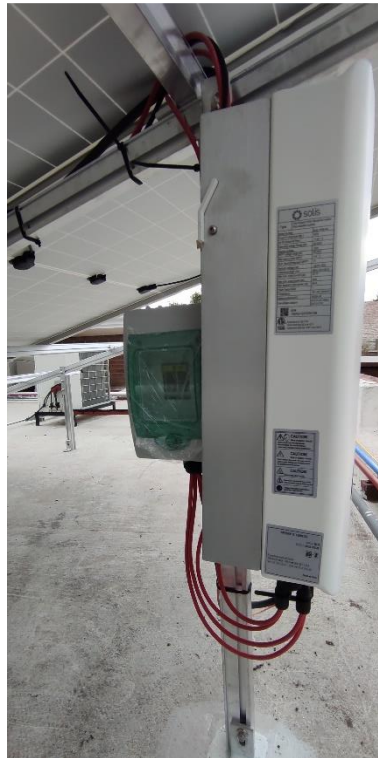
Figura 83. Resultado final del montaje y conexión del gabinete de C.D. con el inversor.
