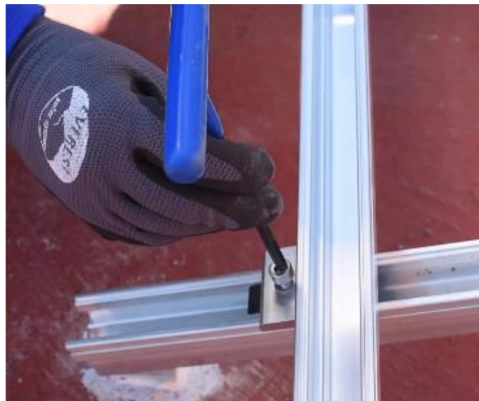
Figura 67. Unión de los rieles norte-sur y este-oeste.
