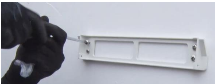
Figura 75. Atornillado de la hoja de montaje sobre el muro.
