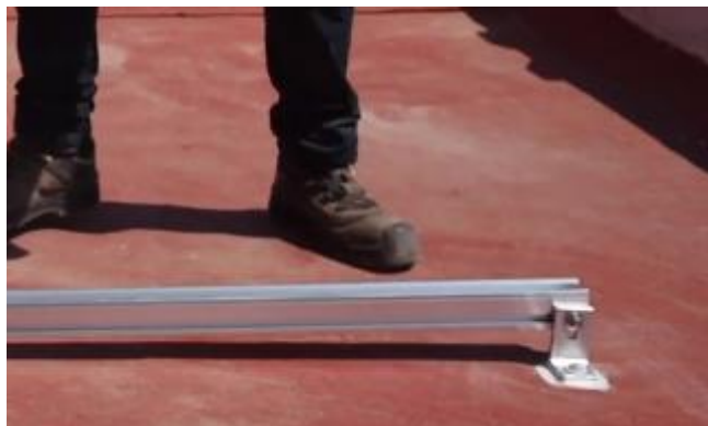
Figura 65. Colocación de los rieles norte-sur sobre las patas L.
