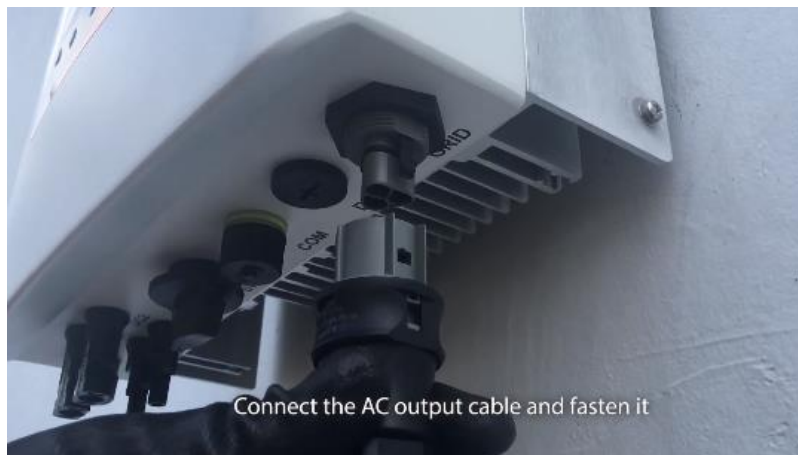
Figura 87. Conexión de la terminal de C.A. en el inversor.
