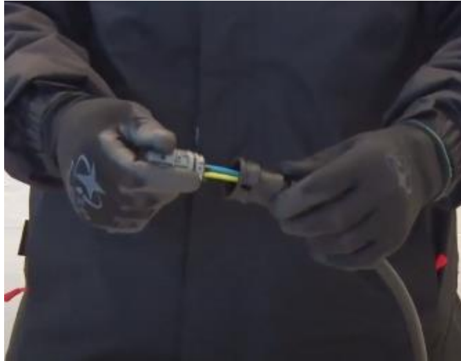
Figura 86. Armado de la terminal de C.A.
