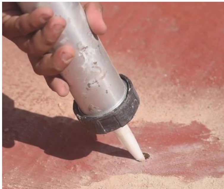
Figura 61. Aplicación del sellador en la perforación.
