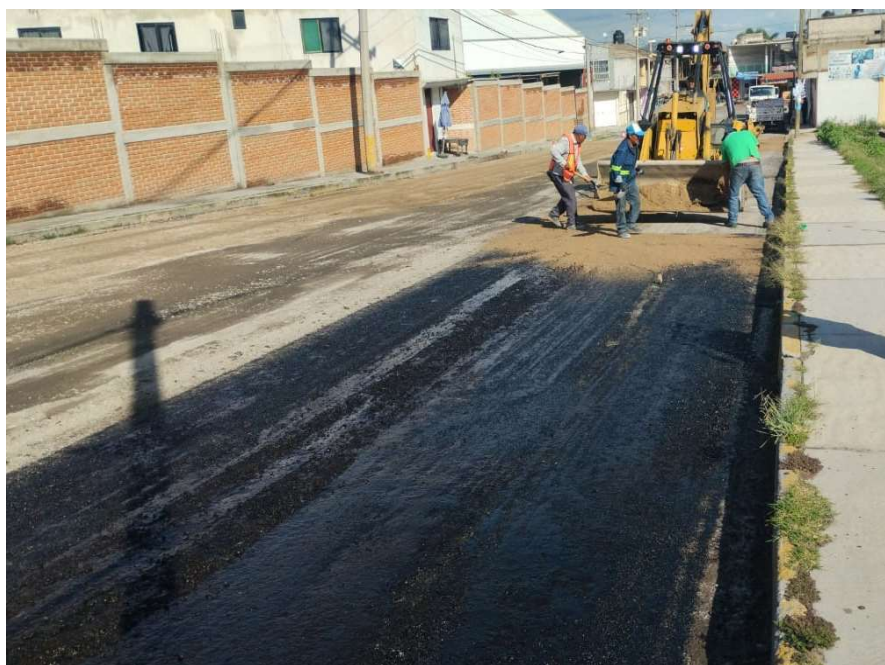
Ilustración: riego de impregnación cadenamiento 0+080
