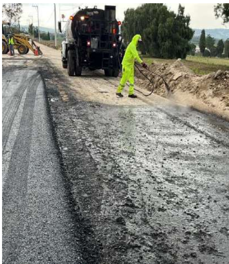
Ilustración: Suministro de riego de liga en cadenamiento 1+060
