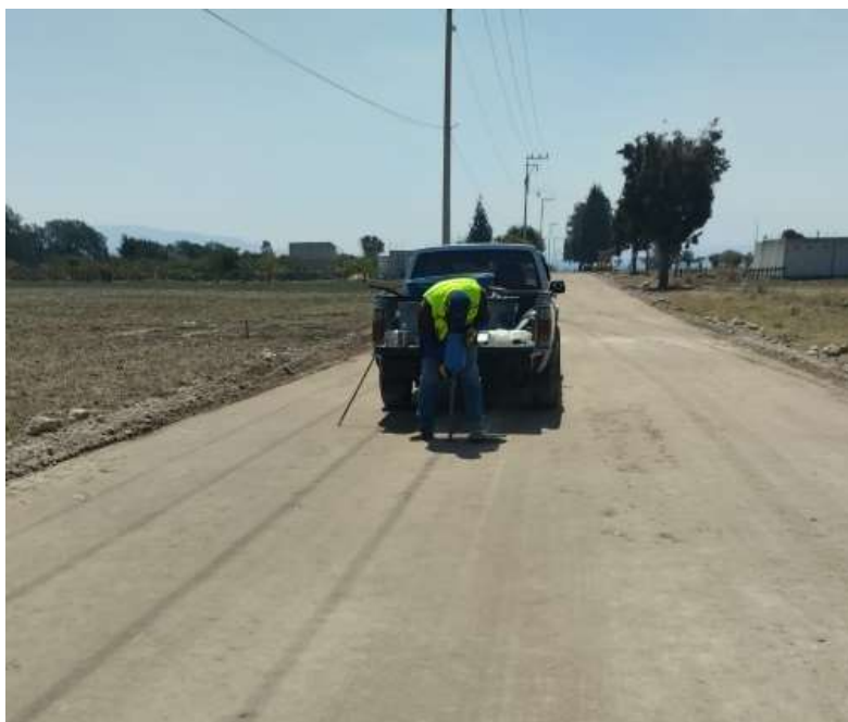
Ilustración: prueba de compactación cadenamamiento 1+840
