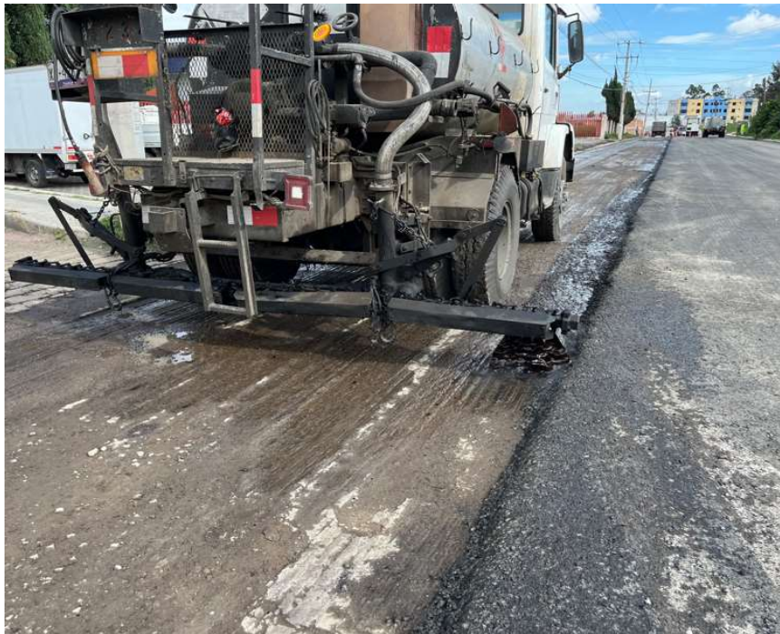
Ilustración: riego de liga cadenamiento 0+280
