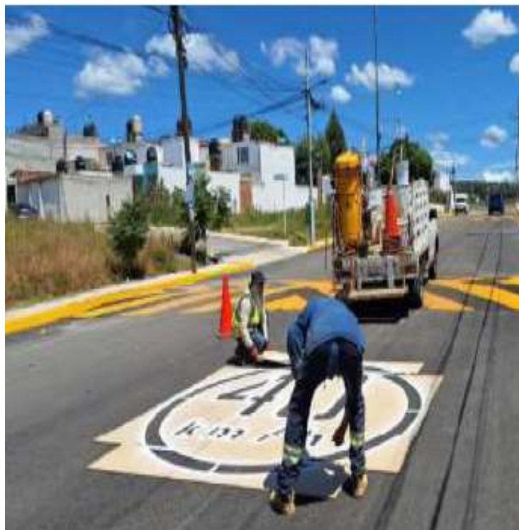
Ilustración: Señalamiento en velocidad en cadenamiento
