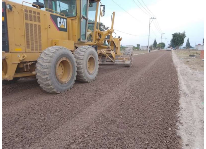
Ilustración: Tendido de base hidráulica
