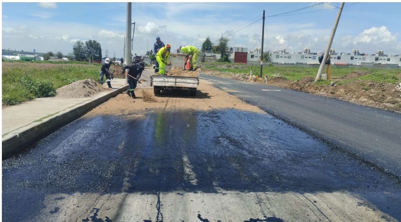
Ilustración: riego de impregnación cadenamiento 0+500
