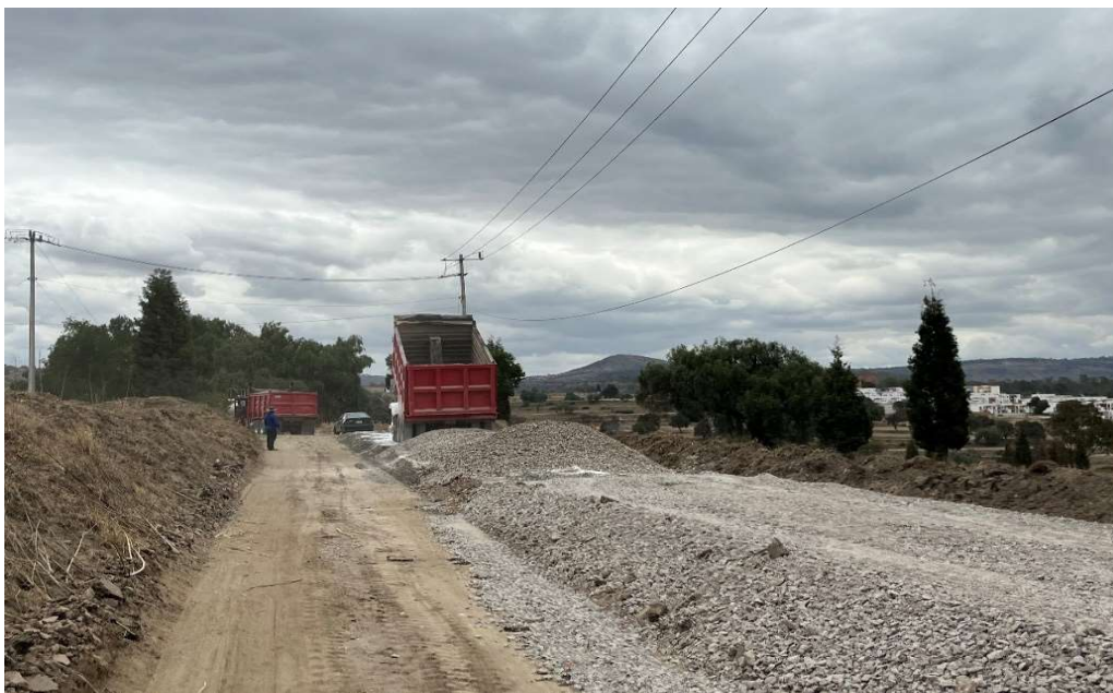
Ilustración: mezclado de materiales cadenamiento 1+420
