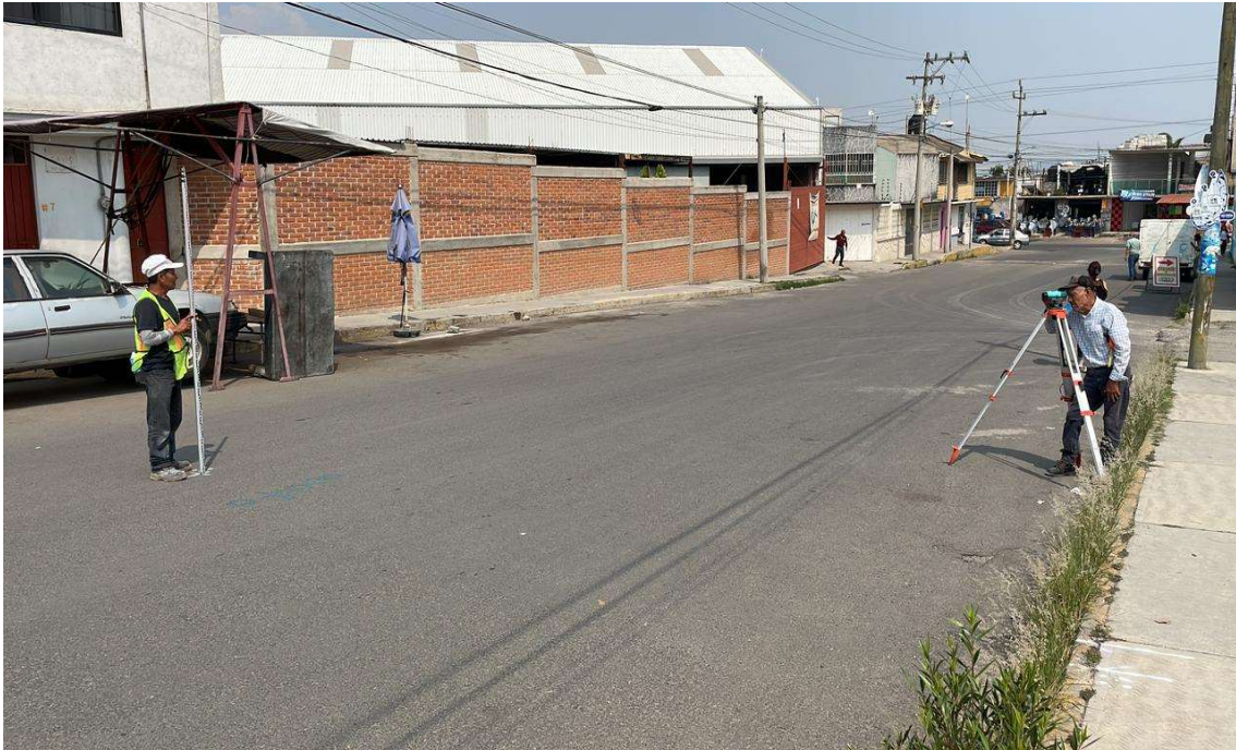
Ilustración: Levantamiento Topográfico en cadenamiento 0+080
