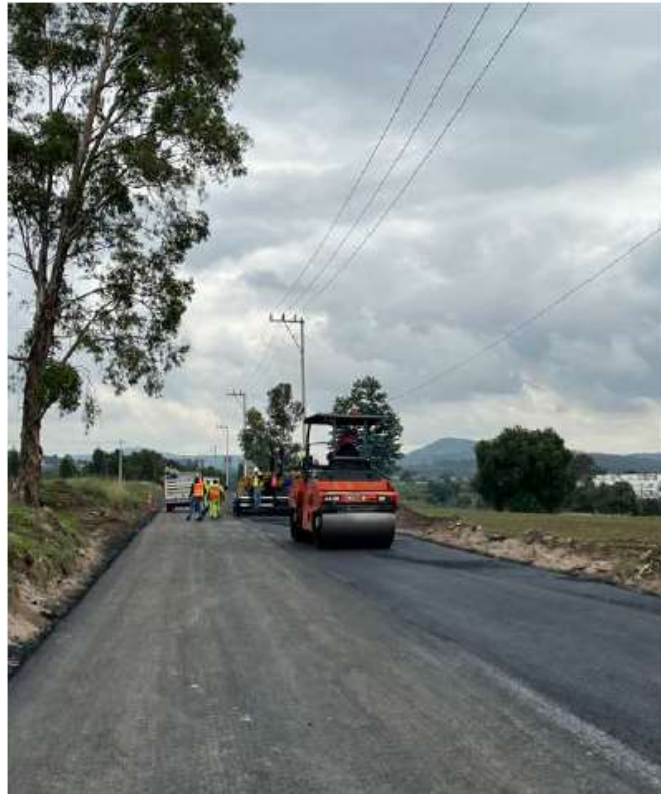
Ilustración: Compactación de carpeta asfáltica
