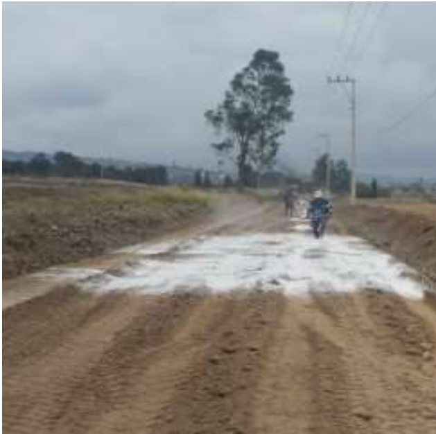
Ilustración: incorporación de cal cadenamiento 1+360
