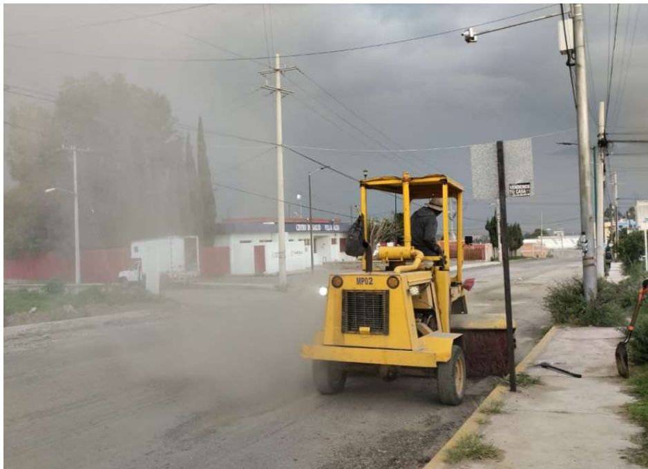
Ilustración: Barrido de superficie en cadenamiento 0+220
