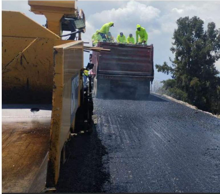
Ilustración: tendido de carpeta asfáltica cadenamiento 0+860
