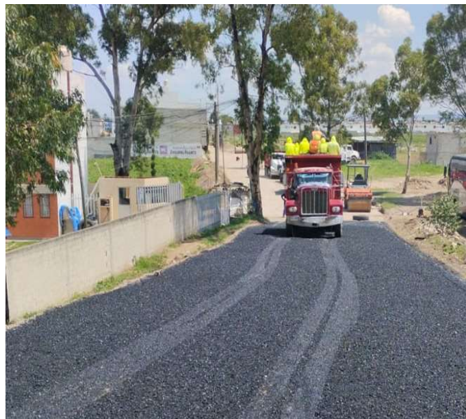
Ilustración: tendido de carpeta asfáltica cadenamiento 0+760
