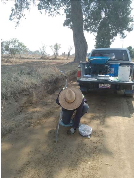
Ilustración: Cala para prueba de laboratorio
