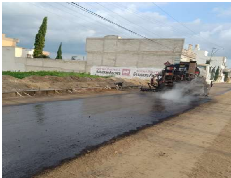
Ilustración: suministro de riego de liga cadenamiento 0+620
