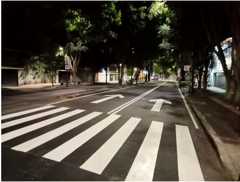
Figura 35 Balizamiento terminado de una vialidad, FRAGUA INGENIEROS
