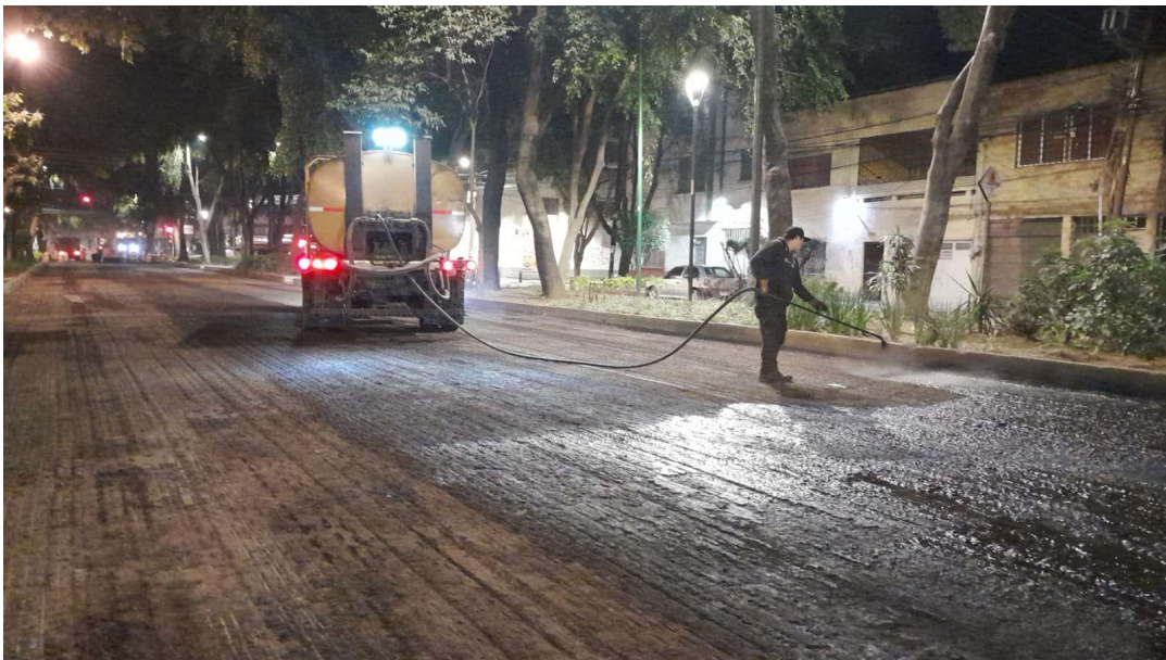
Figura 17 Aplicación de riego de liga con petrolizadora, FRAGUA INGENIEROS
