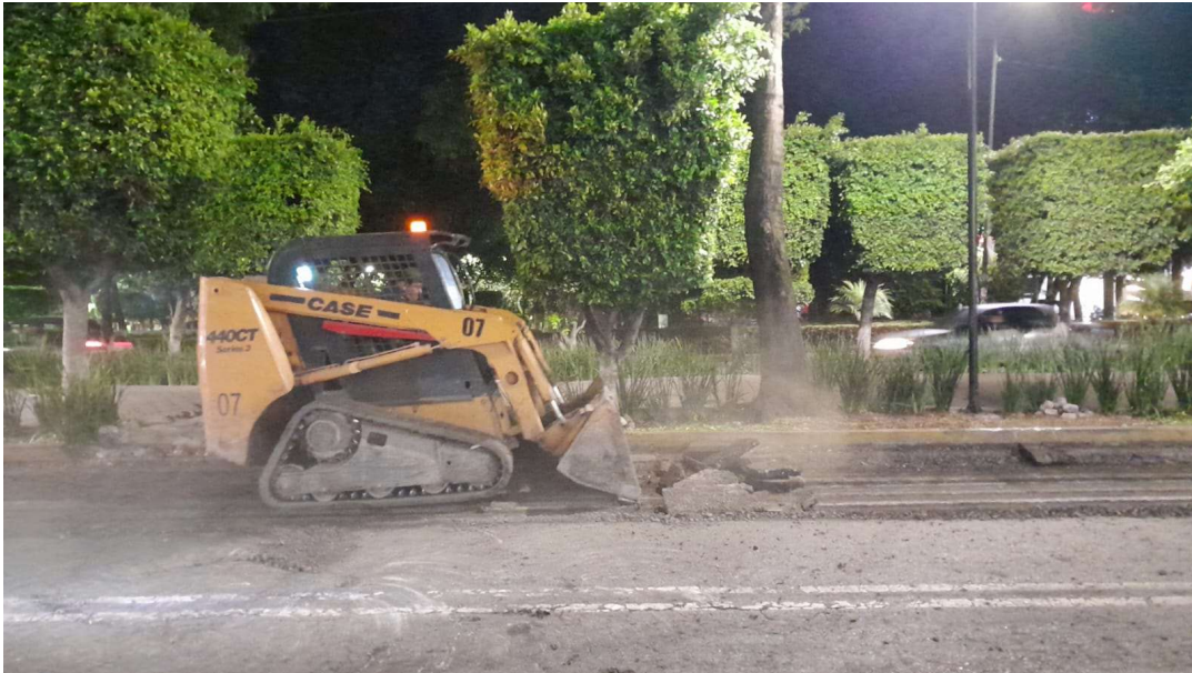
Figura 15 Retiro de carpeta asfáltica con minicargador, FRAGUA INGENIEROS
