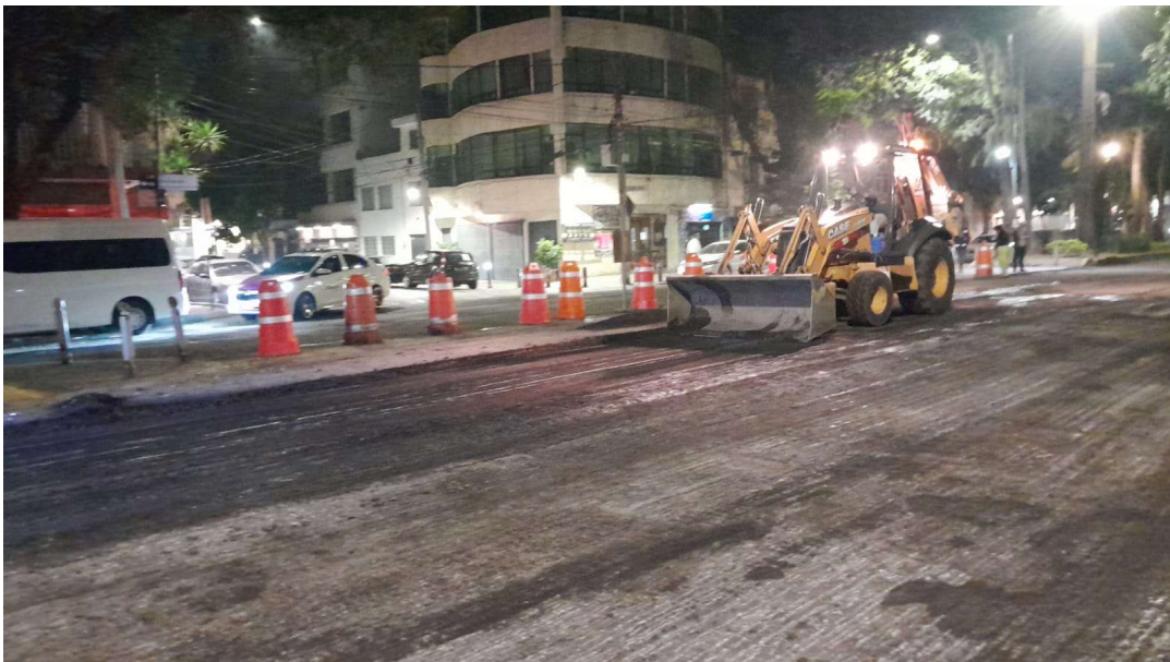
Figura 16 Retiro de materia con retroexcavadora, FRAGUA INGENIEROS
