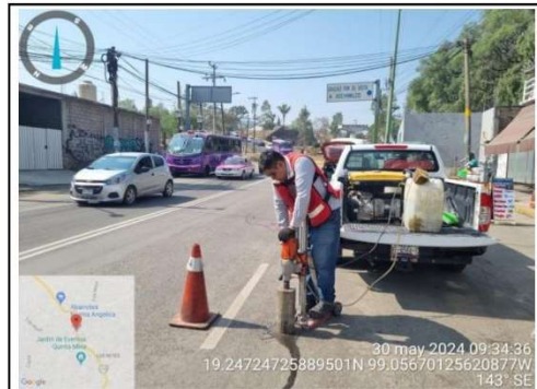
Fig. 6. Extracción de núcleo para verificación de espesor y compactación en Av. Cuauhtémoc
