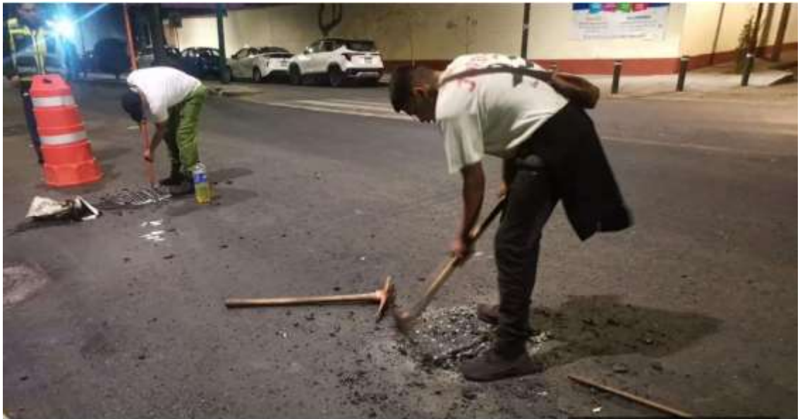
Figura 24 Limpieza de brocales, FRAGUA INGENIEROS
