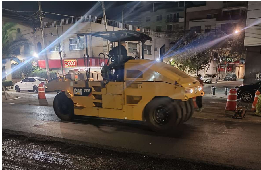
Figura 23 Compactación con rodillos neumáticos, FRAGUA INGENIEROS
