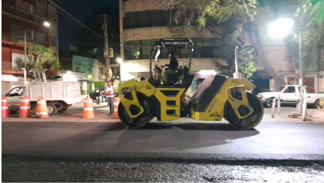
Figura 22 Compactación inicial, FRAGUA INGENIEROS
