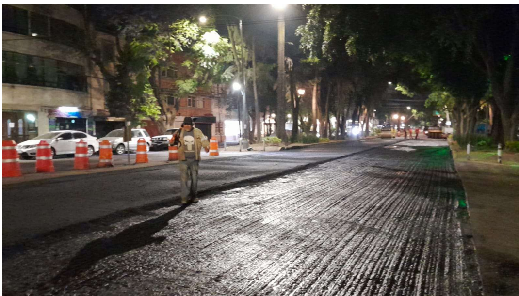
Figura 18 Riego de liga aplicado en una vialidad, FRAGUA INGENIEROS
