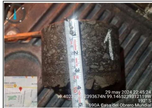
Fig. 2. Extracción de núcleo para verificación de espesor y compactación en Casa del obrero mundial
