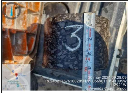
Fig. 5. Extracción de núcleo para verificación de espesor y compactación en Av Cuauhtémoc
