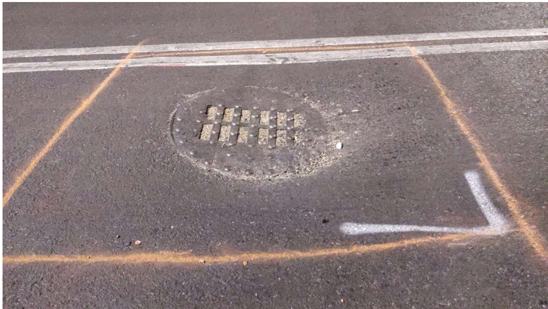
Figura 26 Delimitación del brocal, FRAGUA INGENIEROS
