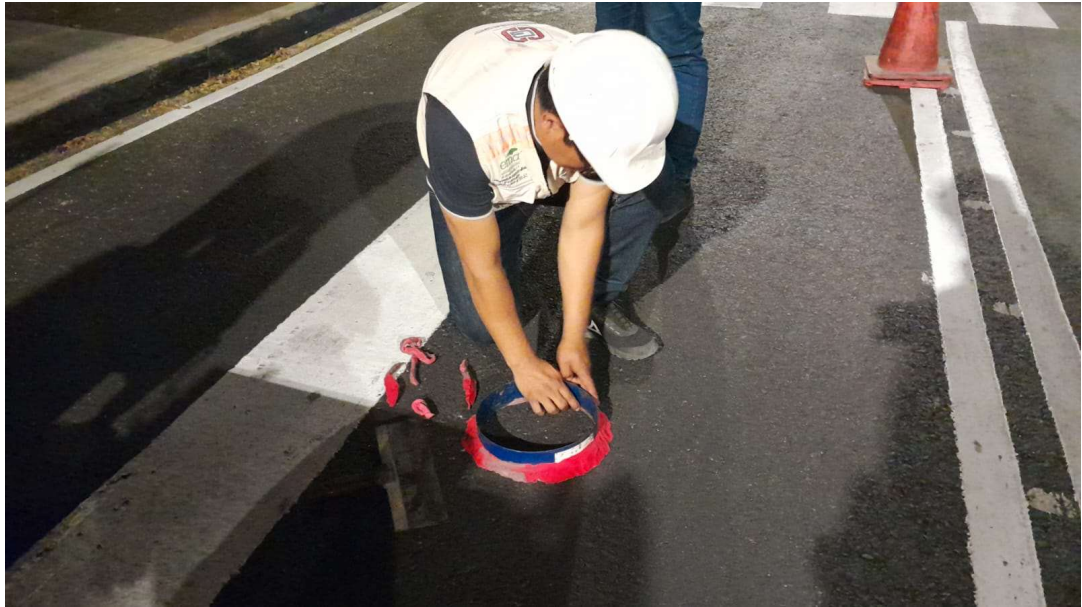
Figura 62 Colocación de masilla para cierre hermético, FRAGUA INGENIEROS
