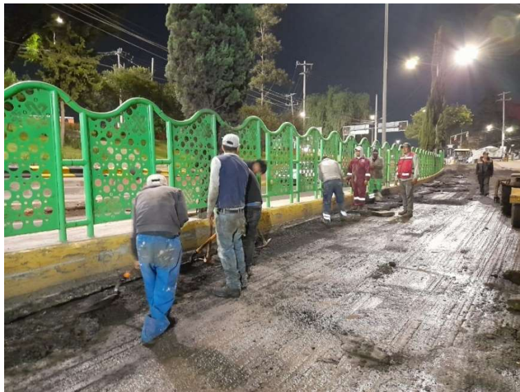
Figura 13 Retiro y demolición de ceja, FRAGUA INGENIEROS
