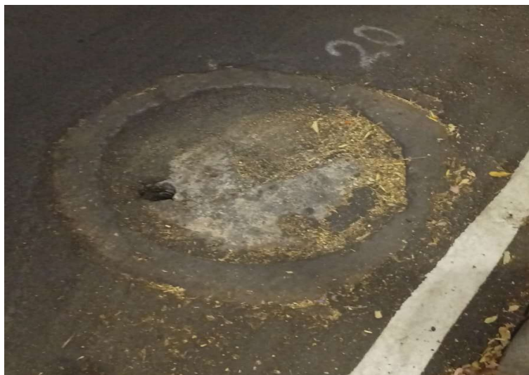
Figura 9 Tapa ubicada y marcada, FRAGUA INGENIEROS
