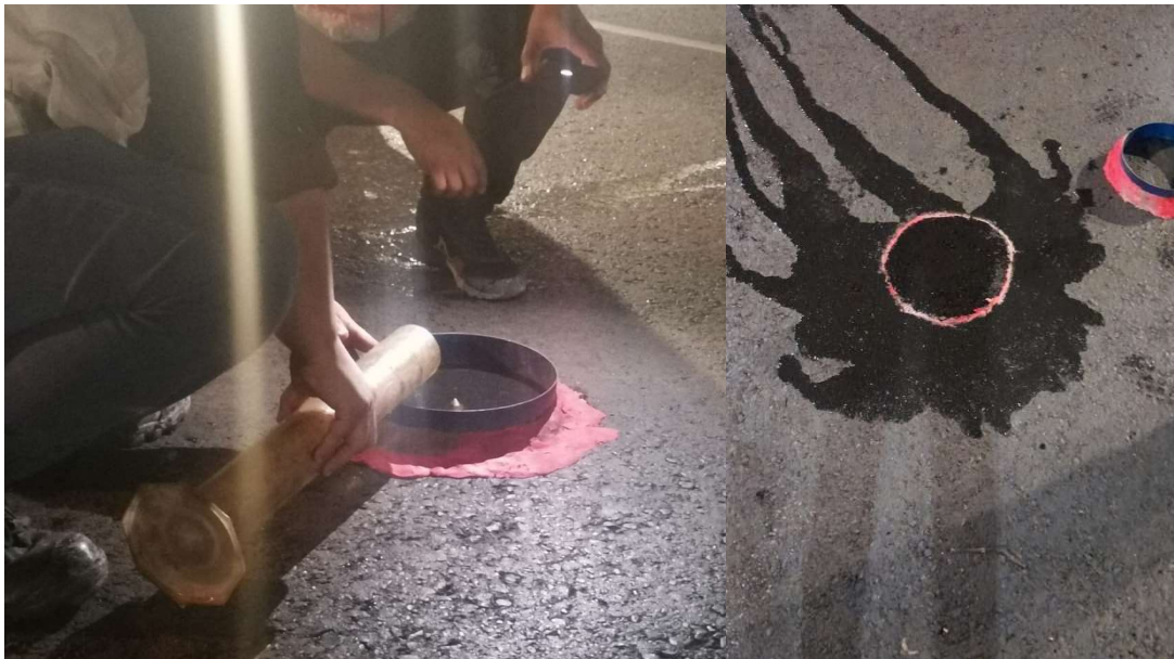
Figura 63 Realización de prueba de permeabilidad
