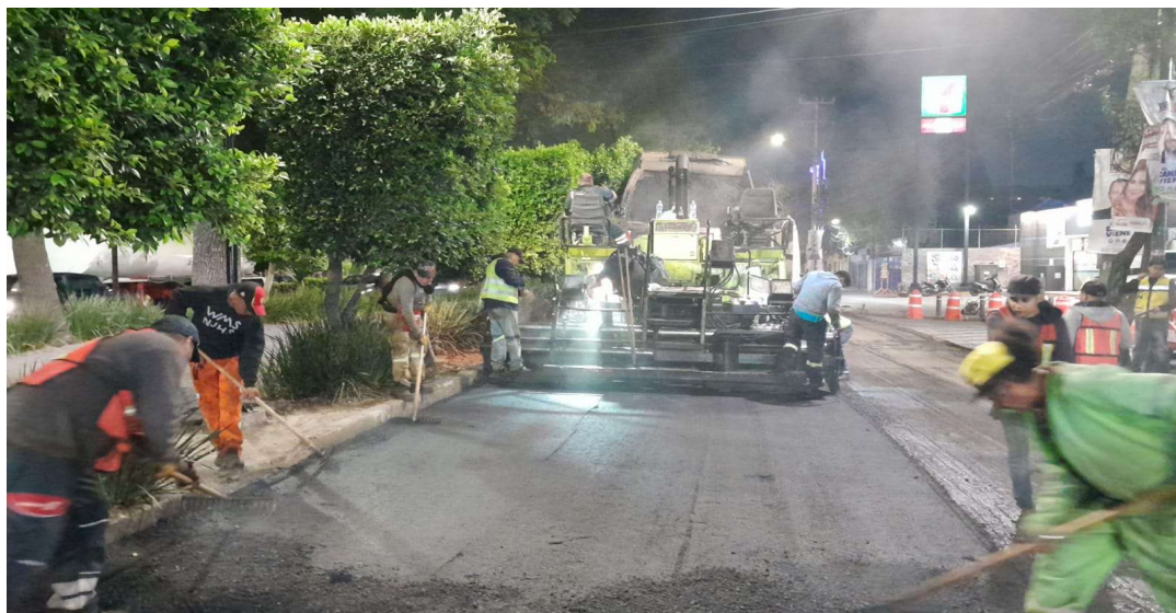
Figura 21 Colocación de mezcla asfáltica, FRAGUA INGENIEROS
