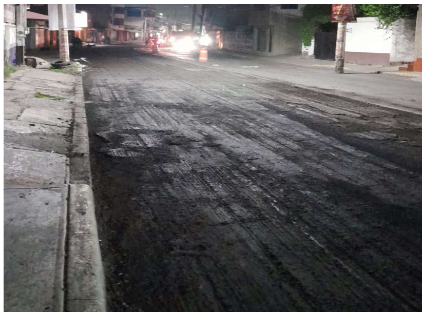
Figura 12 Vialidad fresada, FRAGUA INGENIEROS
