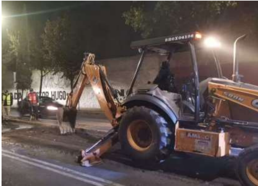
Figura 48 Retroexcavadora, FRAGUA INGENIEROS
