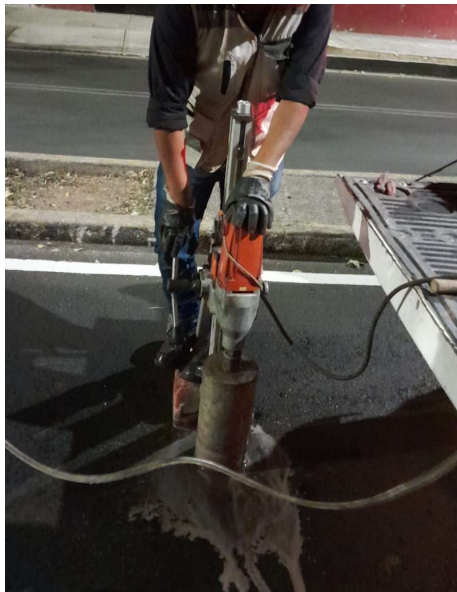
Figura 60 Extracción de corazones, FRAGUA INGENIEROS
