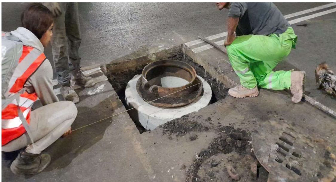
Figura 28 Colocación del brocal a la altura de la vialidad, FRAGUA INGENIEROS
