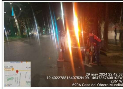
Fig. 1. Extracción de núcleo para verificación de espesor y compactación en Casa del obrero mundial
