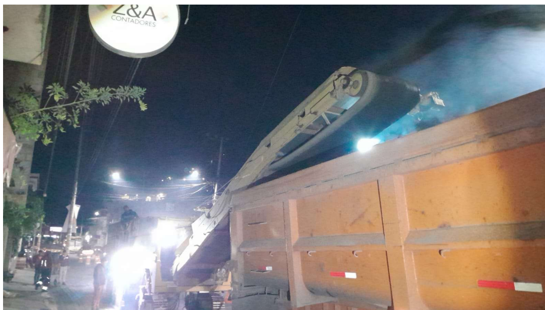
Figura 10 Banda sin fin de la perfiladora, FRAGUA INGENIEROS
