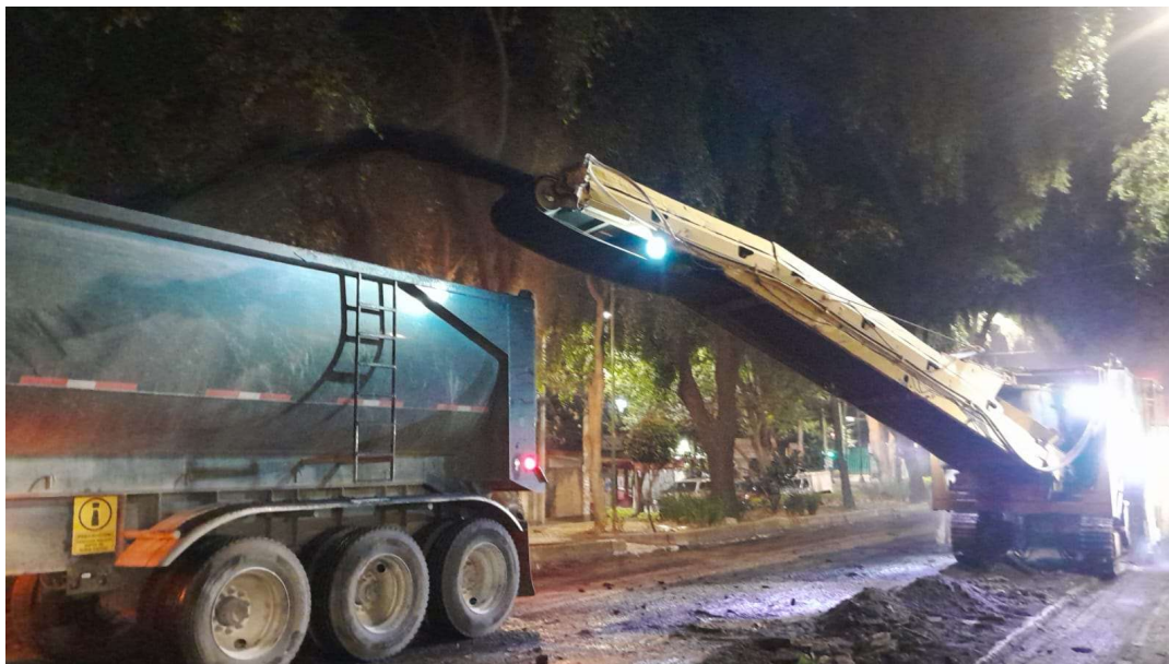
Figura 11 Operación de la fresadora, FRAGUA INGENIEROS
