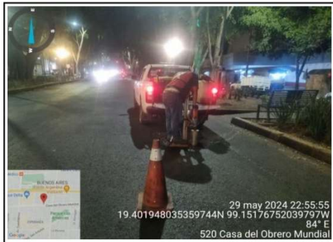
Fig. 3. Extracción de núcleo para verificación de espesor y compactación en Casa del obrero mundial
