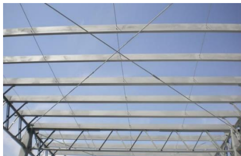
Ilustración 11. Contraventeos en cubierta. Fuente: Acero
