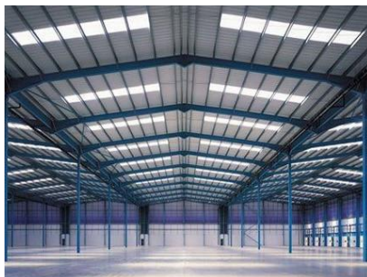
Ilustración 5. Nave industrial. Fuente: IPASA
