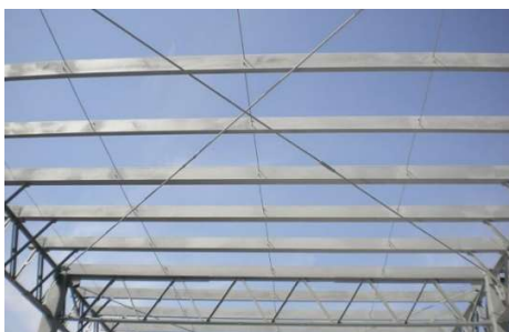
Ilustración 11. Contraventeos en cubierta. Fuente: Acero
