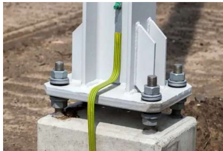
Ilustración 14. Placa base. Fuente: Aceros crea
