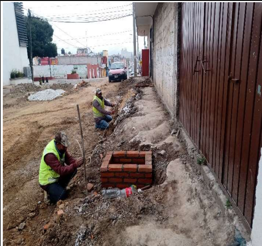
UBICACION: KM 0+020 VISTA AL LADO IZQUIERDO LA CALZADA CALLE 16 DE SEPTIEMBRE DESCRIPCION: SE REALIZAN TRABAJOS DE CONSTRUCCION DE GUARNICIONES
