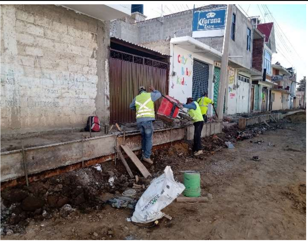
UBICACION: KM 0+020 VISTA AL LADO IZQUIERDO LA CALZADA CALLE 16 DE SEPTIEMBRE DESCRIPCION: SE REALIZAN TRABAJOS DE RELLENO Y COMPACTADO EN BANQUETAS
