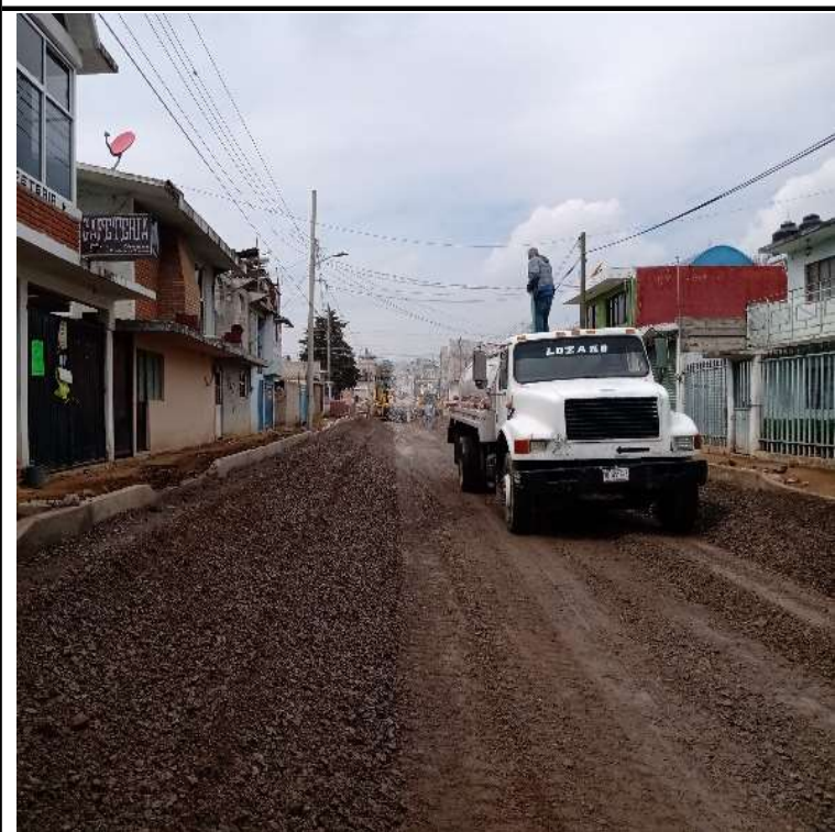
UBICACION: KM 0+060 VISTA AL CENTRO DE LA CALZADA CALLE 16 DE SEPTIEMBRE DESCRIPCION: SE REALIZAN TRABAJOS DE COLOCACION DE BASE HIDRAULICA
