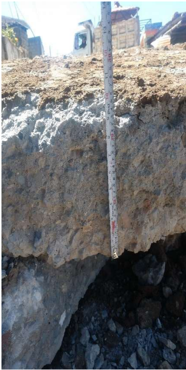
Ilustración 3. Demolición de piso de concreto
