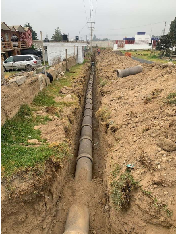
Ilustración 17 tendido de tubo
