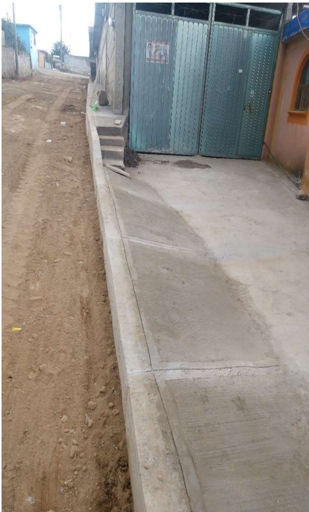
Ilustración 12 vaciado de concreto
