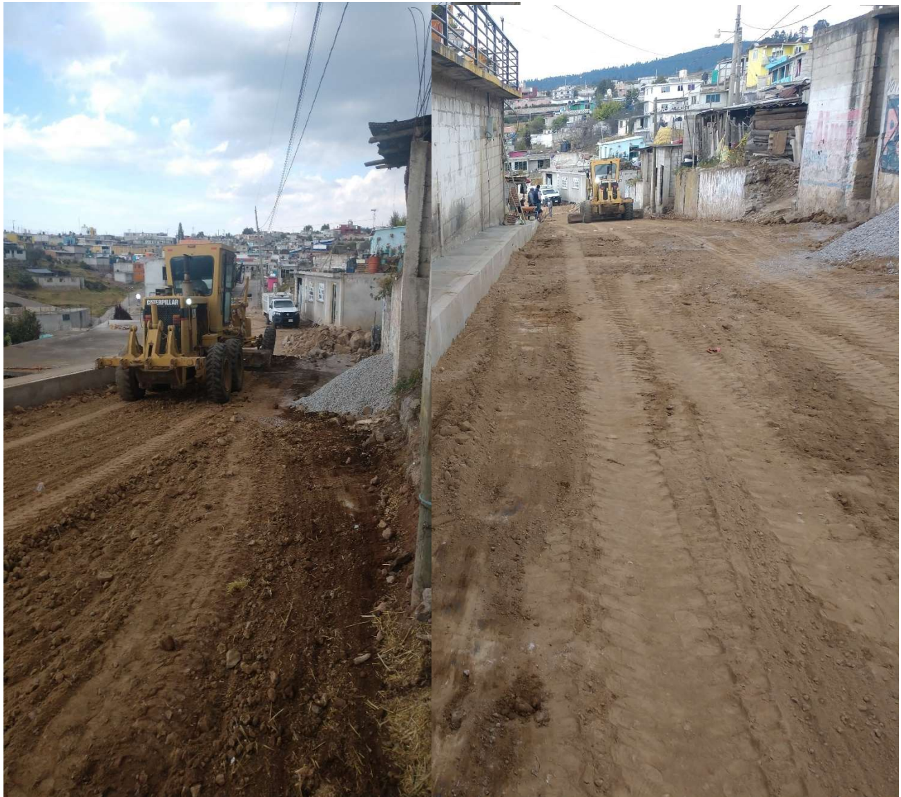
Ilustración 4 excavación en cortes.
