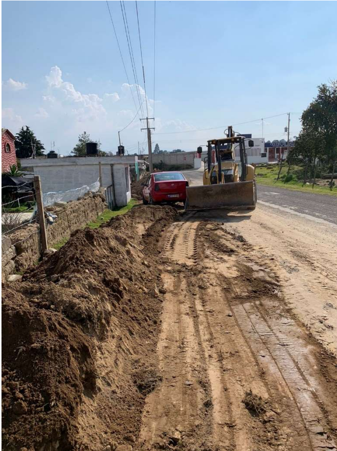
Ilustración 24 limpieza de la obra
