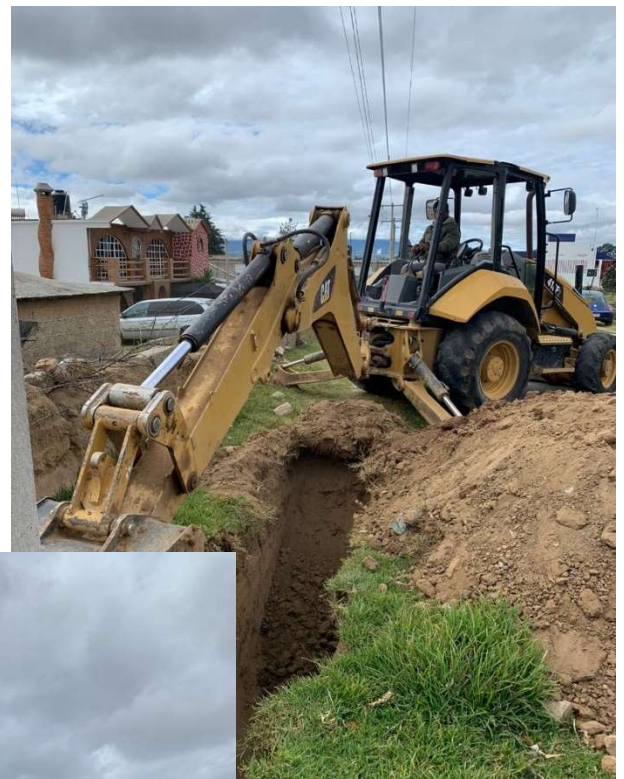
Ilustración 14.1 excavación en zanja
