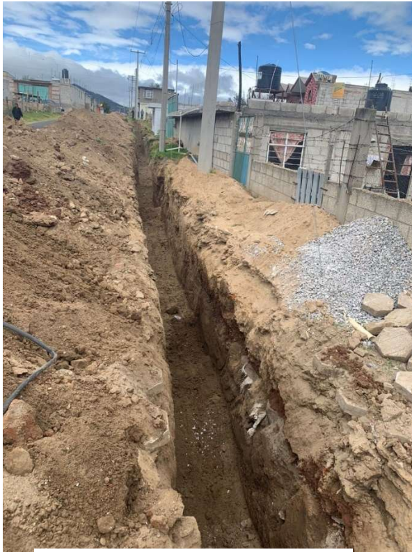
Ilustración 14 excavación en zanja
