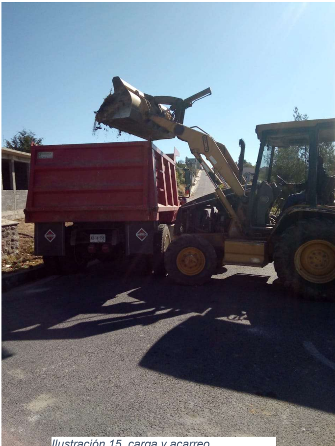
Ilustración 15 carga y acarreo
