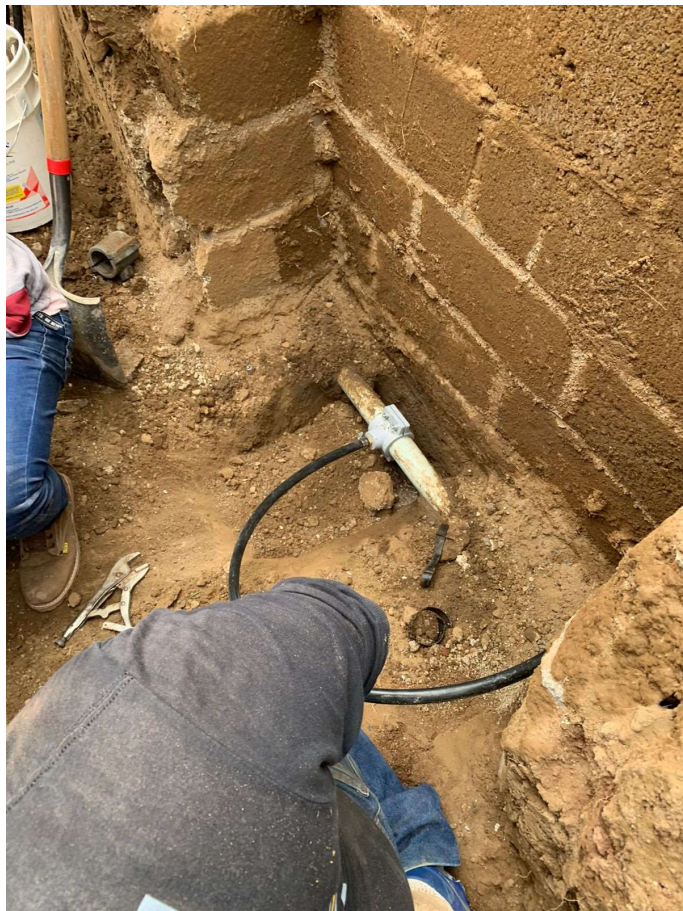
Ilustración 21 reparacion de toma de agua
