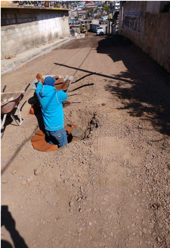
Ilustración 9 renivelación de pozos de visita
