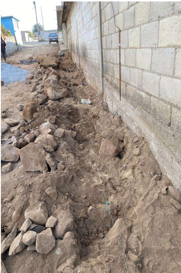
Ilustración 7. Excavación en zanja
