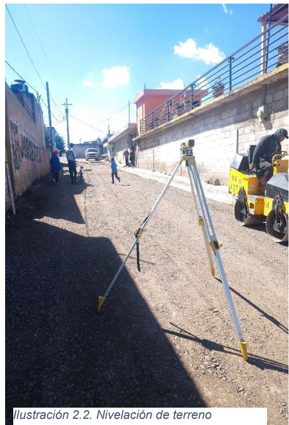
Ilustración 2. Trazo del terreno para quarnición.
