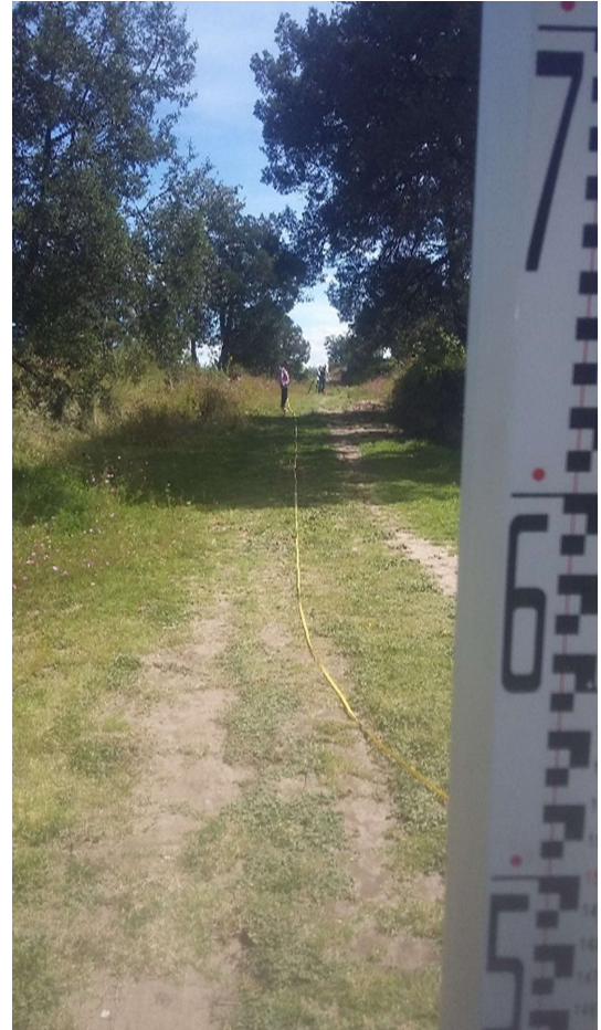
Ilustración 13.1 trazo y nivelación
