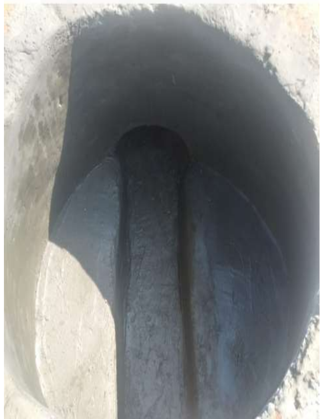
Ilustración 18.1 media caña en pie de pozo
