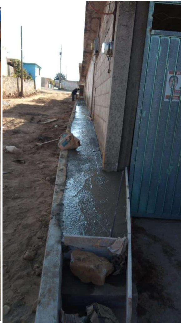
Ilustración 12.1 vaciado de concreto
