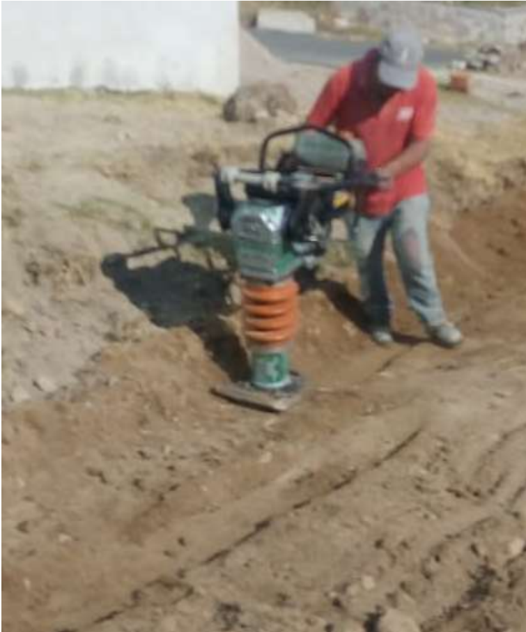
Ilustración 23 compactado de tepetate
