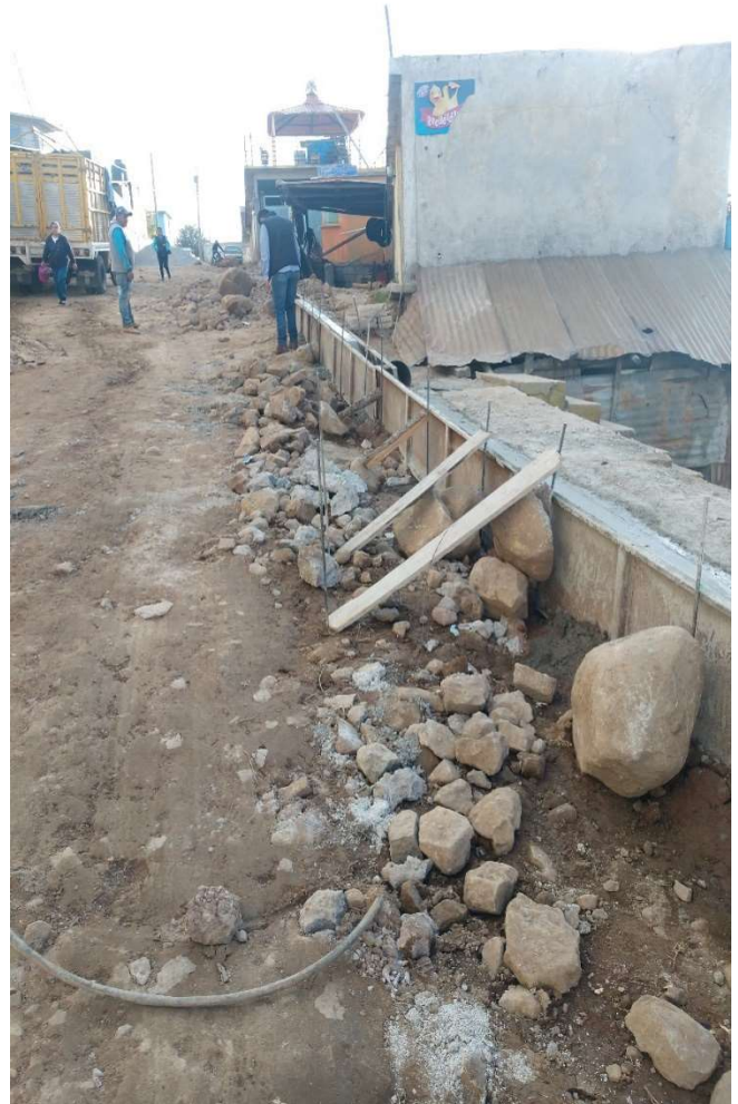
Ilustración 8.1 construcción de guarnición
