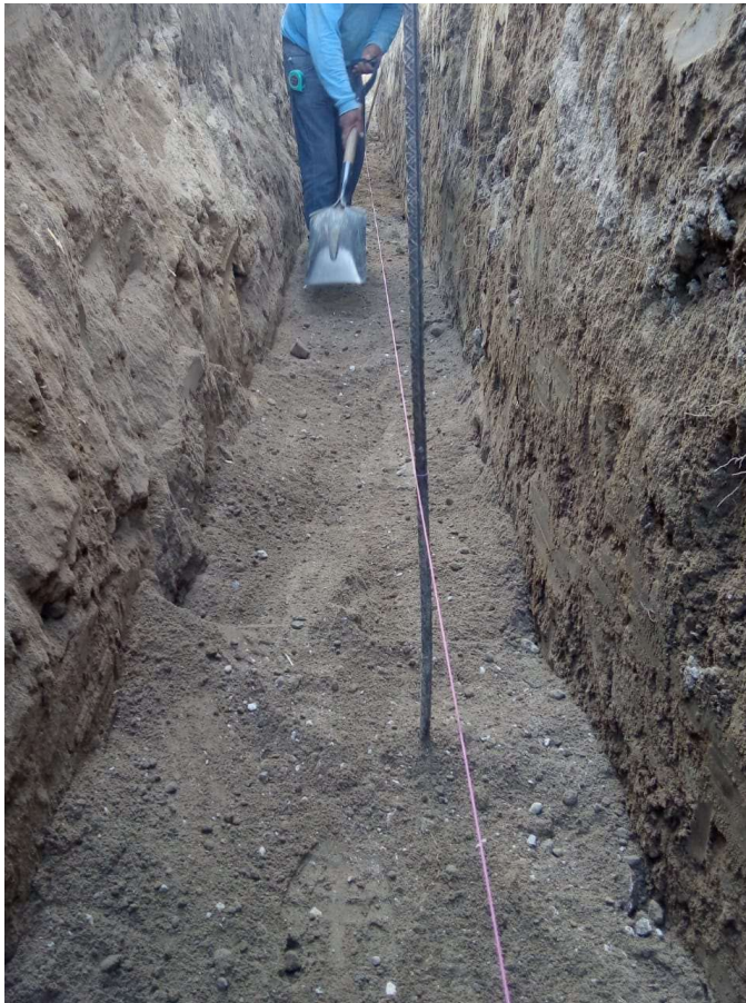
Ilustración 16 afine de cama de arena
