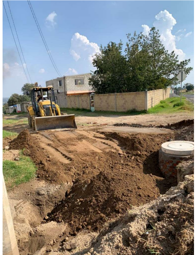
Ilustración 23.1 relleno de tepetate
