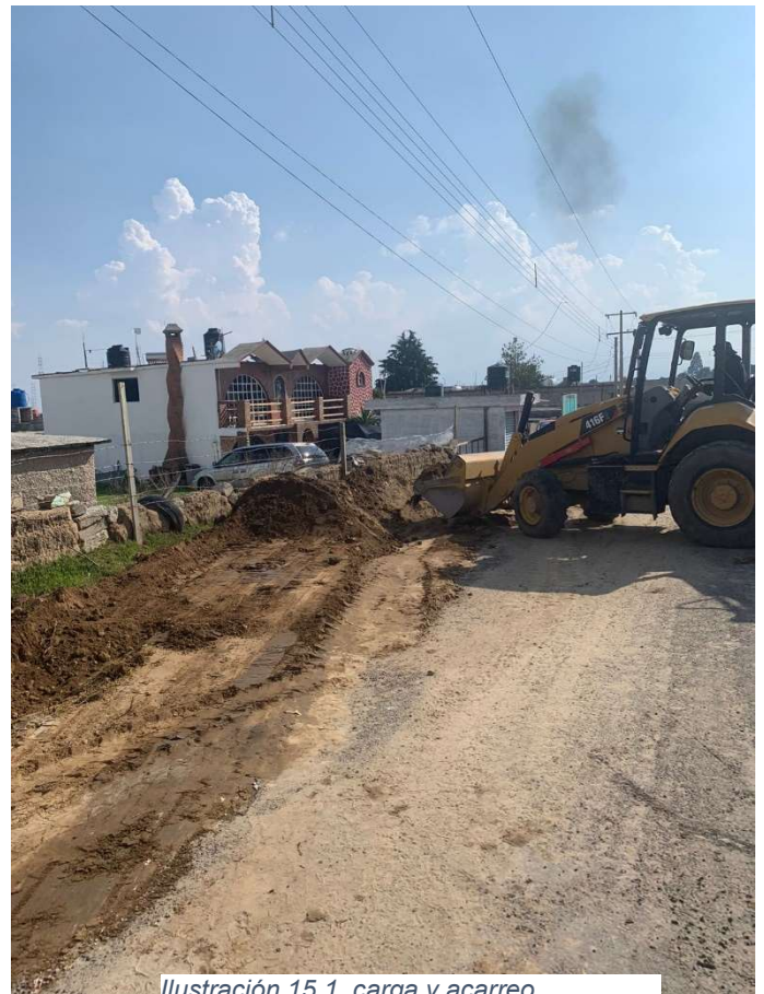
Ilustración 15.1 carga y acarreo
