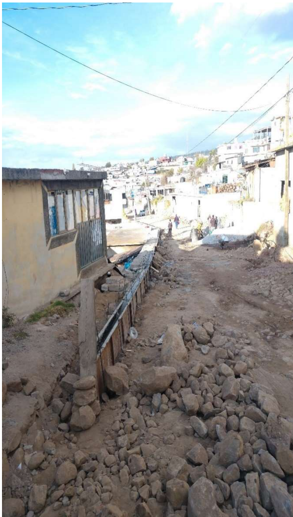
Ilustración 8 construcción de guarnición
