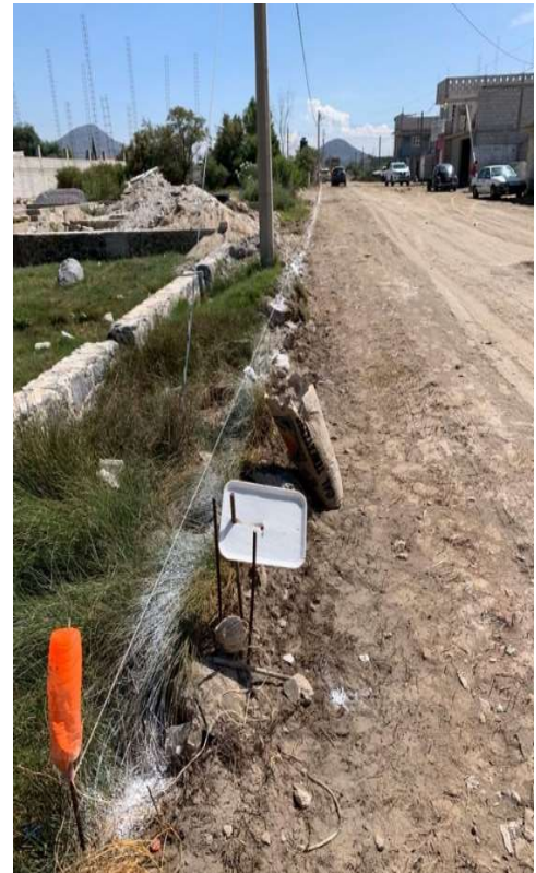
Ilustración 2. Trazo del terreno para quarnición.
