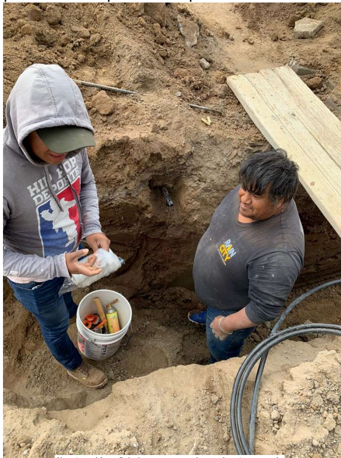
Ilustración 21.1 reparacion de toma de agua
