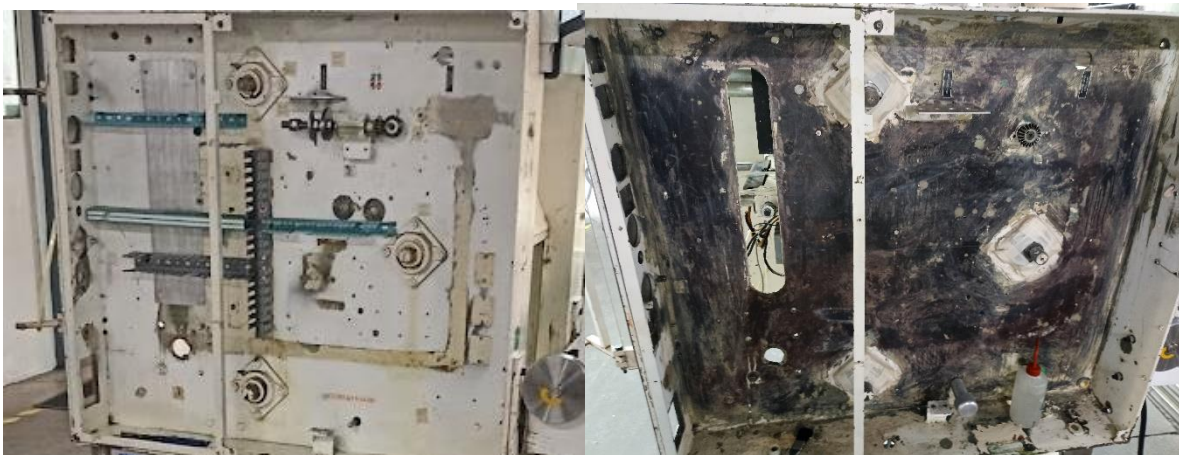
Figura 35 Estado Original y Estado una vez desmantelados los componentes inservibles
