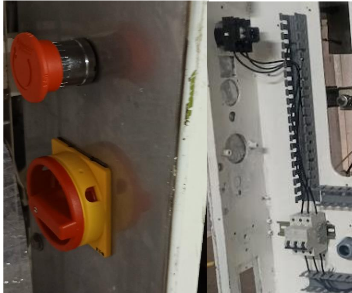
Figura 38 instalación de interruptores
