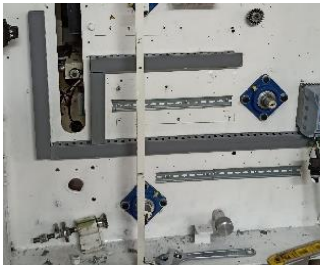
Figura 37 Proceso de colocación de riel DIN y Canaleta eléctrica
