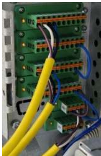
Ilustración 71 Conexiones de alimentación, salidas y entradas
