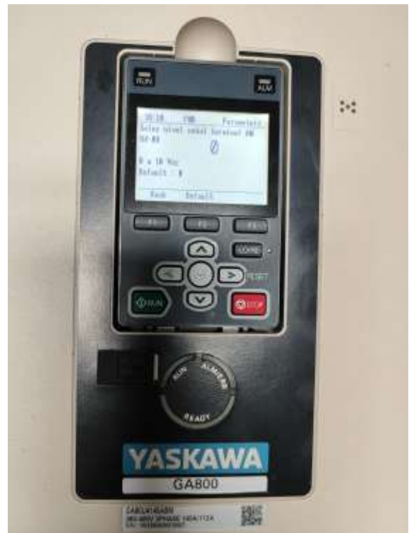
FIGURA 74 H4-08 Nivel señal terminal FM (Autoría Propia, 2023)
