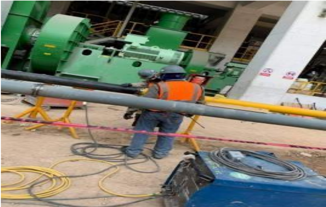
Figura 24: Habilitación de soldadura
