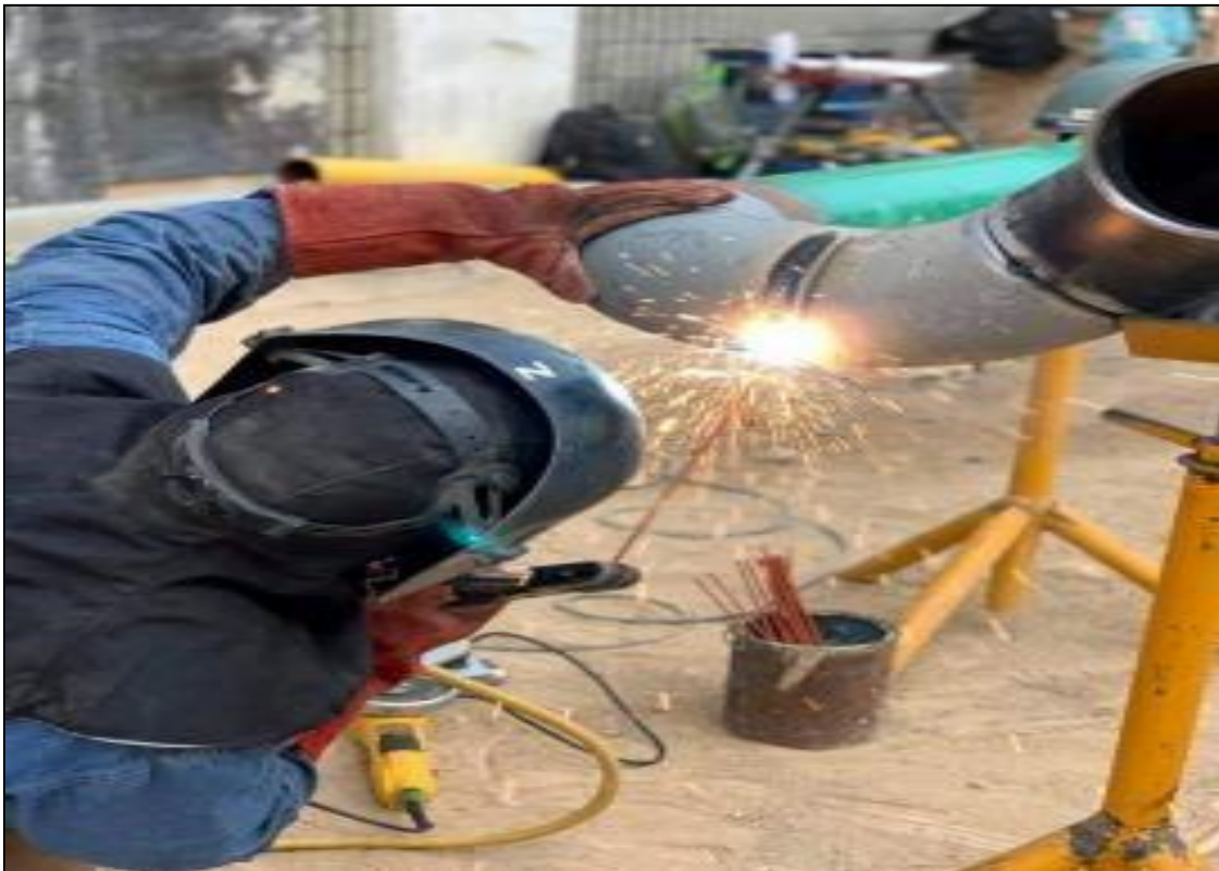
Figura 23: Soldadura de codos y ubicación
