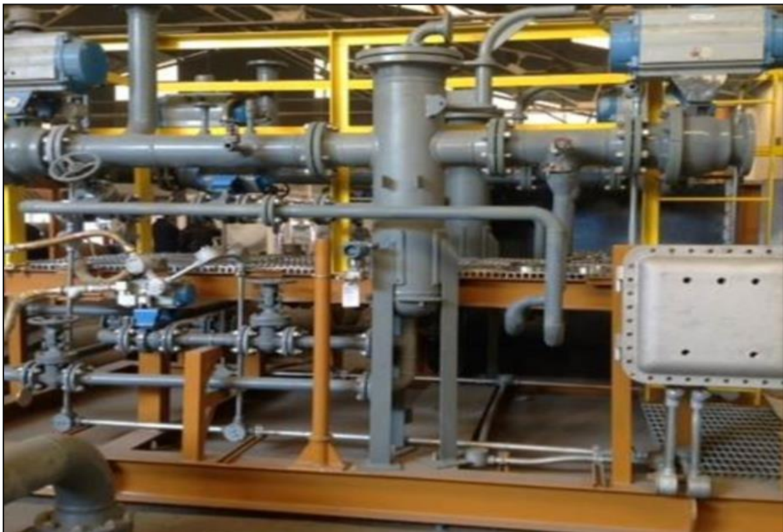
Figura 25: Armado y montado de (DTI) en patín
